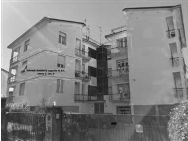
ESTERNO – altra foto da via IV Novembre della palazzina (condominio [REDACTED]) con indicazione nel poligono rosso della localizzazione dell'appartamento (2° piano) e dell'accesso box auto (piano terreno) oggetto di E.I. (LOTTO UNICO)
