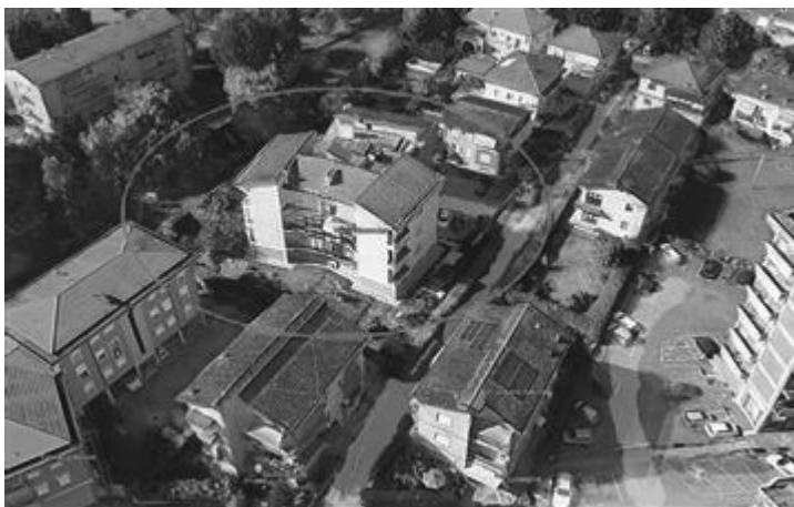
ESTERNO - foto dall'alto a volo d'uccello con indicazione nel circoletto della palazzina (condominio [REDACTED]) ove sono localizzati l'appartamento, la cantina e il box auto oggetto di E.I. (LOTTO UNICO) – fonte: google earth
