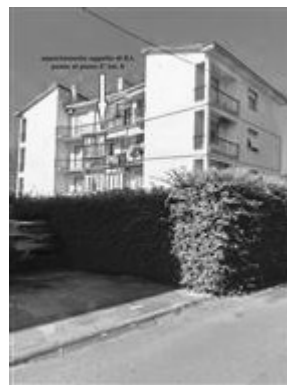
ESTERNO – foto da via IV Novembre della palazzina (condominio [REDACTED]) con indicazione nel poligono rosso della localizzazione dell'appartamento (piano secondo) oggetto di E.I. (LOTTO UNICO)
