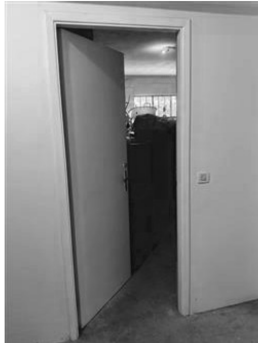
INTERNO CANTINA - piano terreno – vista della porta di ingresso al locale CANTINA oggetto di E.I. – accessibile dal percorso corridoio comune
