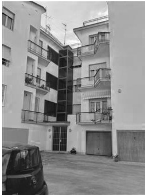
ESTERNO BOX AUTO – piano terreno - vista sull'accesso al BOX AUTO (a mezzo di porta basculante), accessibile carrabilmente dalla corte comune condominiale; in altro, a sinistra, con perimetro rosso viene indicato l'appartamento (2° piano) oggetto di E.I
