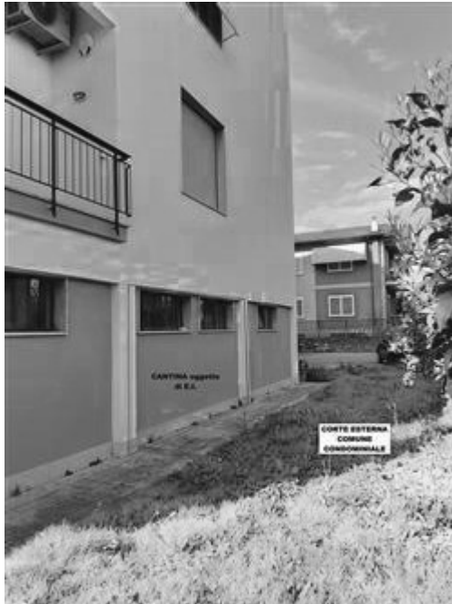
ESTERNO CANTINA - piano terreno – vista sulle finestre del locale CANTINA oggetto di E.I., prospettanti sulla corte comune condominiale lato sud est
