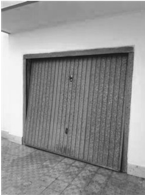
ESTERNO BOX AUTO – piano terreno – vista della porta basculante che consente l'accesso carrabile al BOX AUTO oggetto di E.I.
