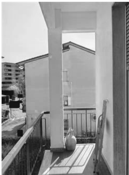
ESTERNO APPARTAMENTO - piano secondo - vista del terrazzo (esposto a sud est) accessibile dalla CAMERA 3
