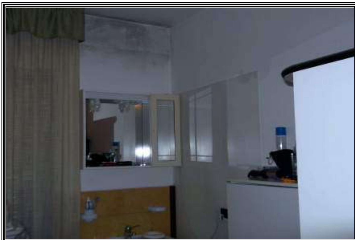
FOTOGRAFIA n. 6 – “Unità 1” (Piano Terra) -
