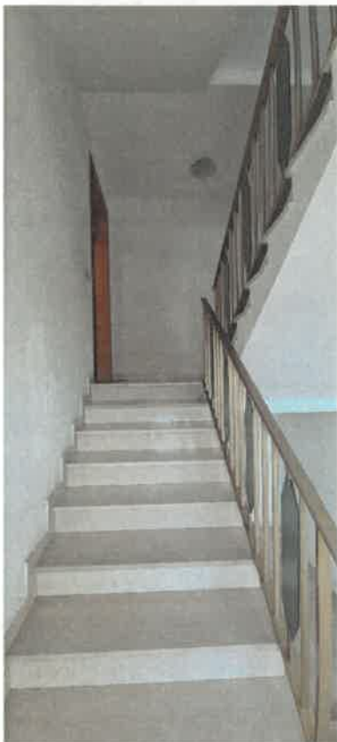
Immagine 17 Vano scala condominiale
