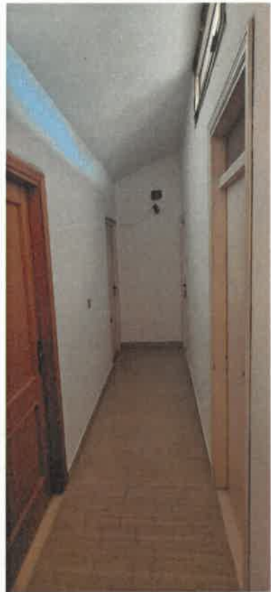
Immagine 19 Corridoio condominiale: accesso soffitta
