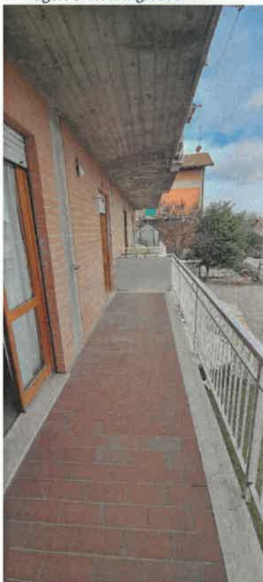
Immagine 10 Terrazza fronte strada
