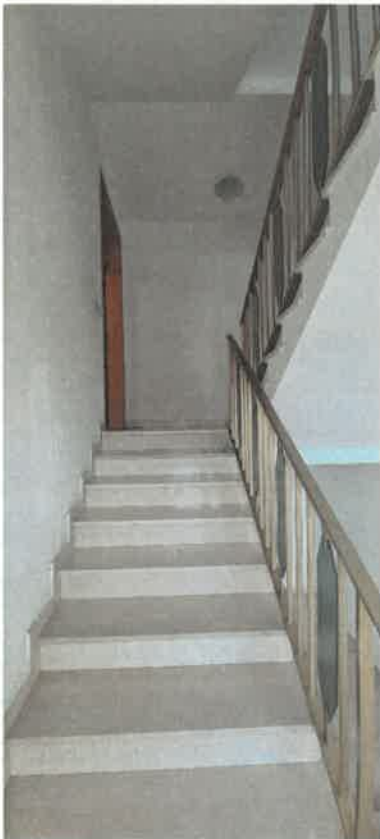
Immagine 17 Vano scala condominiale
