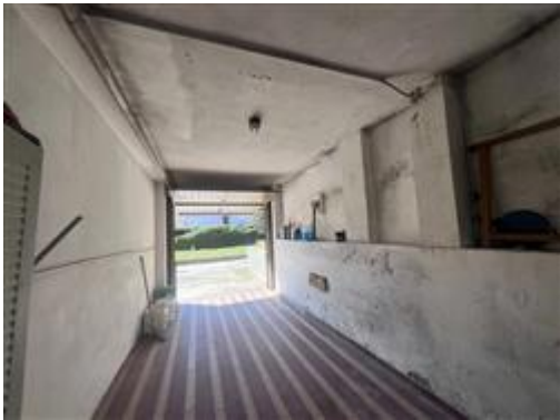
Ripresa del box auto dal fondo verso l'ingresso
