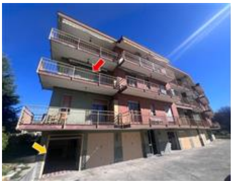
Vista della facciata sud ripresa dal cortile interno in cui la freccia rossa individua l'appartamento sub. 4 e la freccia arancione l'autorimessa sub. 19
