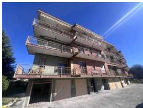
Vista del fabbricato in cui il box auto di interesse è il primo a sinistra, con portone aperto e in posizione angolare
