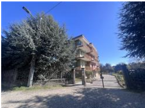
Vista dell'ingresso da strada della Murisa
