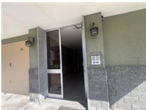
Dettaglio dell'ingresso alla scala condominiale
