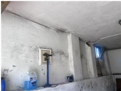
Vista della parete ovest
