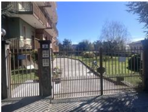
Dettaglio dei cancelli metallici pedonale e carraio di accesso al fabbricato
