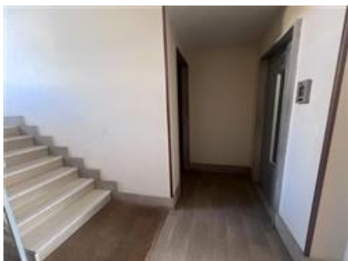
Vista del pianerottolo al piano terra con rampa del vano scala e ascensore
