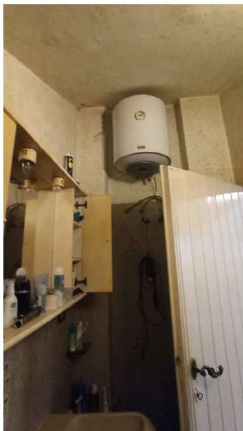
FOTO 27 – BAGNO PIANO TERRA
