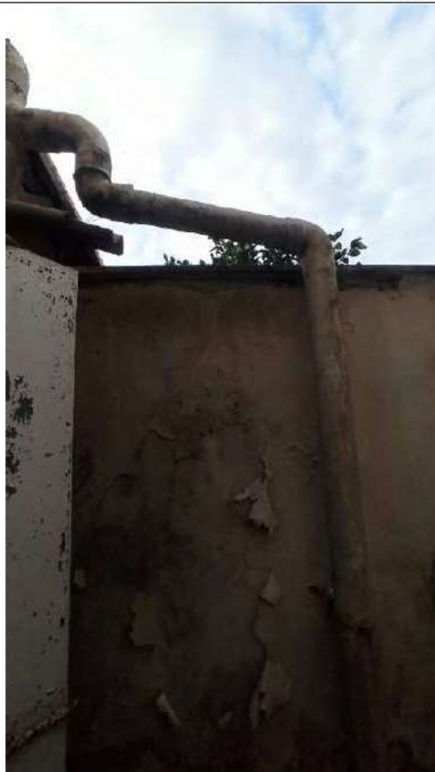
FOTO 12 – VISTA ESTERNA, DETTAGLIO COPERTURE
