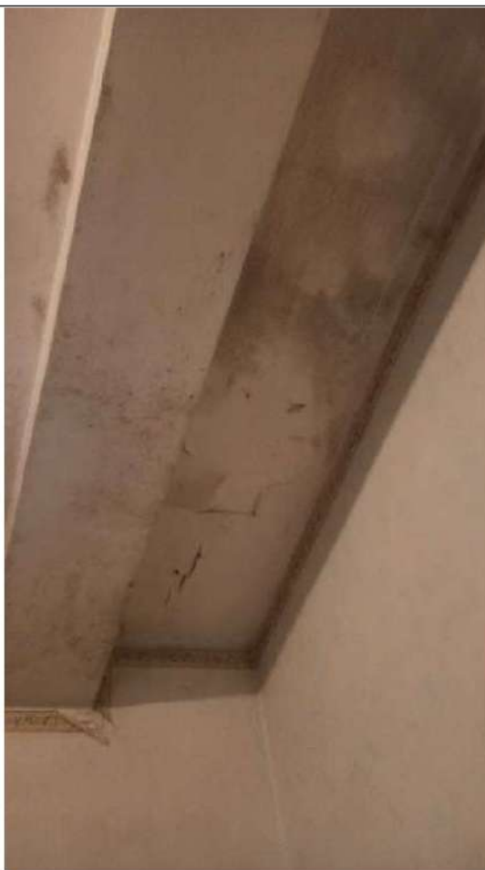
FOTO 38 – DETTAGLIO SOLAIO E TRAVE
