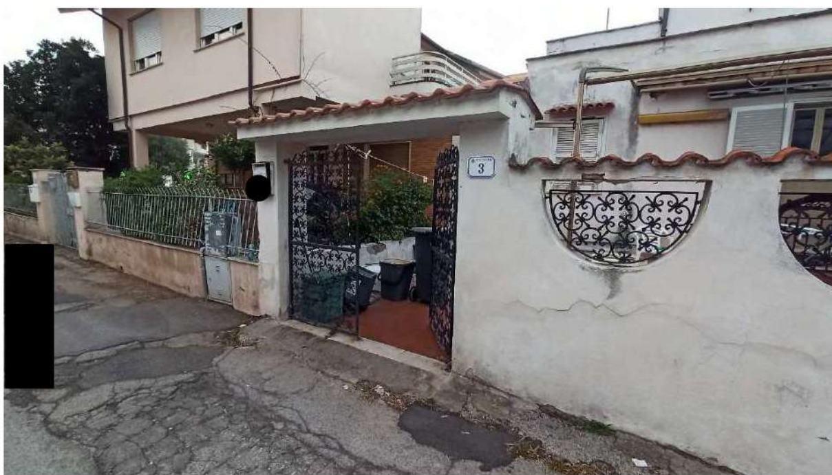
FOTO 1 – VISTA ESTERNA, PIANO TERRA, INGRESSO CIV. 3.
