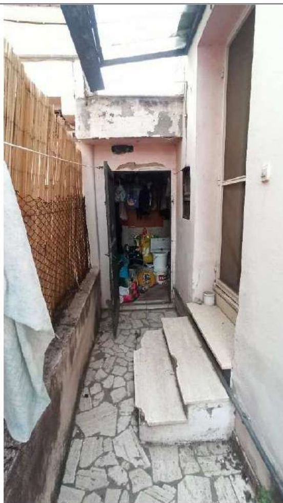
FOTO 9 – VISTA ESTERNA DA CORTE PRIVATA, PORZIONE LATERALE
