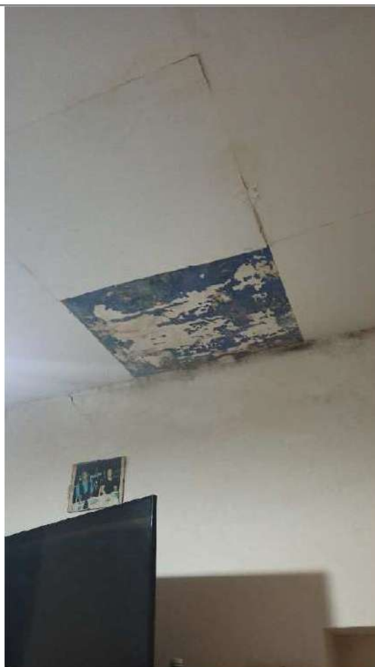
FOTO 41 – DETTAGLIO SOFFITTO STANZA AL PIANO TERRA
