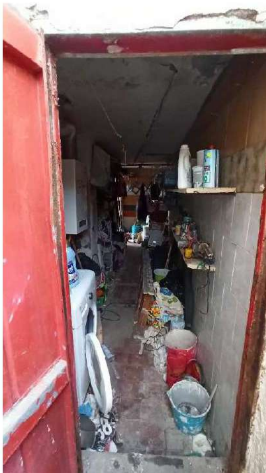
FOTO 11 – VISTA RIPOSTIGLIO ESTERNO, LOCALE TECNICO/MAGAZZINO
