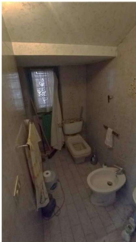
FOTO 26 – BAGNO PIANO TERRA
