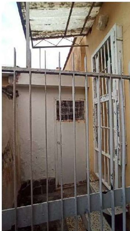
FOTO 16 – CONFINE SCOPERTO RETROSTANTE
