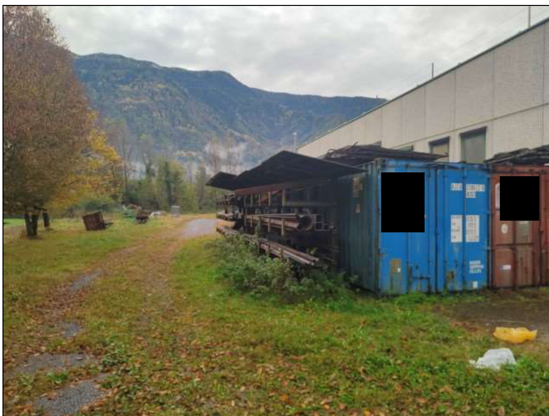
Foto n. 30 – Porzione dell'area Foglio 12 mappale 408 ubicata a est del fabbricato, vista da nord
