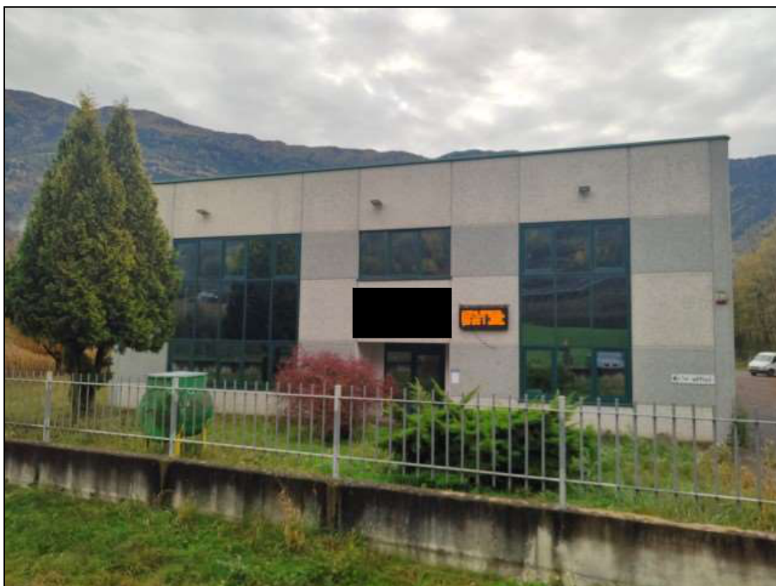
Foto n. 4 – Facciata nord del fabbricato Foglio 12 mapp. 407, vista da nord
