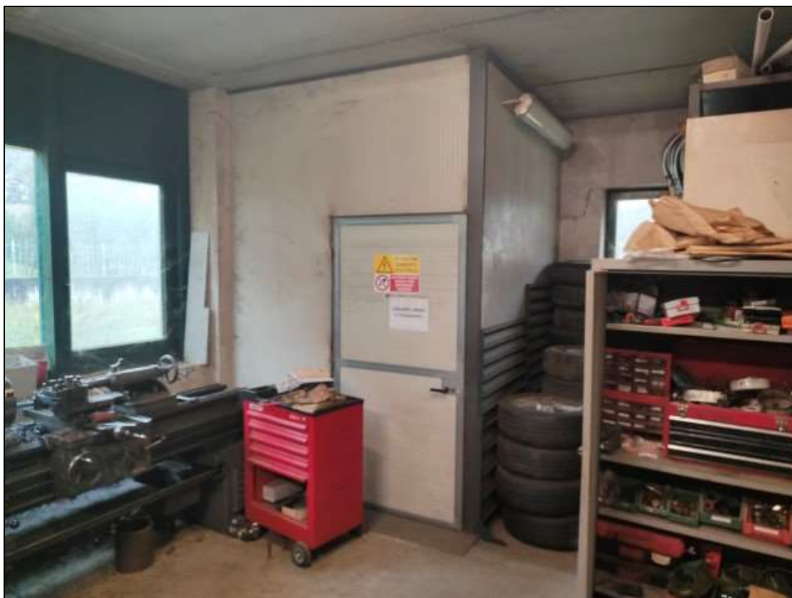
Foto n. 51 – Magazzino, con vista della porta d'ingresso al locale inverter
