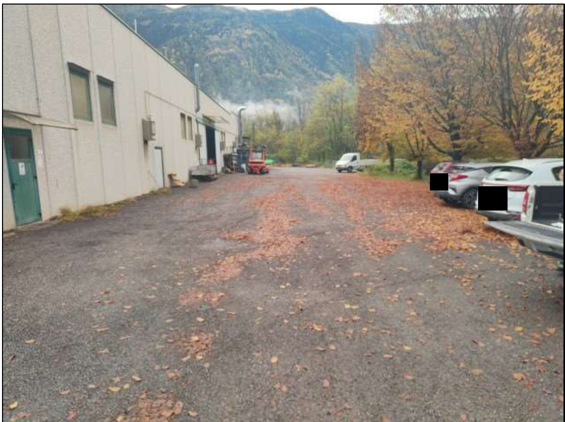
Foto n. 20 – Porzione dell'area Foglio 12 mappale 408 ubicata a ovest del fabbricato, vista da nord
