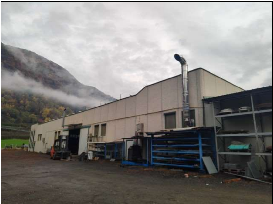
Foto n. 10 – Facciata ovest del fabbricato Foglio 12 mapp. 407, vista da sud-ovest
