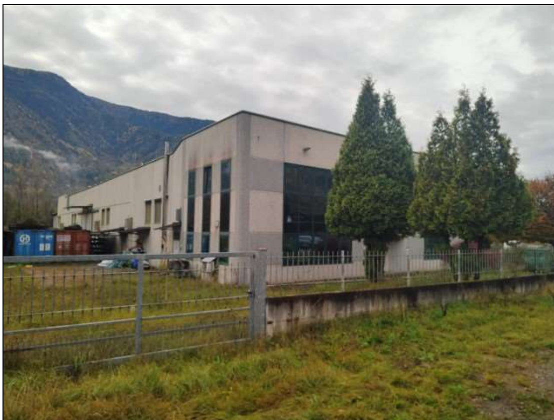
Foto n. 2 - Fabbricato Foglio 12 mapp. 407 e area Foglio 12 mapp. 408, visti da nord-est
