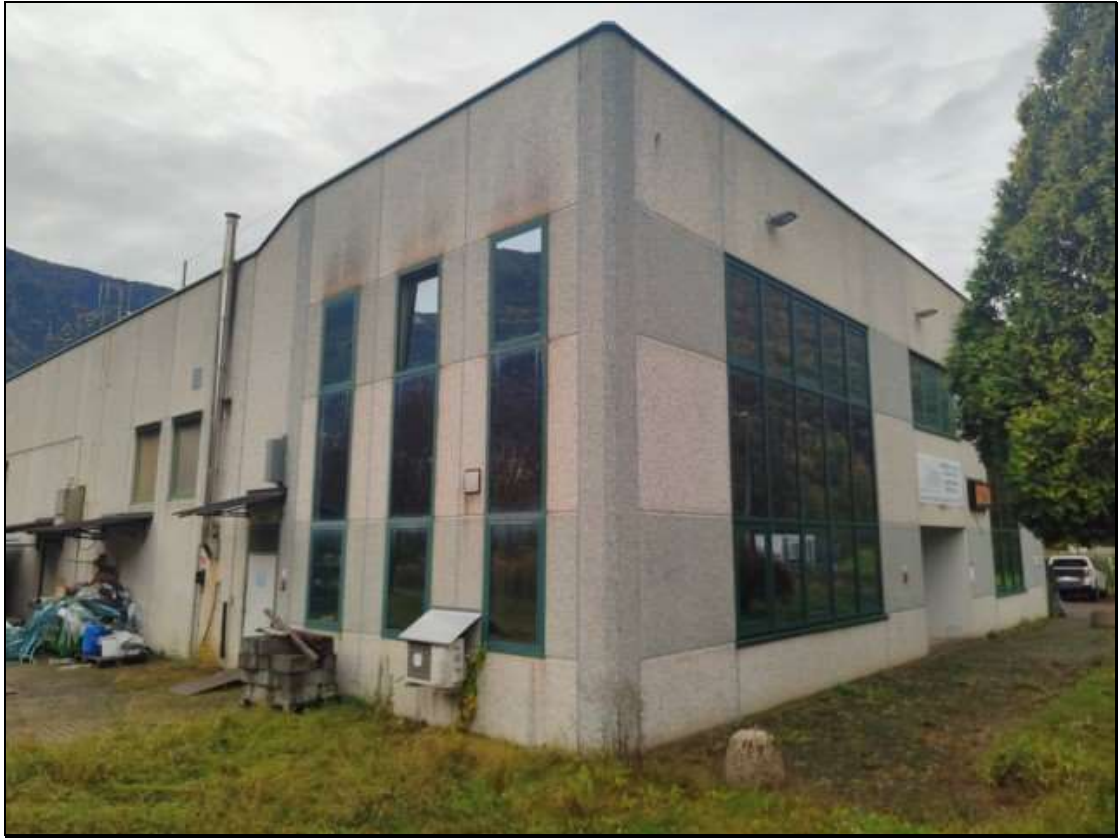
Foto n. 5 – Facciata nord del fabbricato Foglio 12 mapp. 407, vista da nord-est
