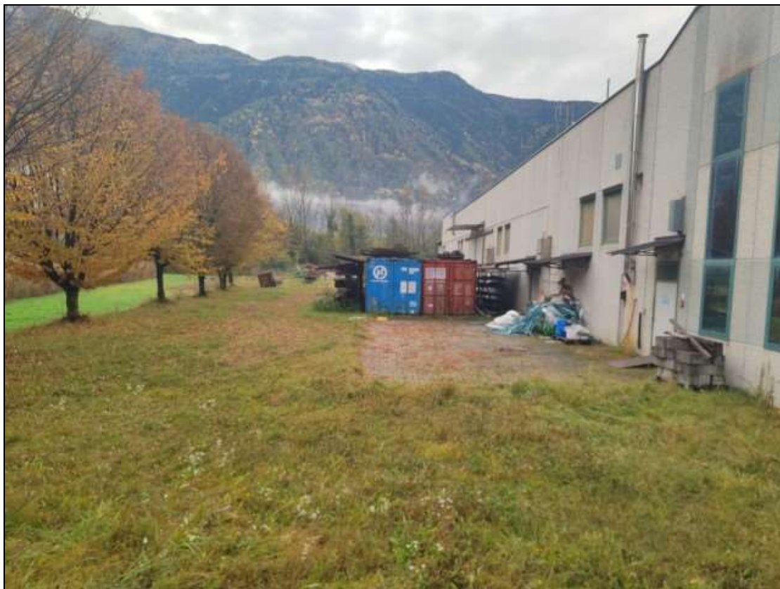
Foto n. 29 – Porzione dell'area Foglio 12 mappale 408 ubicata a est del fabbricato, vista da nord
