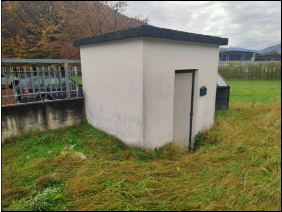
Foto n. 17 – Cabina elettrica Foglio 12 mapp. 406, vista da nord-est
