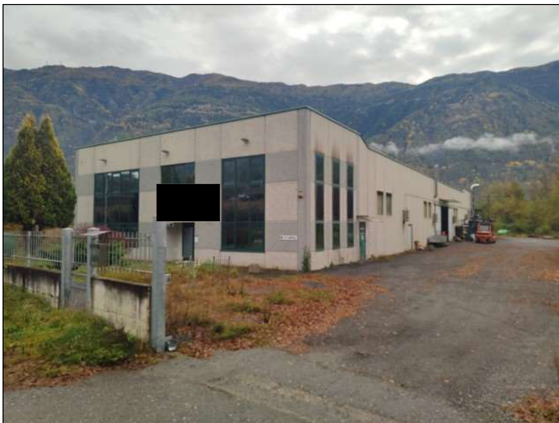
Foto n. 1 - Fabbricato Foglio 12 mapp. 407 e area Foglio 12 mapp. 408, visti da nord-ovest
