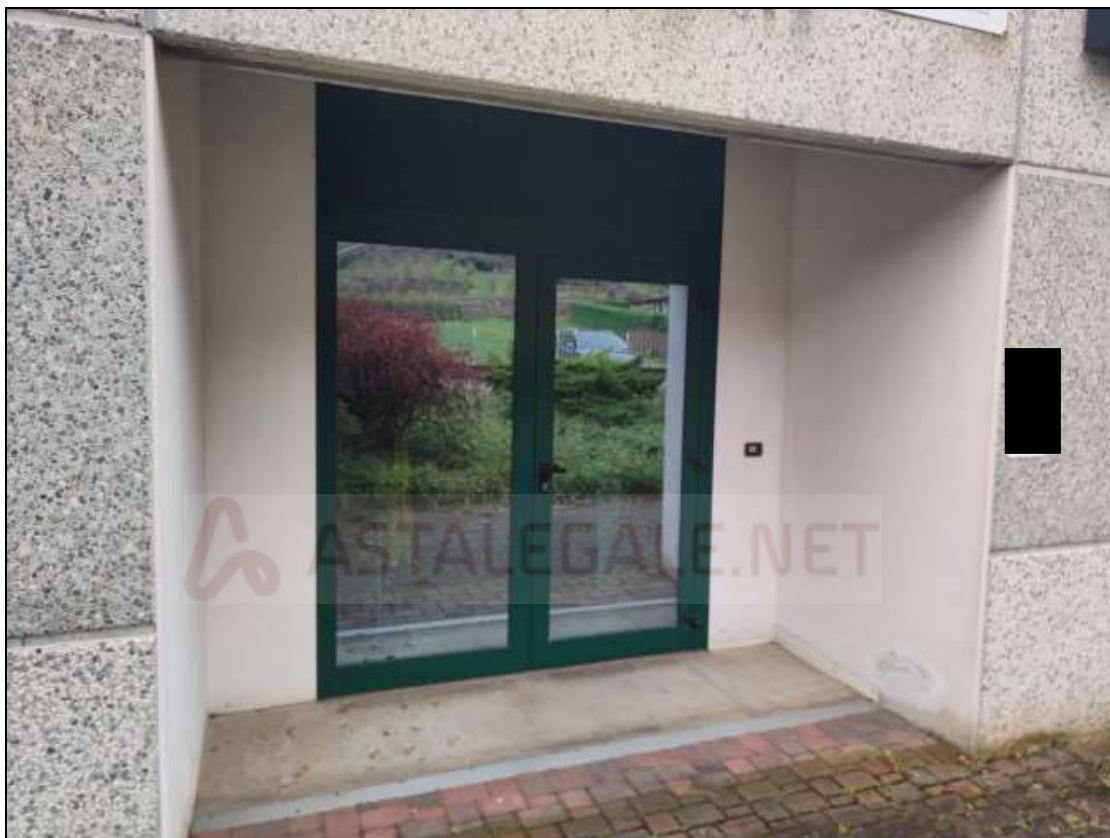
Foto n. 35 – Porta d’ingresso pedonale al fabbricato Foglio 12 mappale 407, vista da nord
