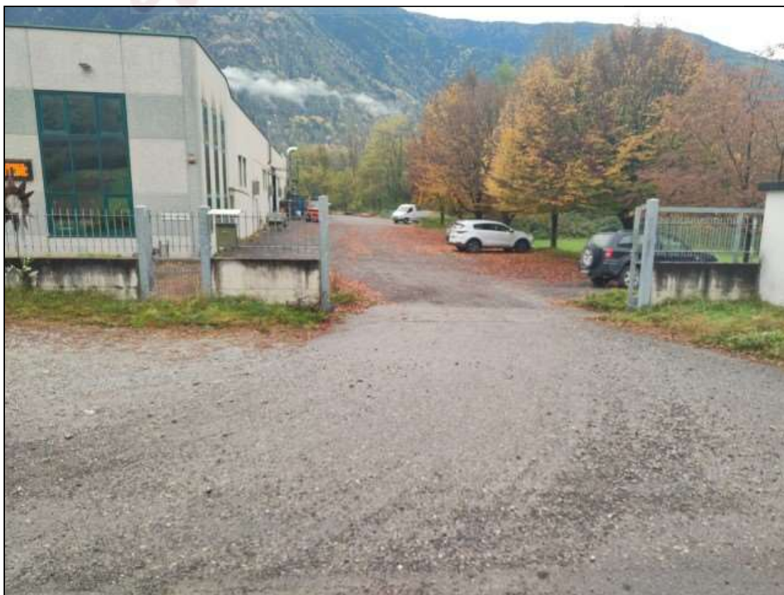
Foto n. 12 – Cancelli per gli accessi pedonale e carraio al complesso immobiliare, ubicati a nord-ovest del fabbricato, visti da nord
