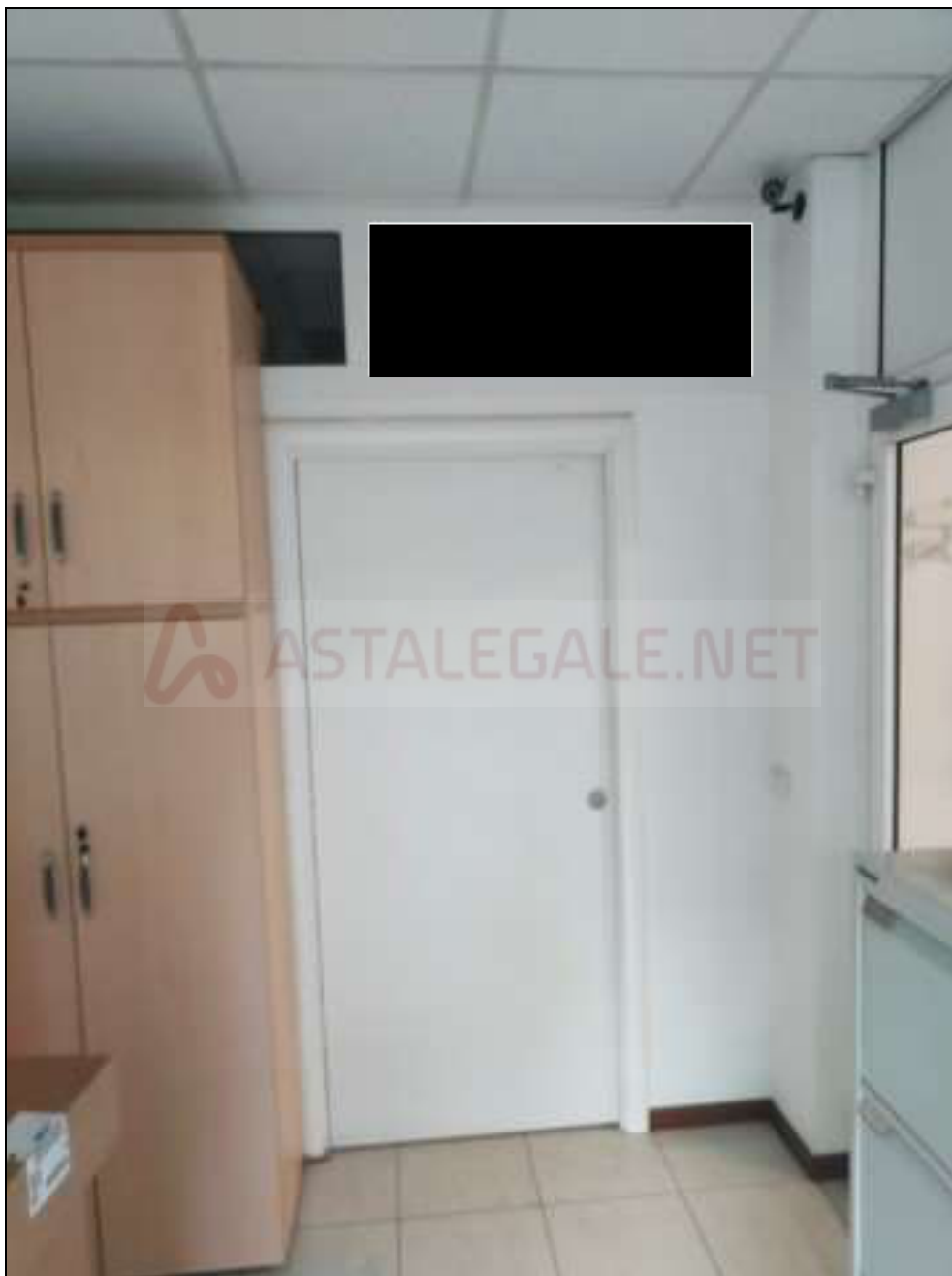
Foto n. 37 – Disimpegno d'ingresso, con vista della porta d'ingresso ad archivio
