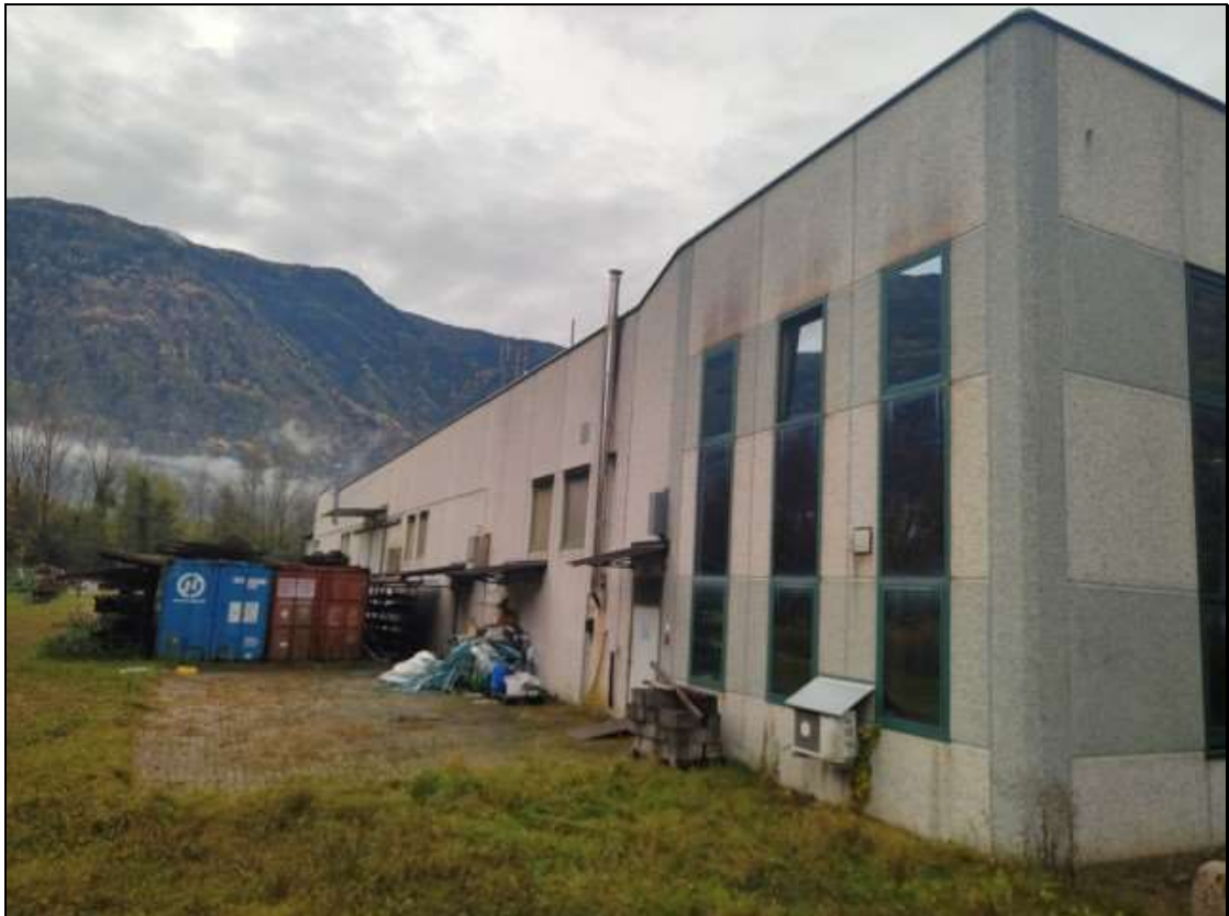
Foto n. 6 – Facciata est del fabbricato Foglio 12 mapp. 407, vista da nord-est
