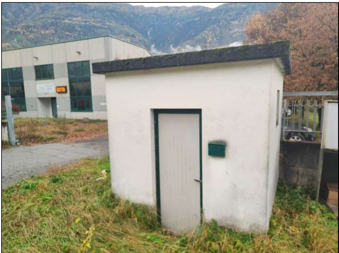
Foto n. 16 – Cabina elettrica Foglio 12 mapp. 406, vista da nord-ovest
