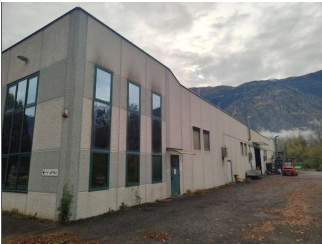
Foto n. 11 – Facciata ovest del fabbricato Foglio 12 mapp. 407, vista da nord-ovest
