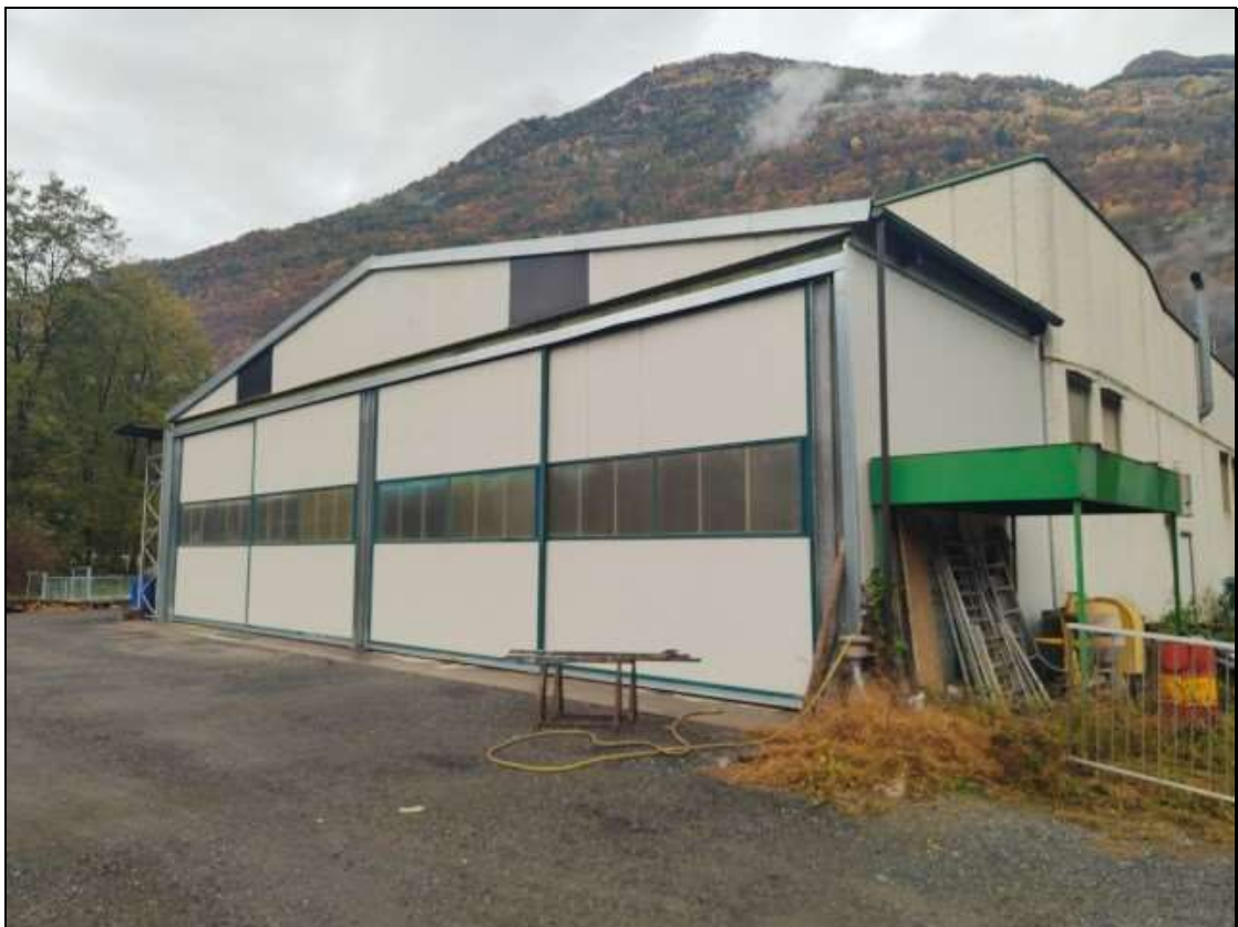
Foto n. 8 – Facciata sud del fabbricato Foglio 12 mapp. 407, vista da sud-est
