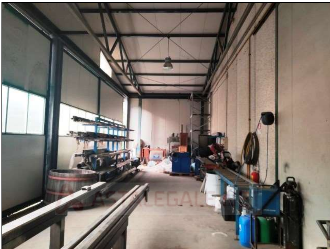
Foto n. 76 – Tettoia ubicata a sud del fabbricato
