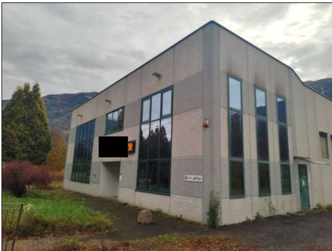
Foto n. 3 – Facciata nord del fabbricato Foglio 12 mapp. 407, vista da nord-ovest
