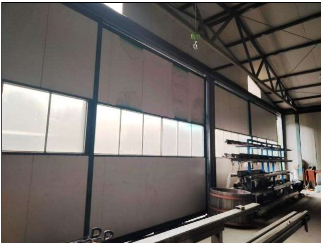
Foto n. 75 – Tettoia ubicata a sud del fabbricato
