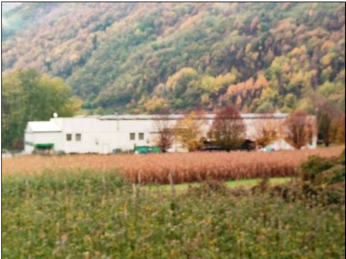
Foto n. 34 – Fabbricato Foglio 12 mappale 407, visto da est
