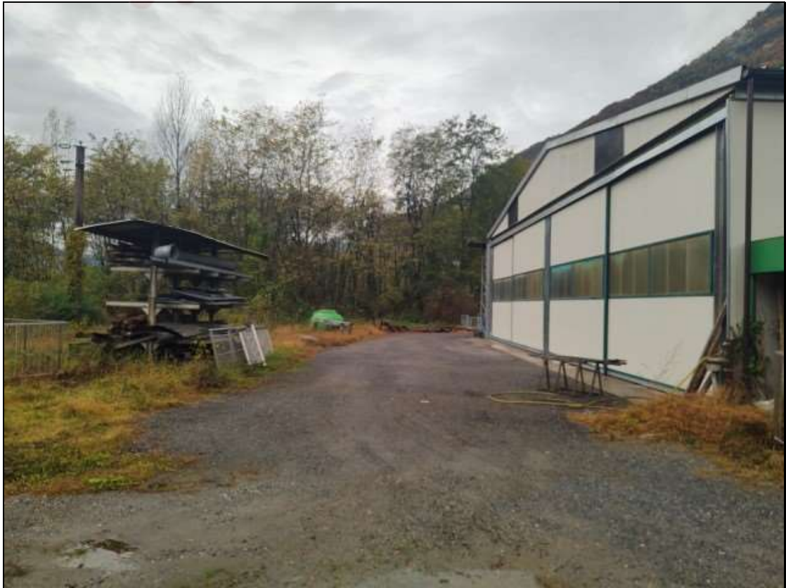
Foto n. 26 – Area ubicata a sud del fabbricato, vista da est, in parte insistente sul mappale 408 di Foglio 12 ed in parte insistente sul mappale 287 di Foglio 12, quest’ultimo di proprietà della esecutata ma non oggetto di pignoramento
