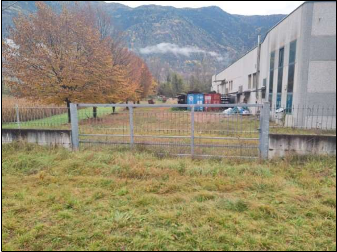
Foto n. 13 – Cannello per l'accesso carraio al complesso immobiliare, ubicato a nord-est del fabbricato, visto da nord
