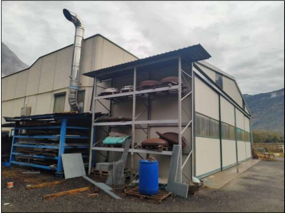
Foto n. 9 – Facciata sud del fabbricato Foglio 12 mapp. 407, vista da sud-ovest
