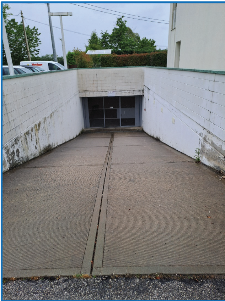
n° 27 – cancello comune garage
