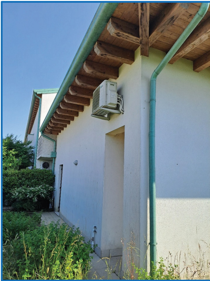
n° 3 esterno nord
