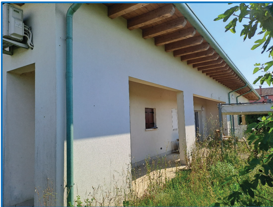
n° 2 – Esterno ovest
