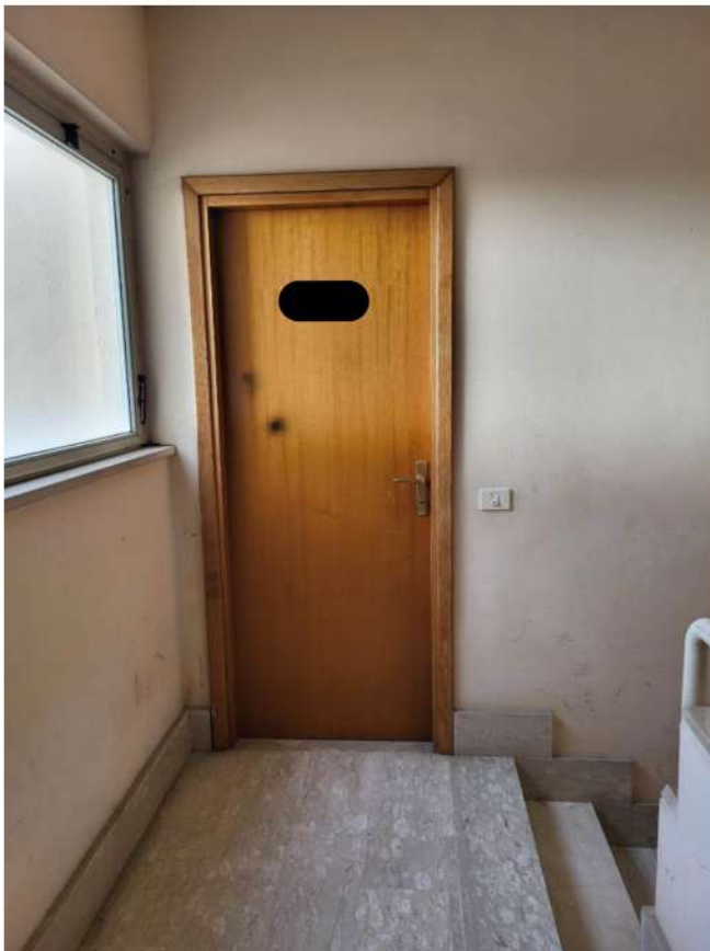
Foto n. 12 Particolare porta di ingresso alle cantine al piano quinto, dove ricade la cantina n.5 oggetto di esecuzione immobiliare.
