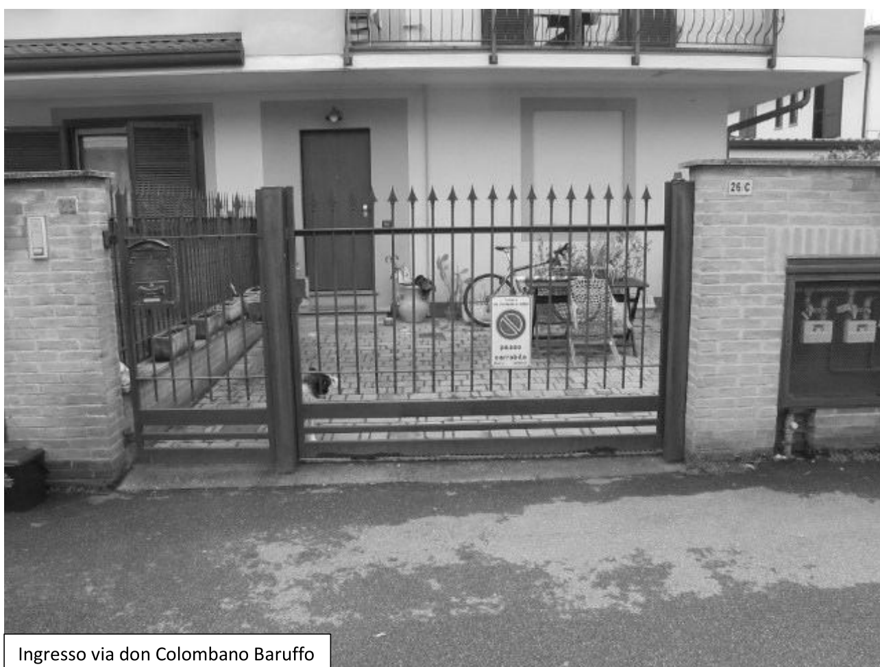
Lato verso via don Colombano Baruffo
