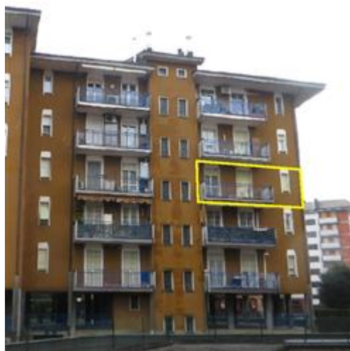
L'unità oggetto della perizia
