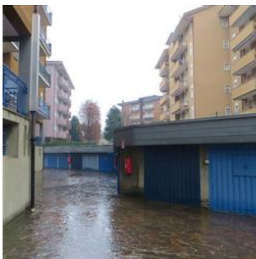
Il corsello di manovra comune
