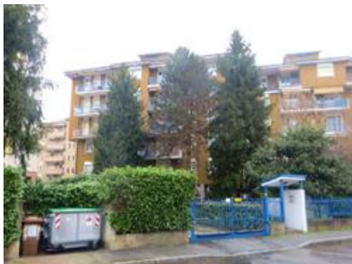
Il condominio visto da Via Vico
