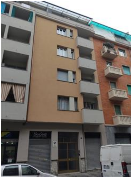
prospetto dell'edificio verso via Monte Rosa
