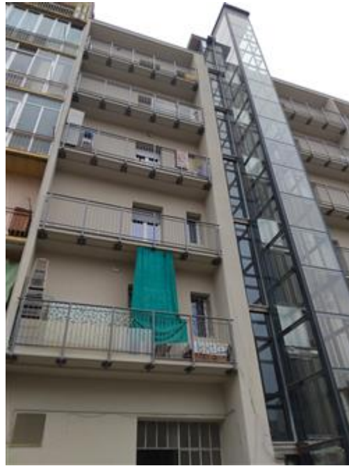
prospetto dell'edificio verso cortile interno
