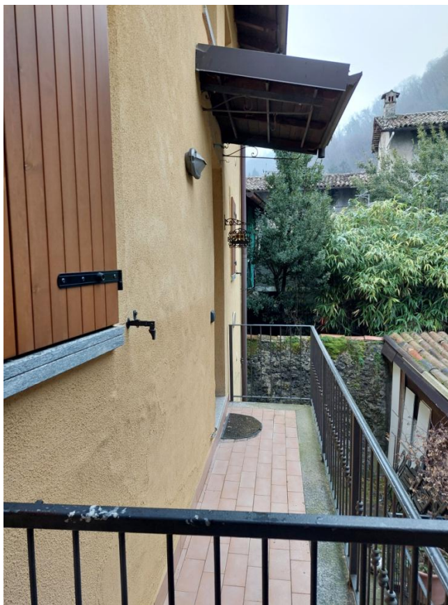
Vista del balcone d'ingresso nell'appartamento
