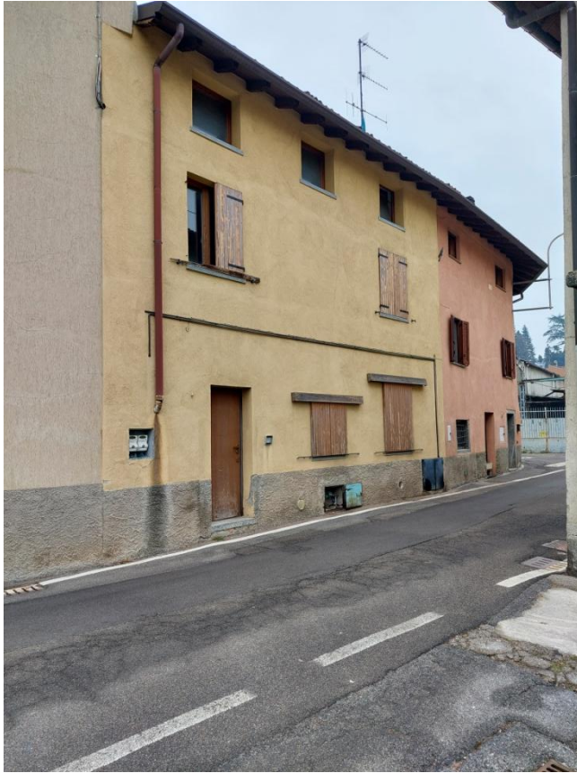
Prospetto sud dell'edificio
