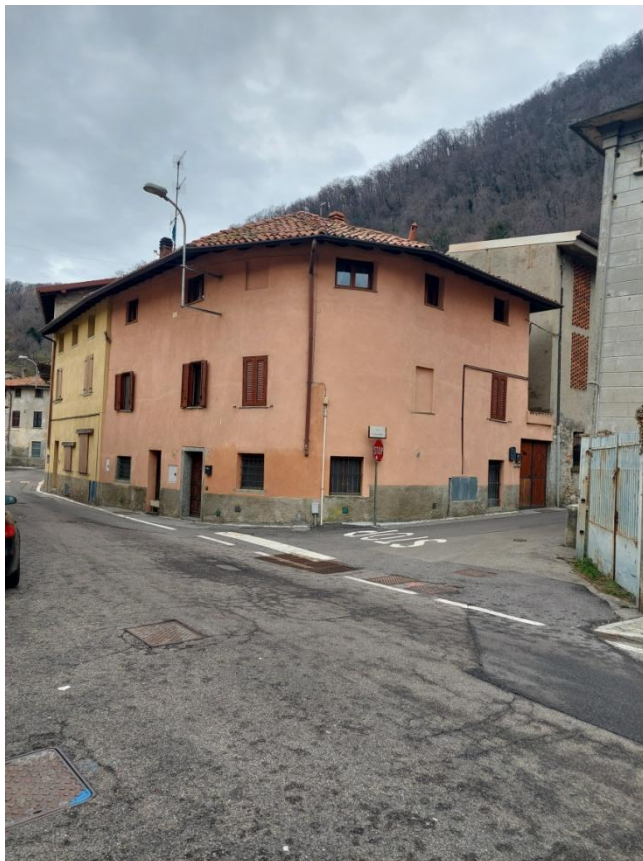
Prospetto sud-est dell'edificio
