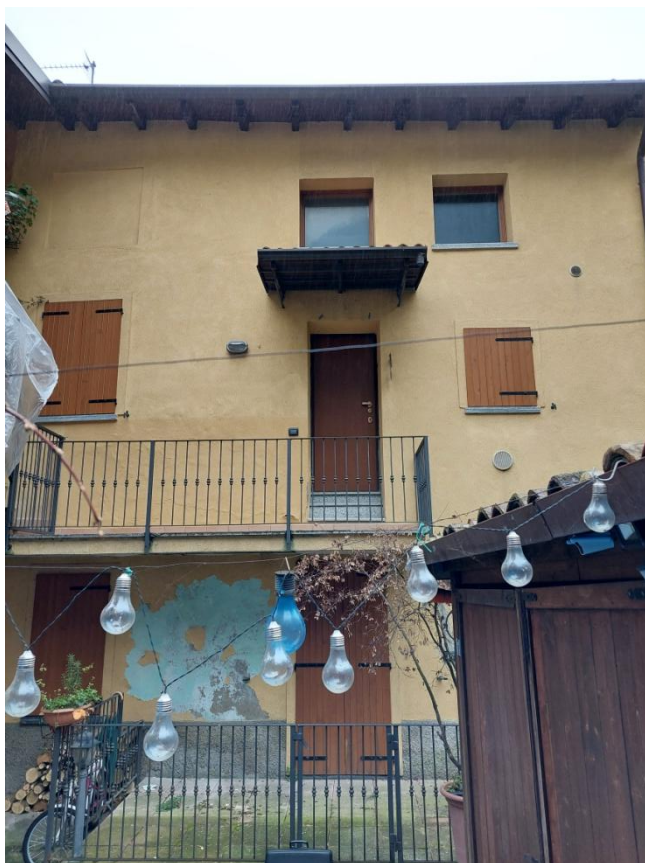
Prospetto nord dell'edificio
