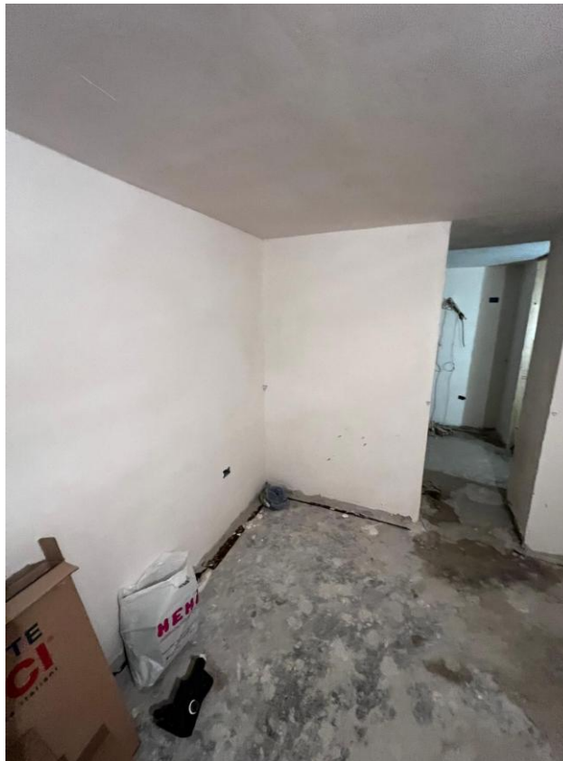
Foto 26. Cantina al piano S1
