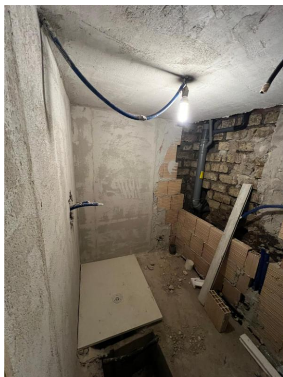
Foto 29-30. Cantina al piano S1
