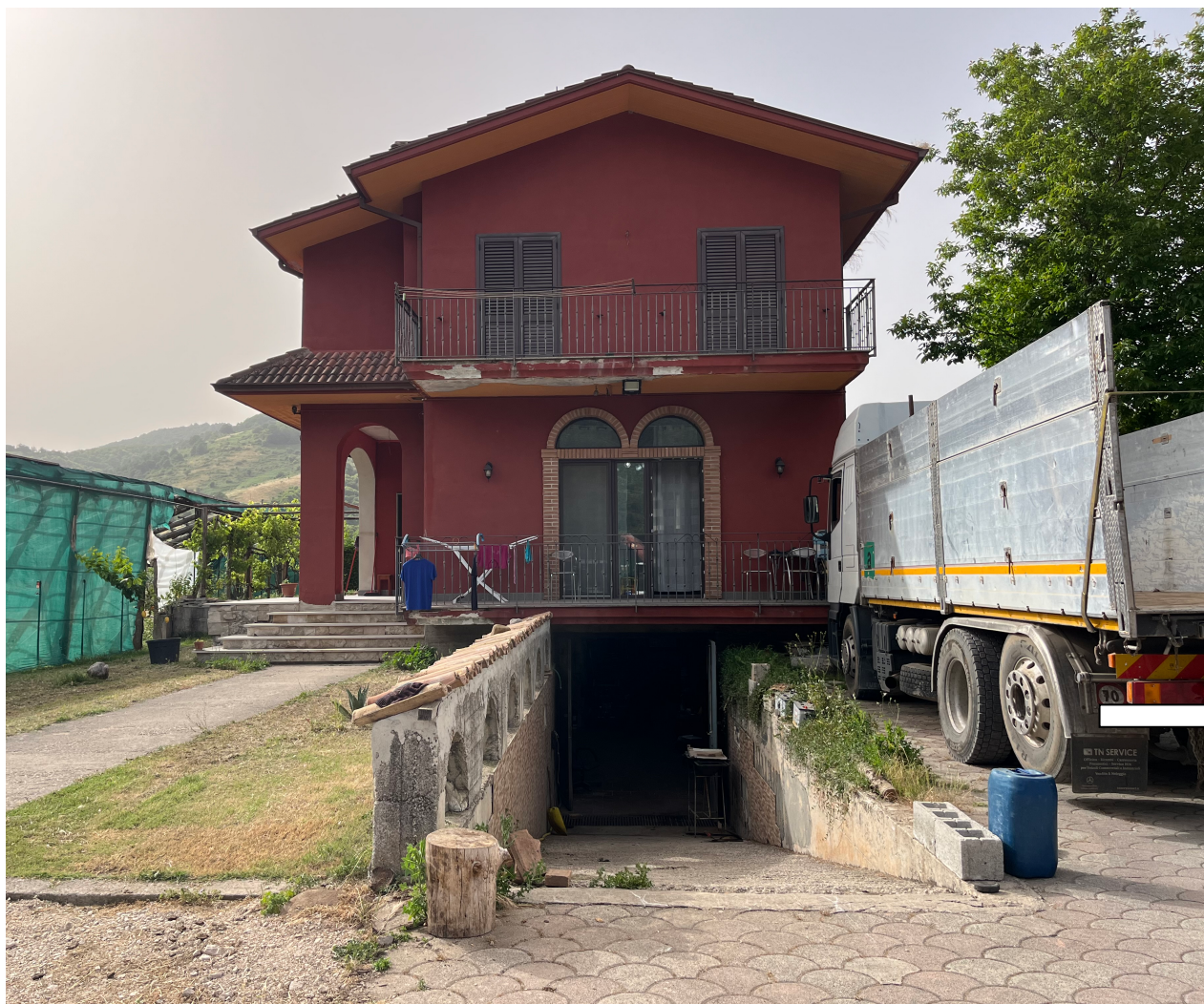
Fig. 4: Prospetto Sud-Est del fabbricato
