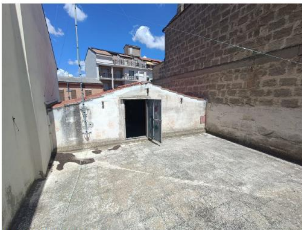
Figura 18 – Lastrico Solare (Terrazzo).
