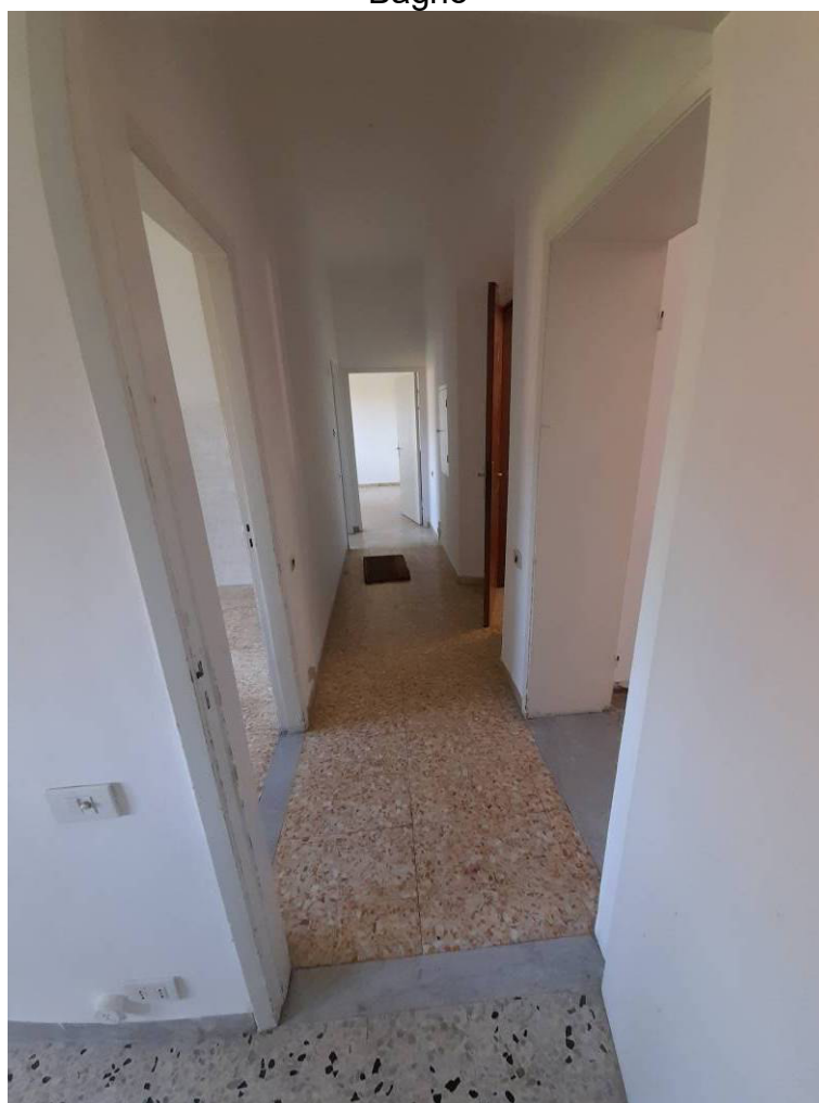
Disimpegno con porta di collegamento alla scala interna
