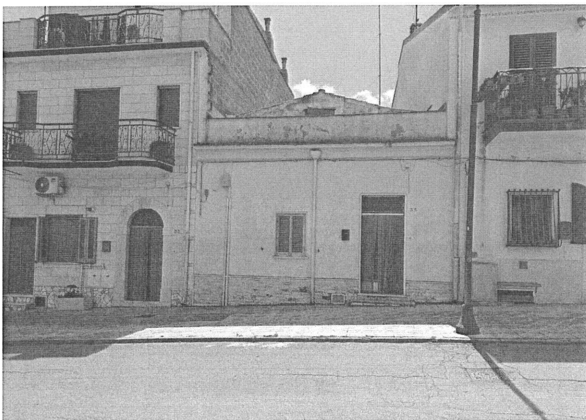
Figura 3 – Panoramica Ingresso Piano Terra, Corso Cavour, n. 35 (ex Corso Cavour, n. 43).
