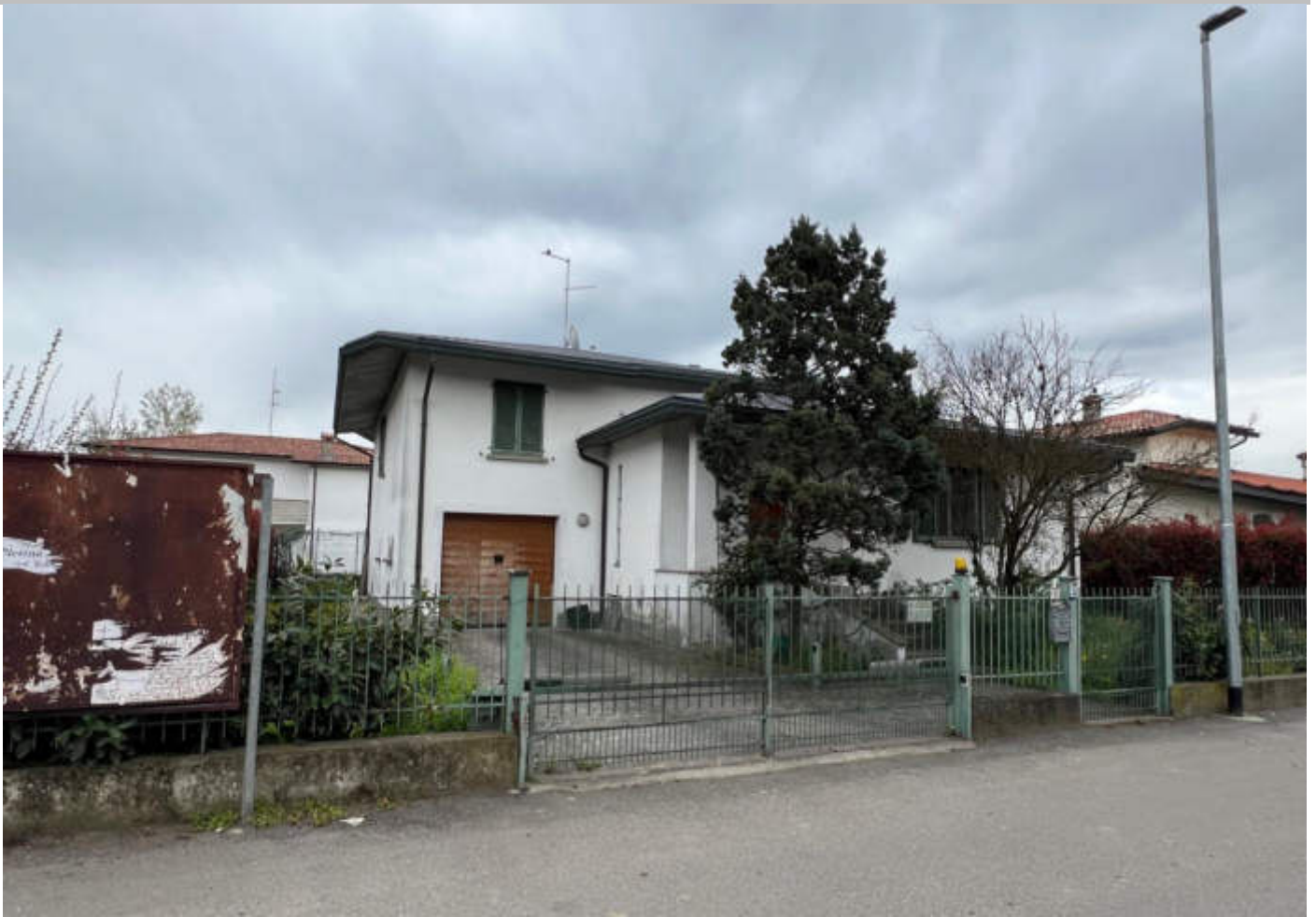
Vista (ovest) da Via Giovanni XXIII della Villa con l'area esterna
