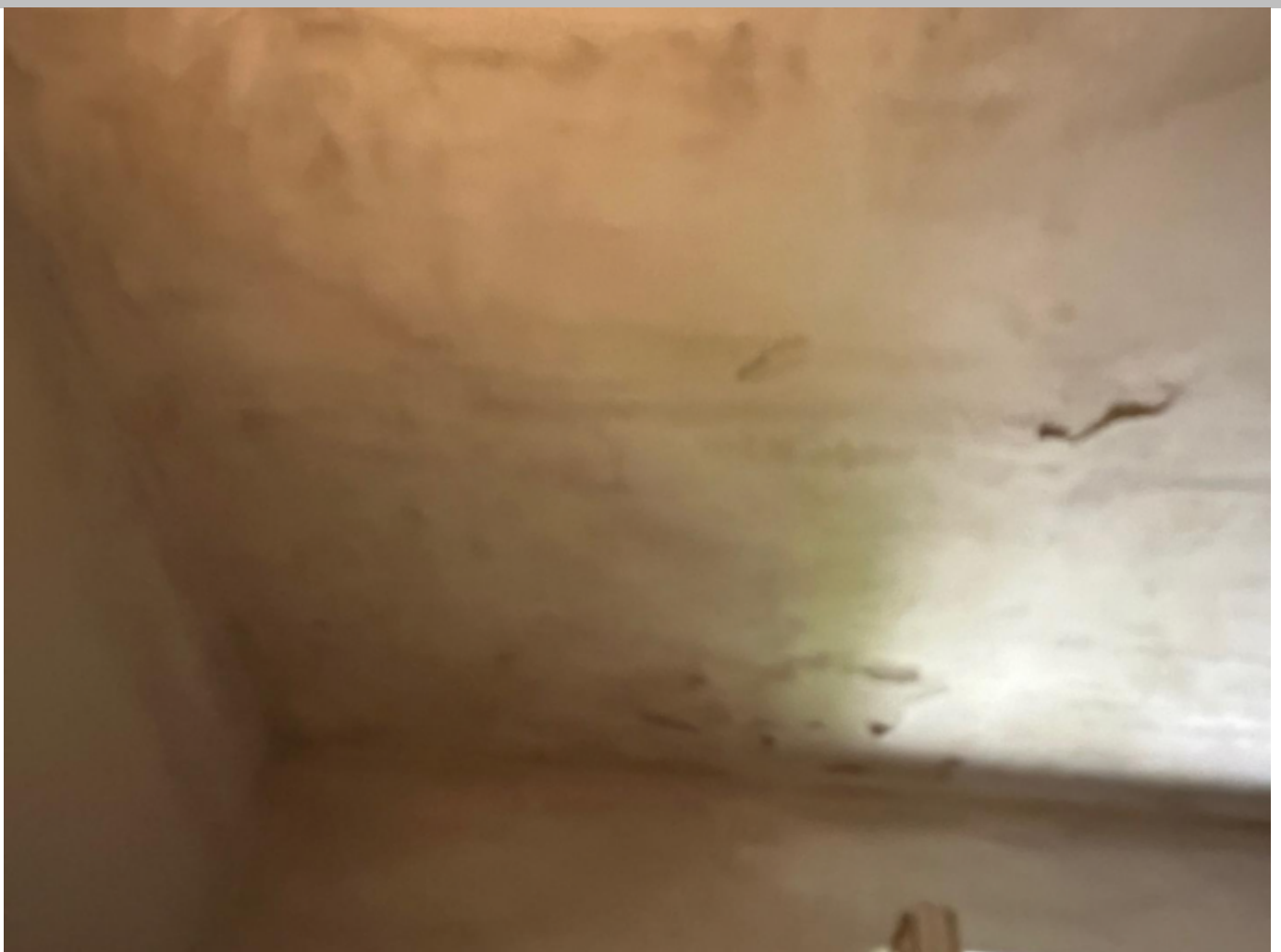
MACCHIA SU SOFFITTO CON TETTO GIA' RIPARATO
