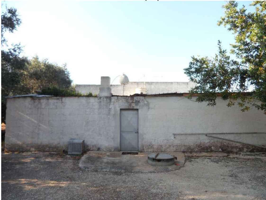
Foto 5 – Vista esterna ovest - prospetto corte interna
