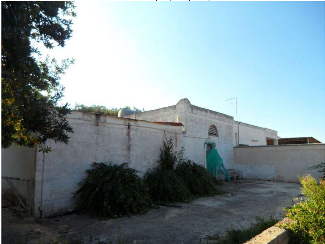
Foto 4 – Vano prospetto principale
