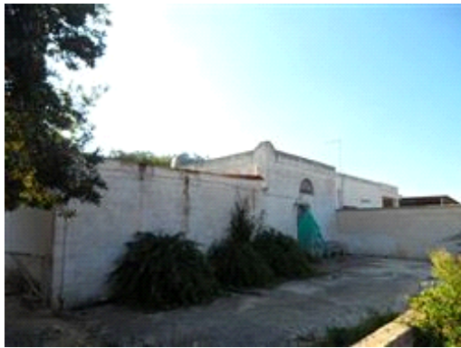
Vista prospetto principale
