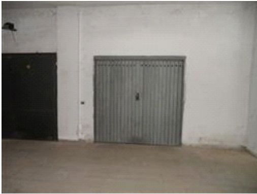
Vista accesso Garage
