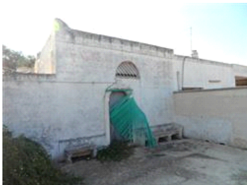
Vista prospetto principale
