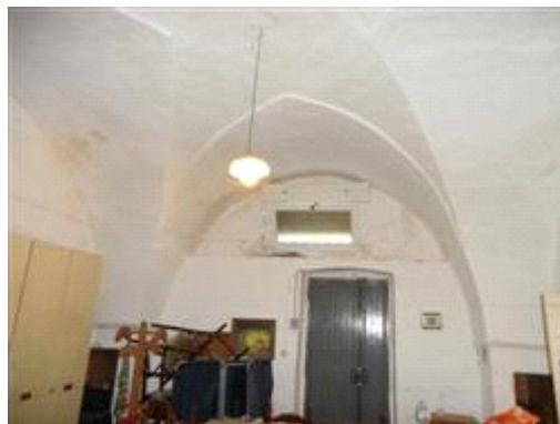
Particolare vista interna vano ingresso
