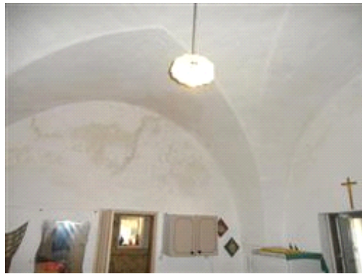
Particolare vista interna - superficie intradossale a volta
