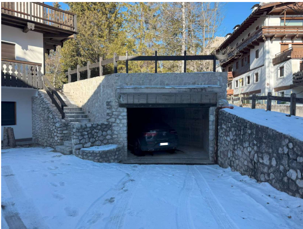
Foto 15: autorimessa comune (particella .844 sub. 12)
