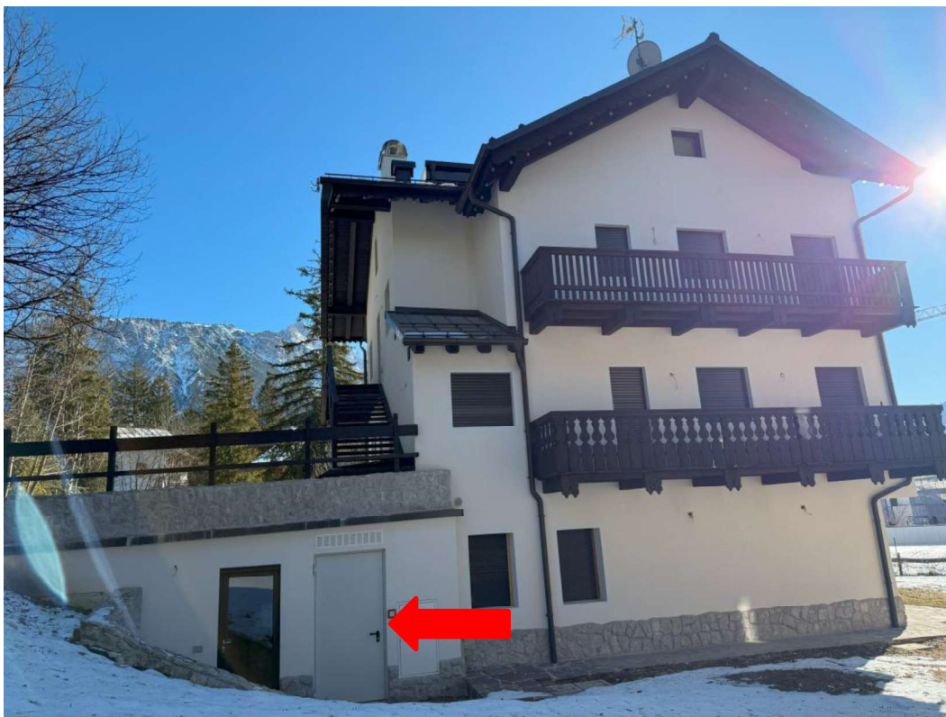
Foto 03: fronte Nord-Ovest condominio “Ca’ del Mejo”, evidenziato porta accesso C.T.
