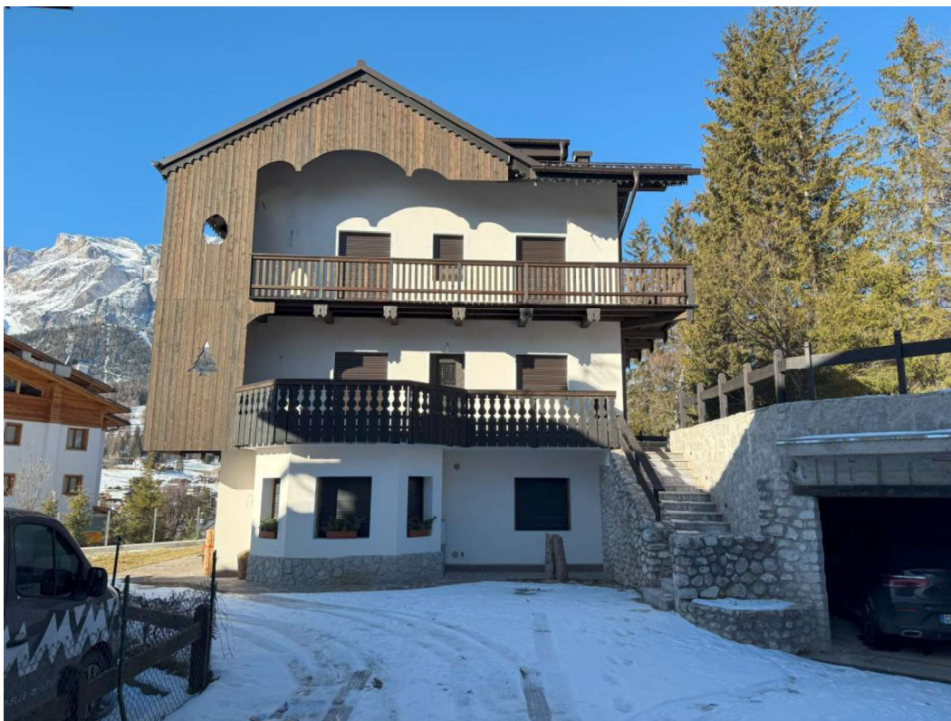
Foto 01: fronte Sud-Ovest condominio “Ca’ del Mejo”
