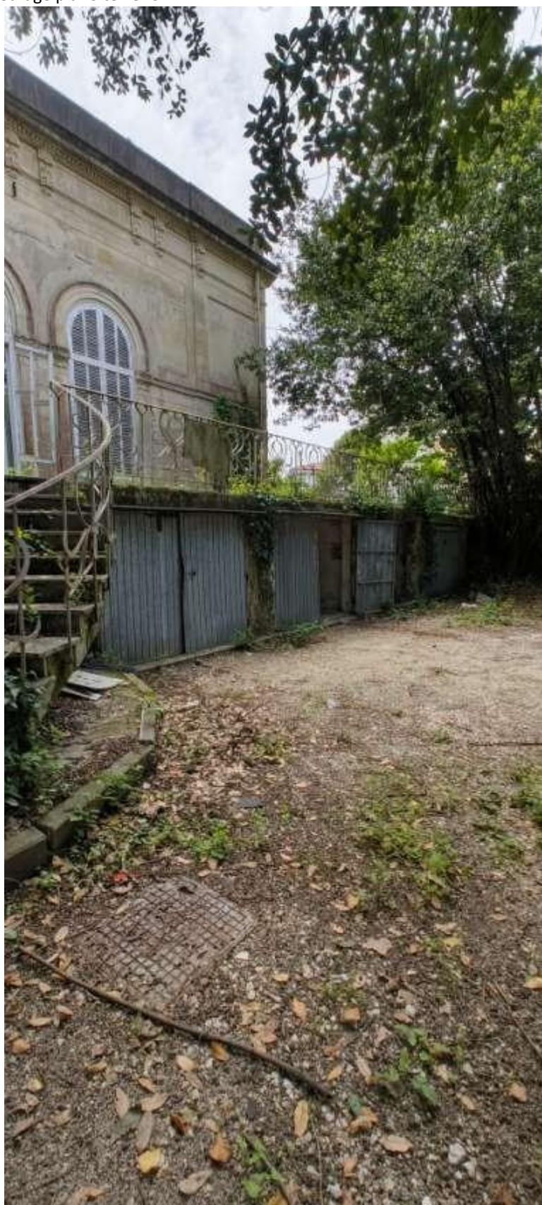
Documentazione fotografica Garage piano terreno
