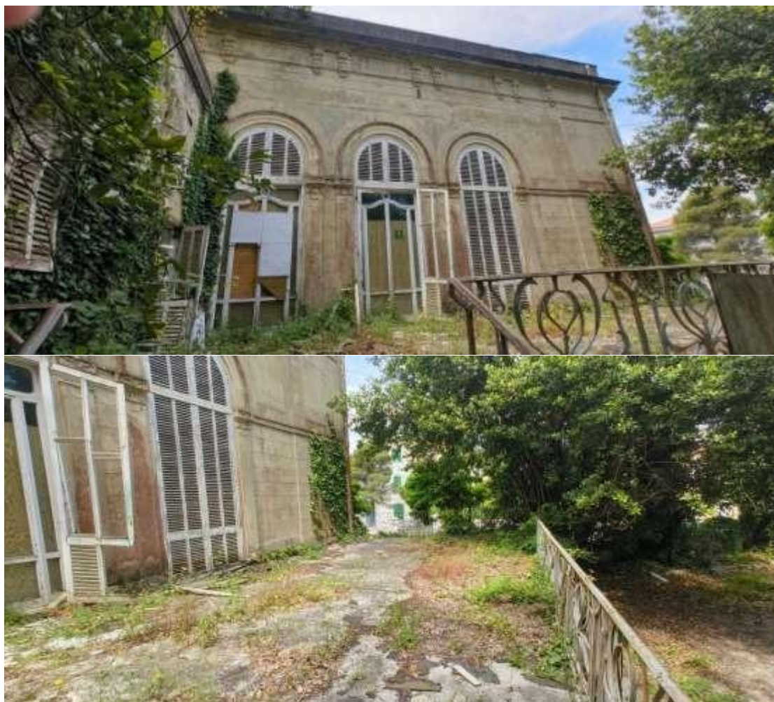
Documentazione fotografica Avancorpo lato nord Piano terreno
