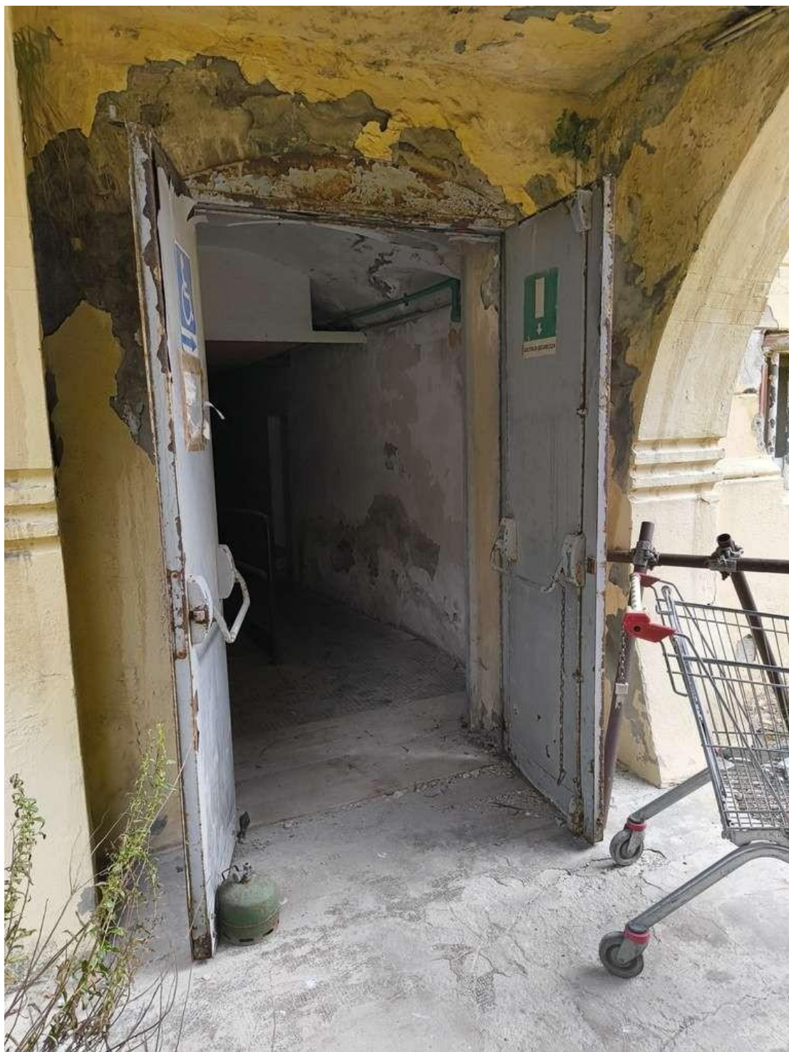
Documentazione fotografica Edificio principale Piano seminterrato
