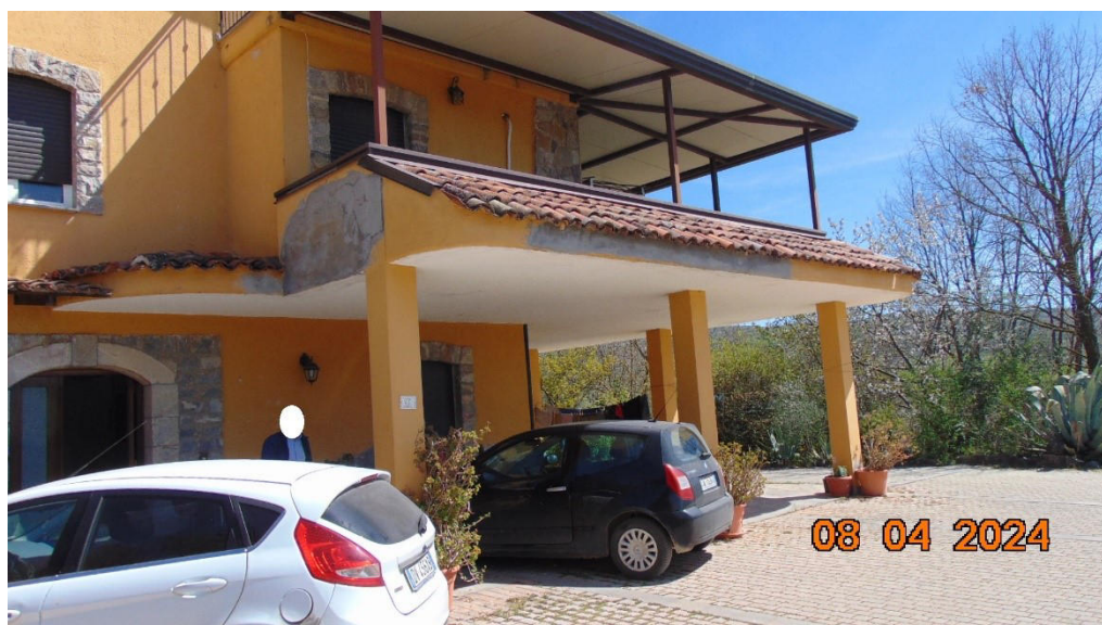
Particolare Portico (P.T.) e copertura Terrazzo (1° P)
