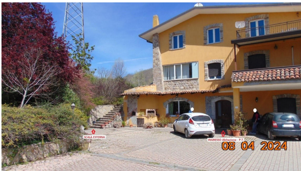
Ingresso Abitazione P.T. e scala esterna (accesso secondario – P.1)
