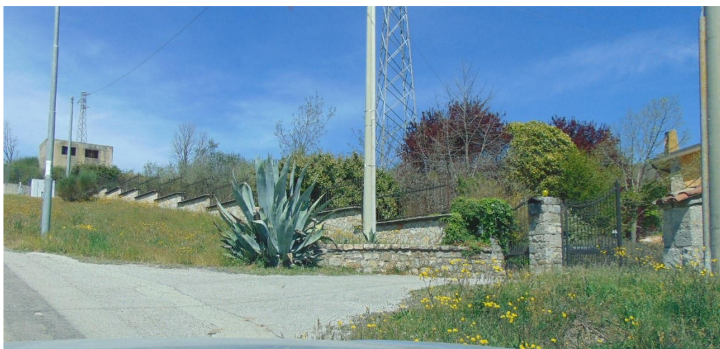
Recinzione esterna su strada pubblica e Traliccio Enel
