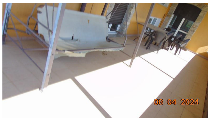
Particolare terrazzo 1° Piano
