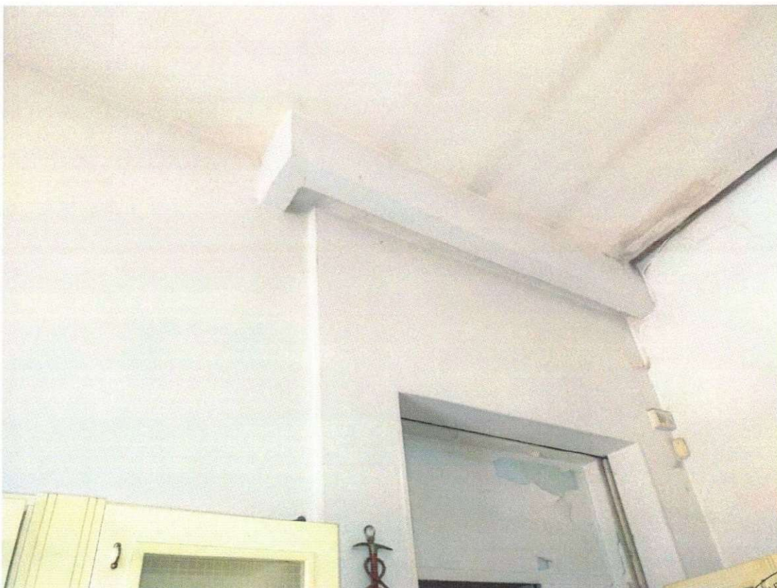
Foto n. 7 – Scorcio del soffitto del vano cucina/pranzo.
