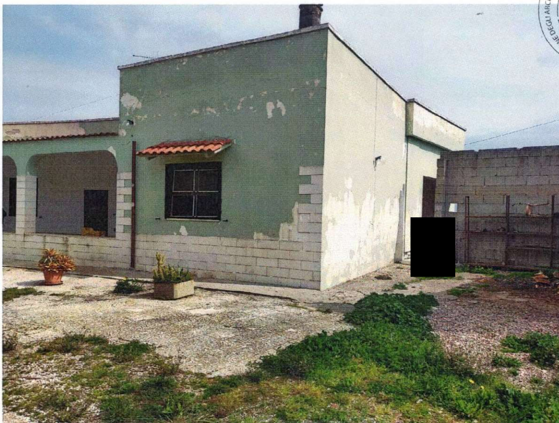
Foto n. 2 – Scorcio prospetti appartamento.
