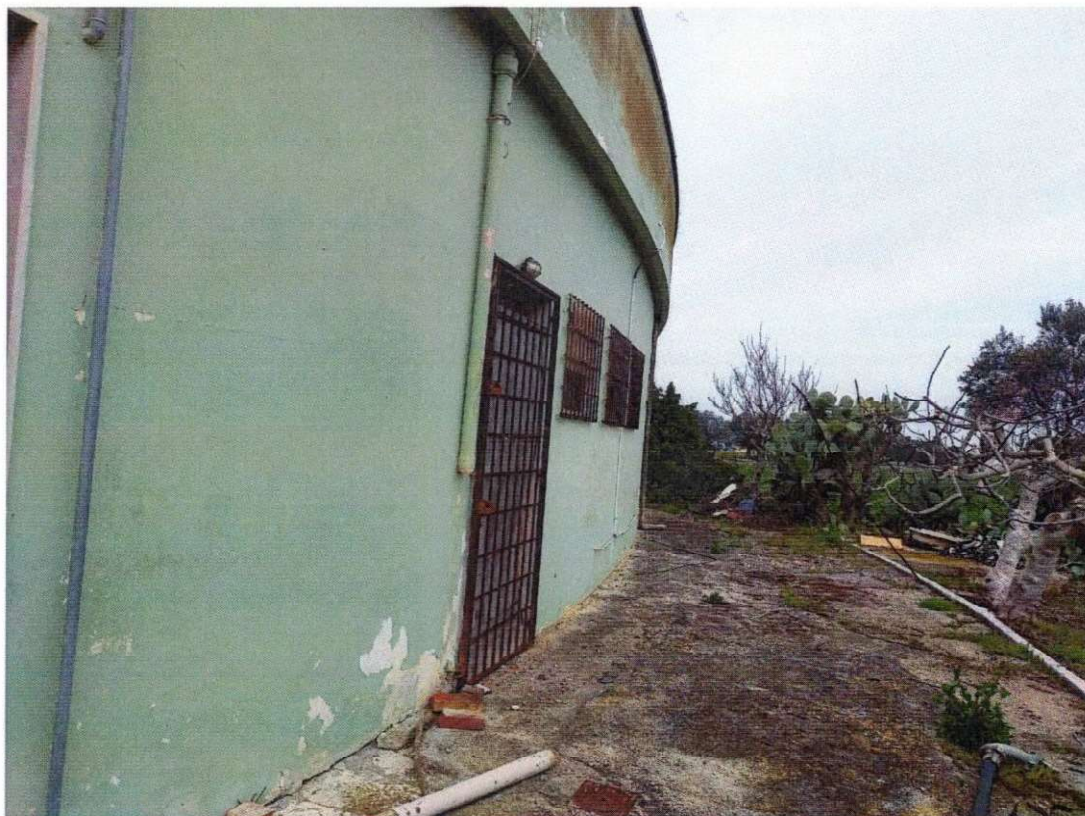
Foto 18 – Scorcio del prospetto esterno del fabbricato.
