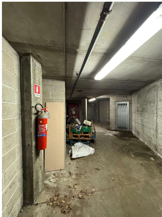
Piano interrato: cantina
