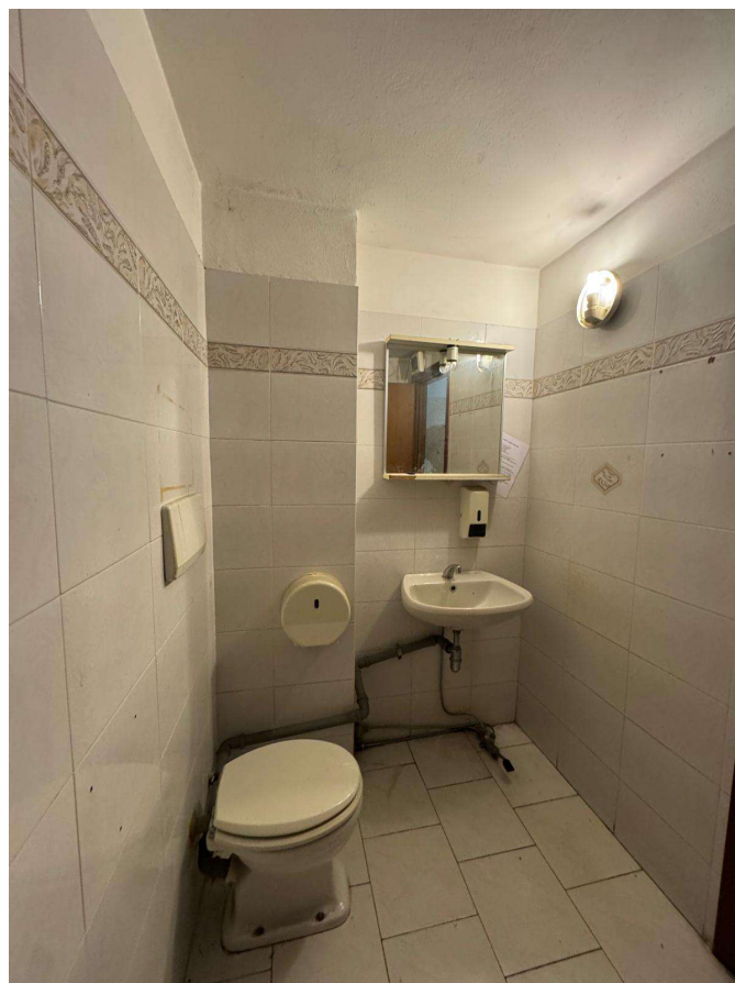
Piano interrato: bagno
