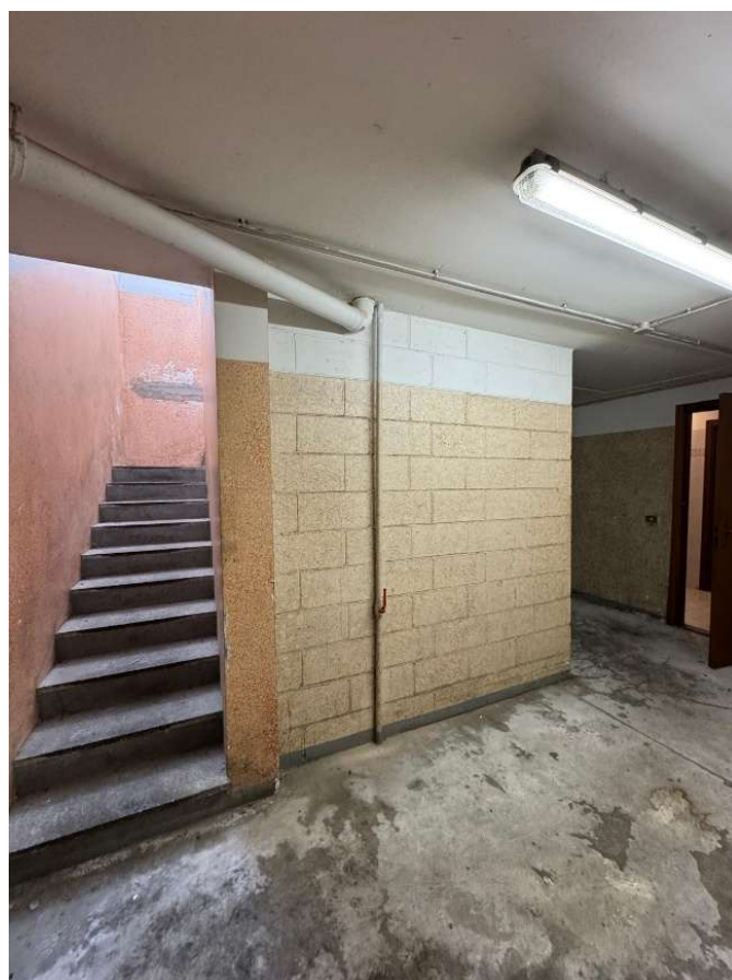
Piano interrato: disimpego
