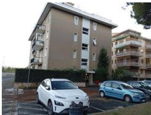
Condominio I Pesci, Via Tevere civico 11
