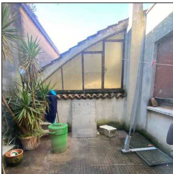
Cavedio su cui affacciano due servizi
