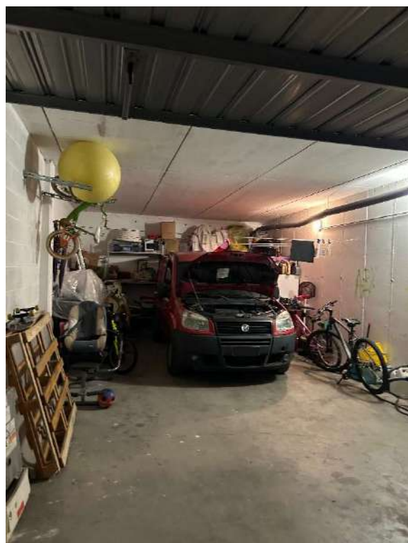
Autorimessa piano scantinato
