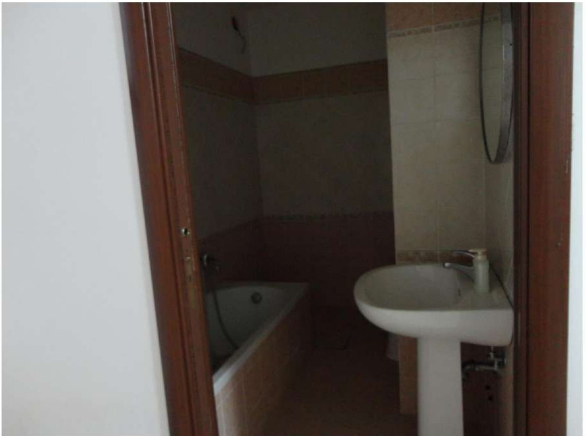
Bagno al piano interrato
