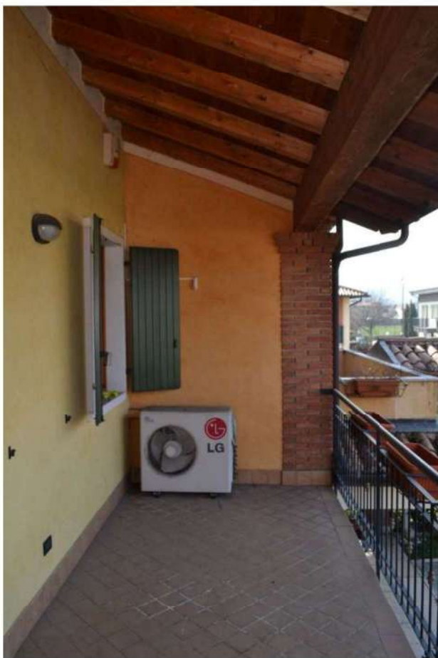
foto 12 - sub3 (balcone) - L'aggetto coperto, asser-vito alla stanza da letto doppia (cfr. foto 16), si rag-giunge da una porta finestra a due ante. Di sotto si trova il portico di cui alla foto esterna n. 3.
