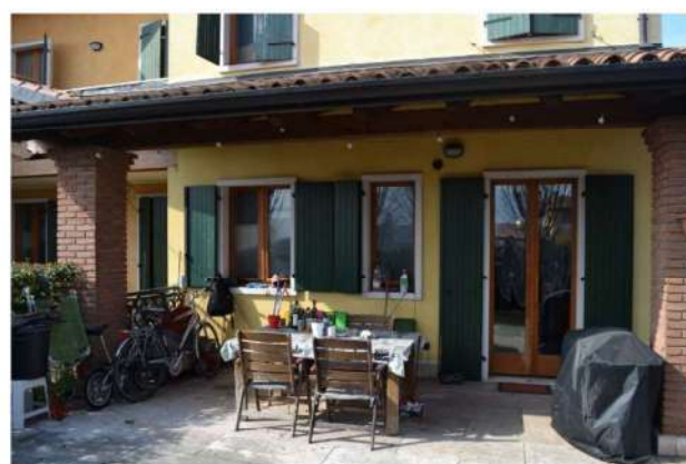
foto 6 - (sub 3) - Diversamente da quanto illustrato al catasto, non esiste un balcone a est. Il fabbricato espone il prospetto posteriore alla strada maestra, molto trafficata, rivolgendo gli ingressi pedonali e carraio alla viabilità interna.
