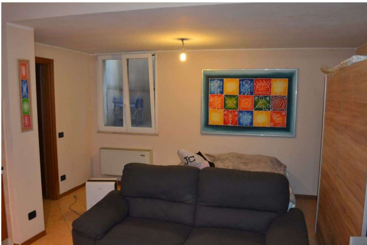
foto 2 – m.n. 658 sub 3 (taverna 1) – Una ragguardevole metratura al piano interrato è ricavata fuori sedime, come questo settore della taverna grande. Dove sporgenti rispetto al perimetro fuori terra, i locali hanno sempre altezze utili nette di poco superiori/inferiori ai 2,40m. Qui, come anche nel bagno e nell'altra taverna, le tinte acriliche si accompagnano a pavimenti in diagonale, con piastrelle ocre.
