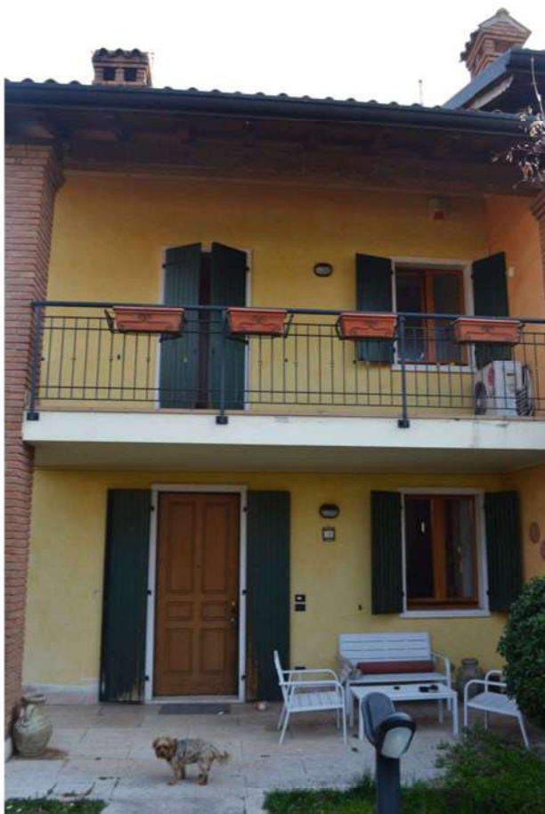
foto 3 - (sub 3) - Sul vialetto d'ingresso pedonale si prospettano i due piani abitabili fuori terra. Al pianterreno, dopo un portico sotto balcone, si imbecca l'ingresso principale. Tutte le aperture finestrate hanno quattro contorni marmorei bianchi e chiusure oscuranti a persiana verde scuro.
