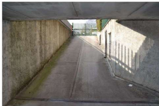
foto 17 - sub 9 (rampa garage) - Dal punto di presa delle foto esterne 7, 9 e 10 si imbocca lo scivolo d'accesso alle autorimesse.
