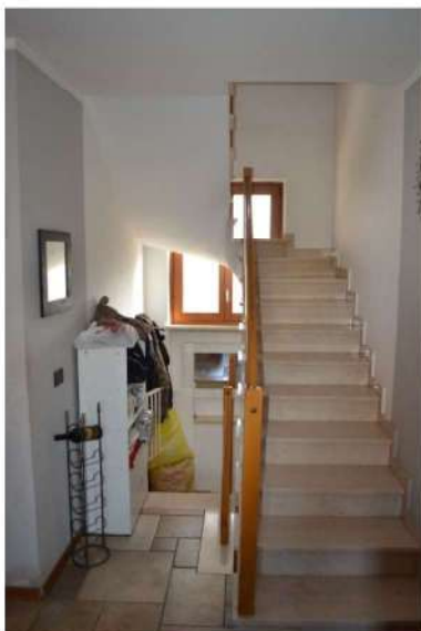
foto 3 - sub 3 (scale pT) – Tra i primi tre livelli utili le solette rampanti sono in cemento armato. Con ringhiere in legno massiccio.
