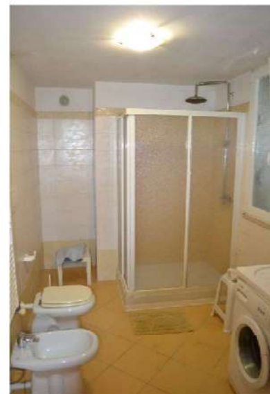
foto 5 - sub 3 (bagno 1) – Piastrelle in ceramica smaltata sino a circa 2,20m dal pavimento. Finitura su bocca di lupo.
