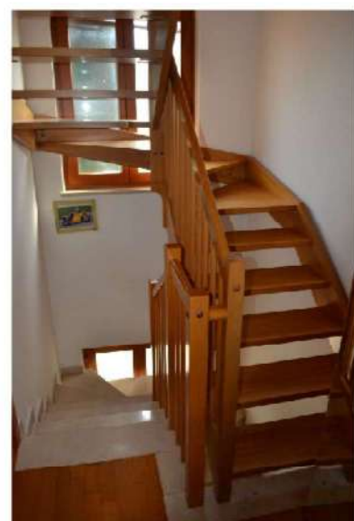
foto 10 - sub 3 (scale 1p) - Scale lignee non denunciate, di incerta collaudabilità, dirette alla mansarda pure assente in atti (cfr. foto 14).
