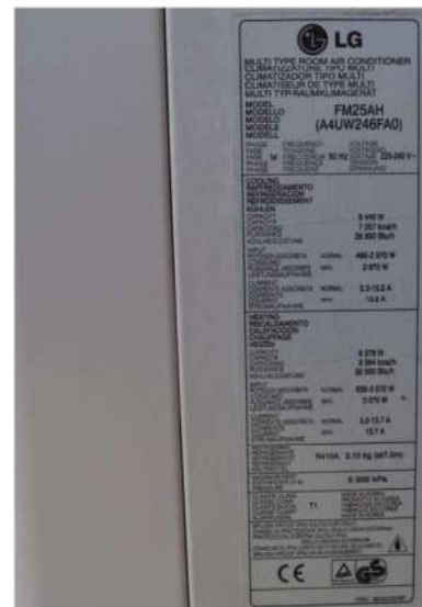
foto 22 - sub 3 (balcone) - Valori di targa della motocondensante sul balcone, marca LG e mod. FM25AH. Potenza 8,44/9,378 kW freddo/caldo. Sistema multisplit a espansione diretta, refrigerante R410A. Macchine interne rilevate nel soggiorno-cucina, nelle stanze da letto e nella mansarda sottotetto.
