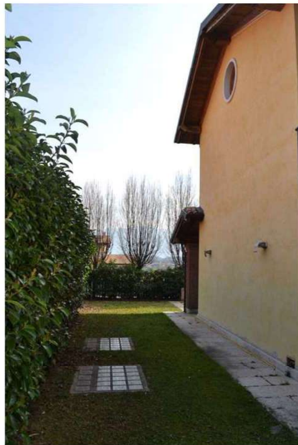
foto 4 - (sub 3) - Il lato nord del fabbricato, orlato da un camminamento pavimentato in pietra di Prun e col manto erboso interrotto da due lucernari in vetro-cemento, conduce al giardino sul retro oltre le siepi di cui alla foto n. 2. Le prese di luce e d'aria servono direttamente due locali al sottostrada.
