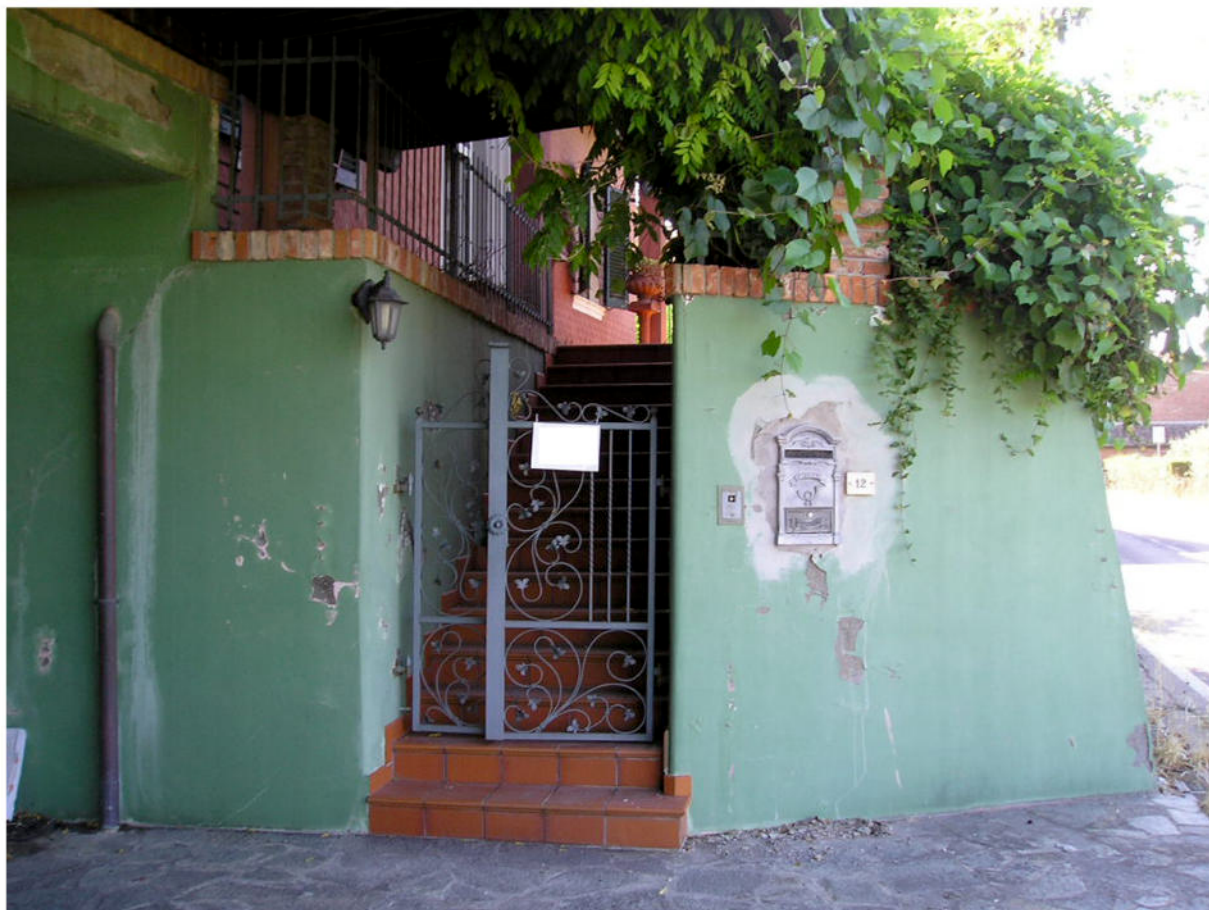
Fotografia 05 - Esterno Fabbricato / Ingresso
