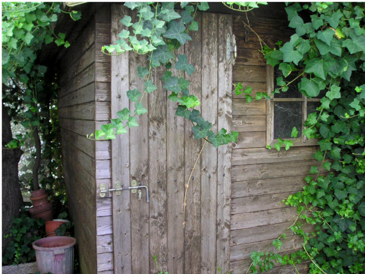
Fotografia 16 - Esterno Fabbricato / Manufatto in Legno
