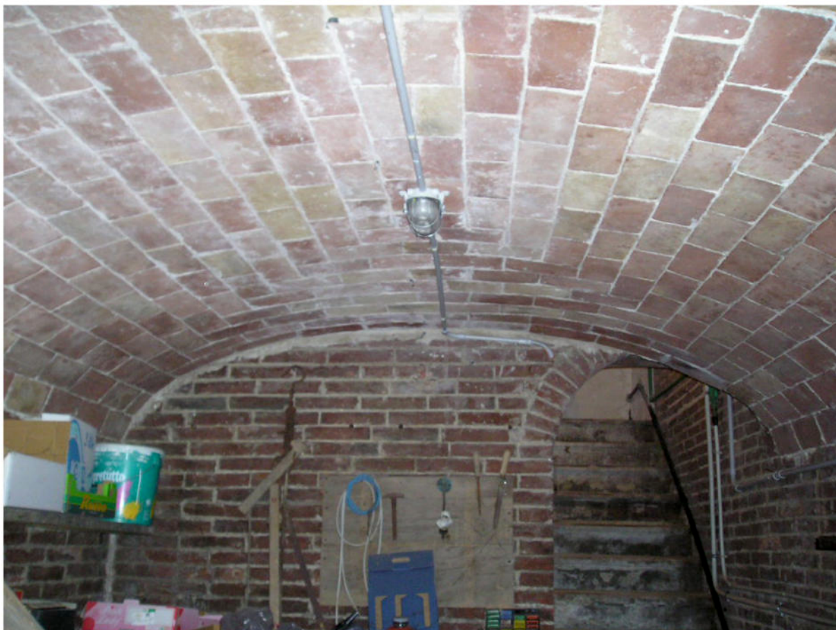
Fotografia 55 - Abitazione / Cantina P.S1 (Interrato)
