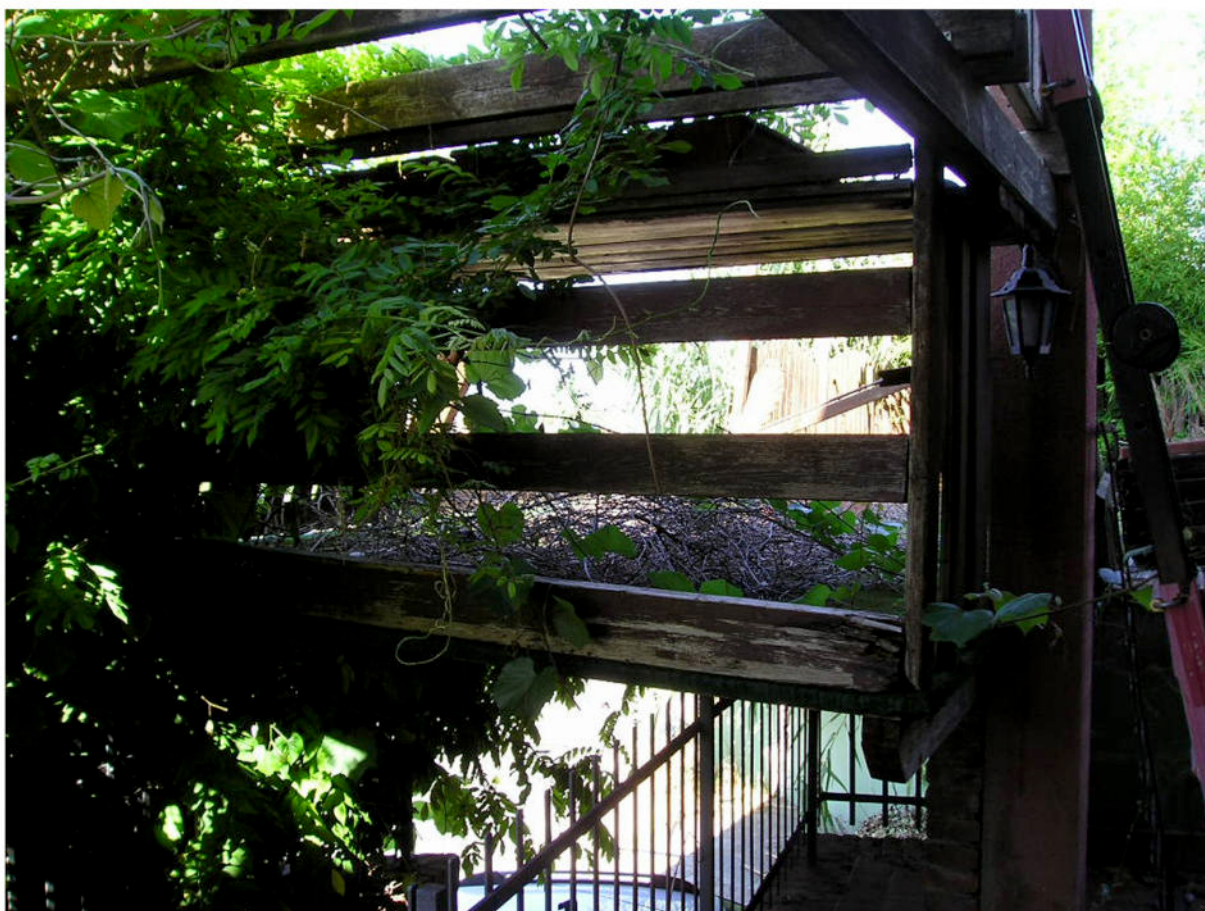
Fotografia 18 - Esterno Fabbricato / Pergola in Legno
