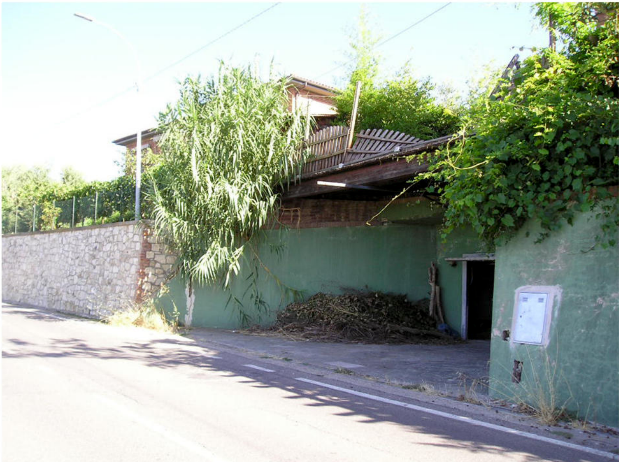
Fotografia 04 - Esterno Fabbricato / Ingresso
