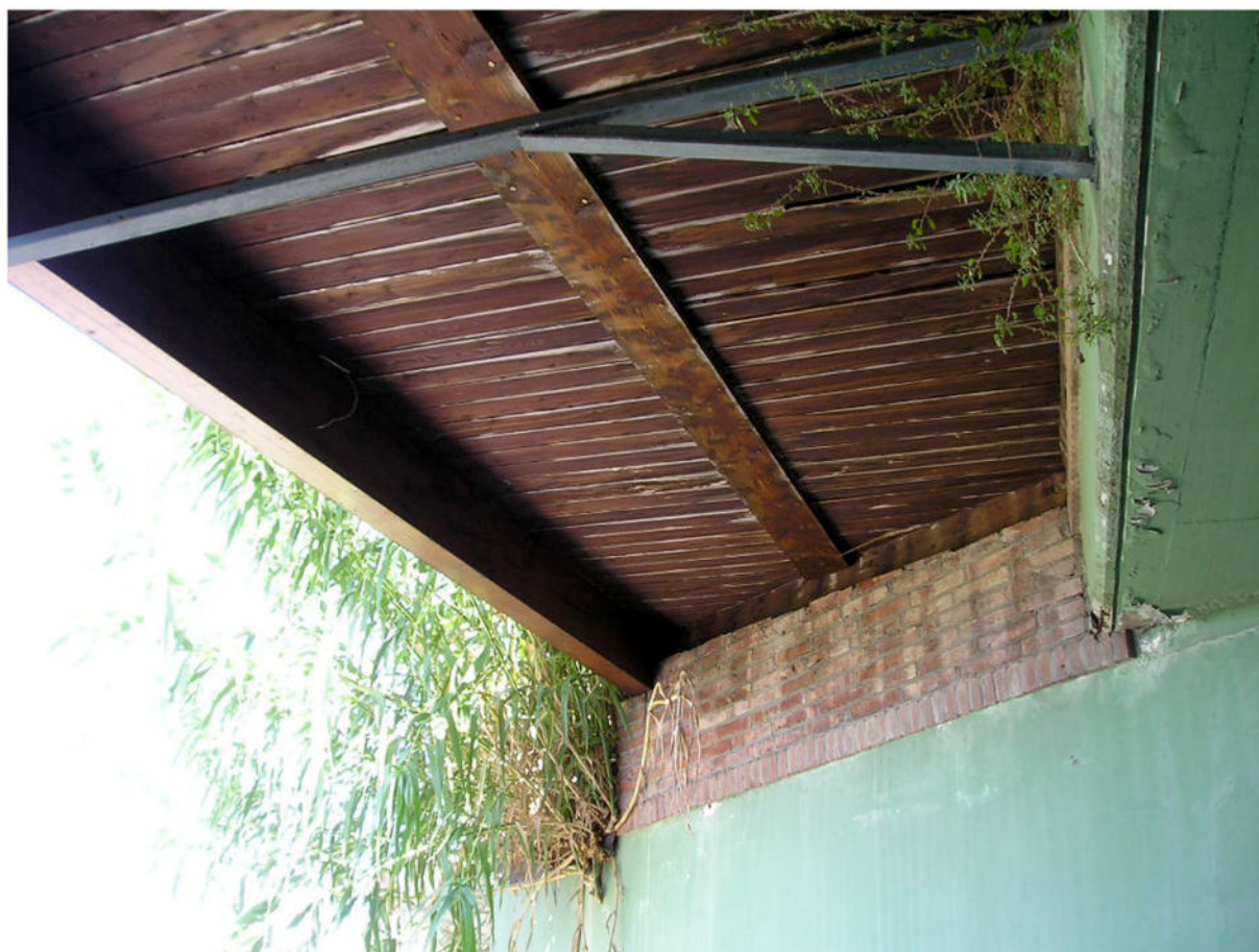
Fotografia 21 - Esterno Fabbricato / Pensilina in Legno
