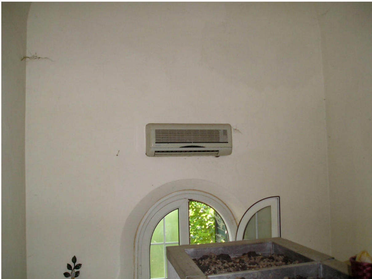
Fotografia 48 - Abitazione / Vano Scala P.1
