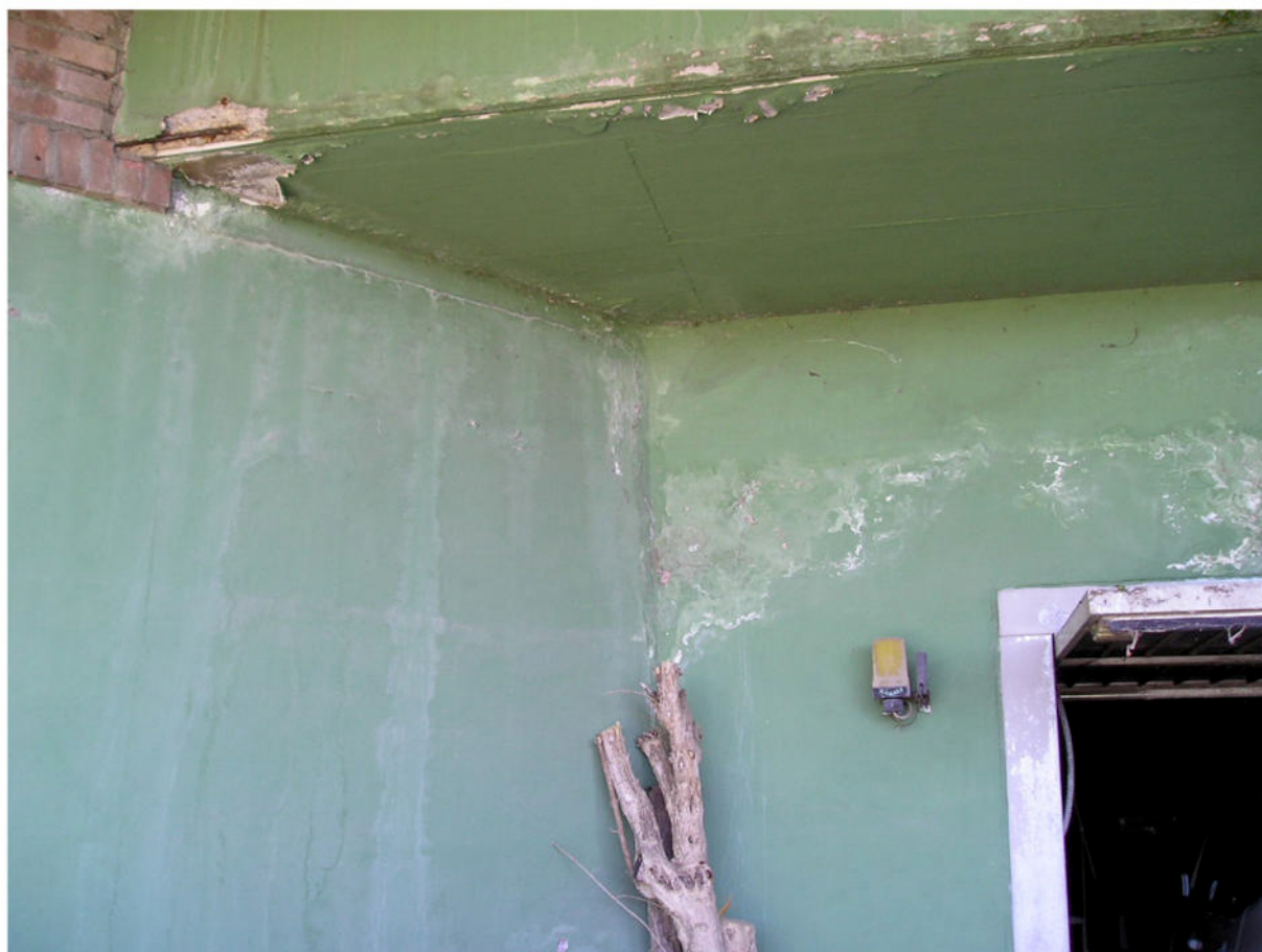
Fotografia 26 - Pensilina C.A. / Ingresso Autorimessa
