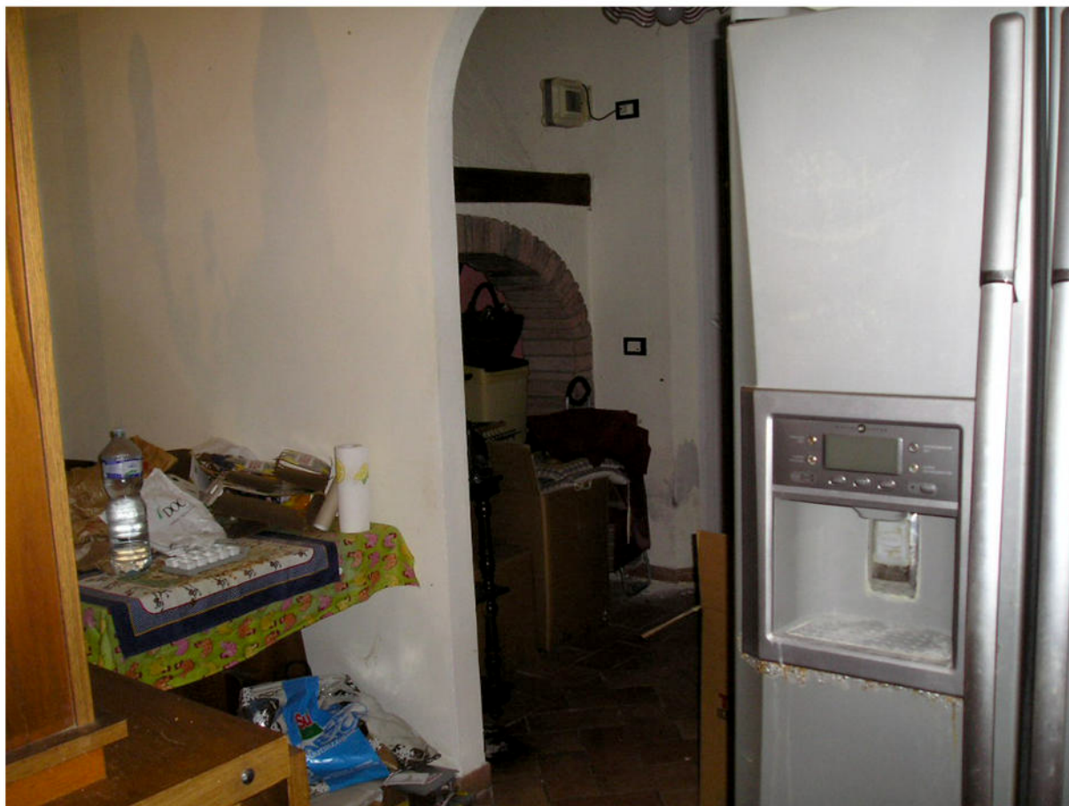
Fotografia 35 - Abitazione / Disimpegno Cucina P.T.
