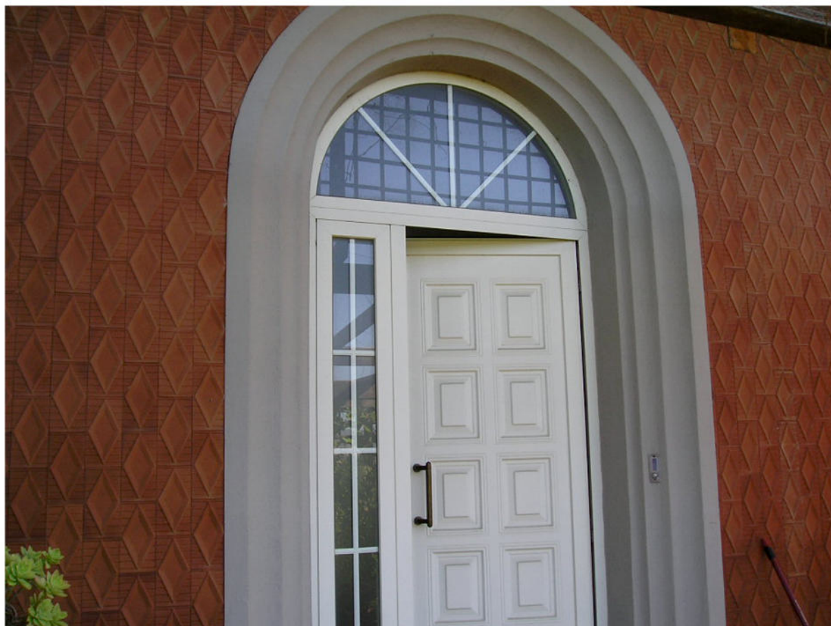
Fotografia 08 - Esterno Fabbricato / Ingresso
