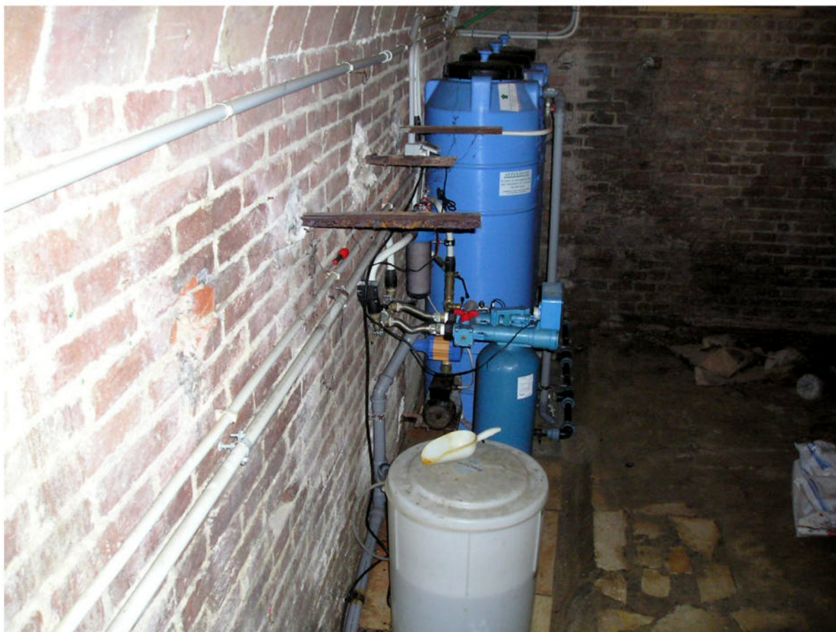
Fotografia 54 - Abitazione / Cantina P.S1 (Interrato)
