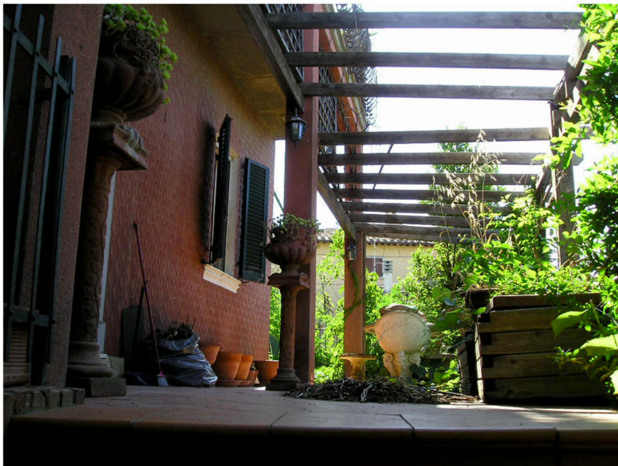
Fotografia 09 - Esterno Fabbricato / Resede Fronte Edificio
