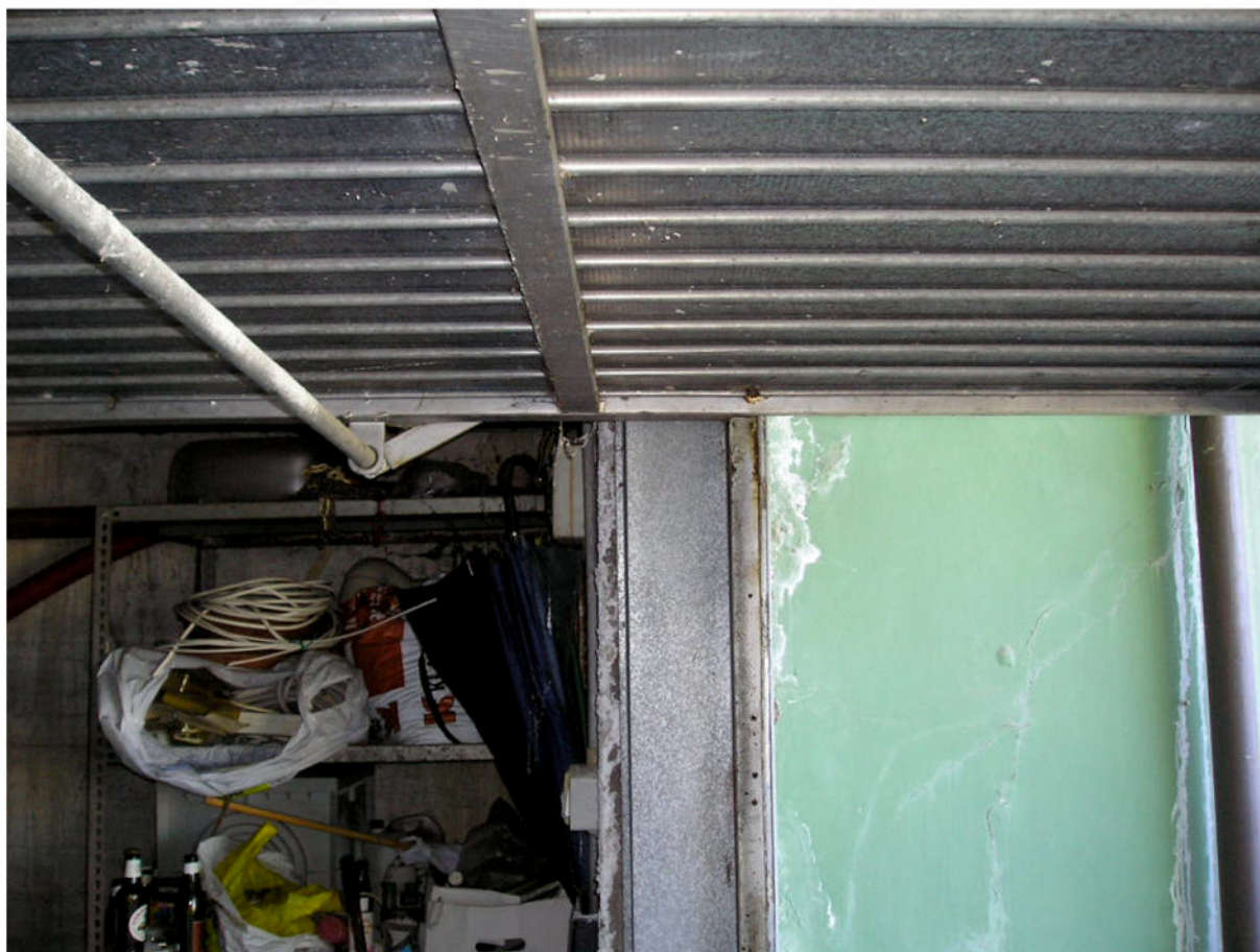
Fotografia 29 - Autorimessa / Porta Basculante
