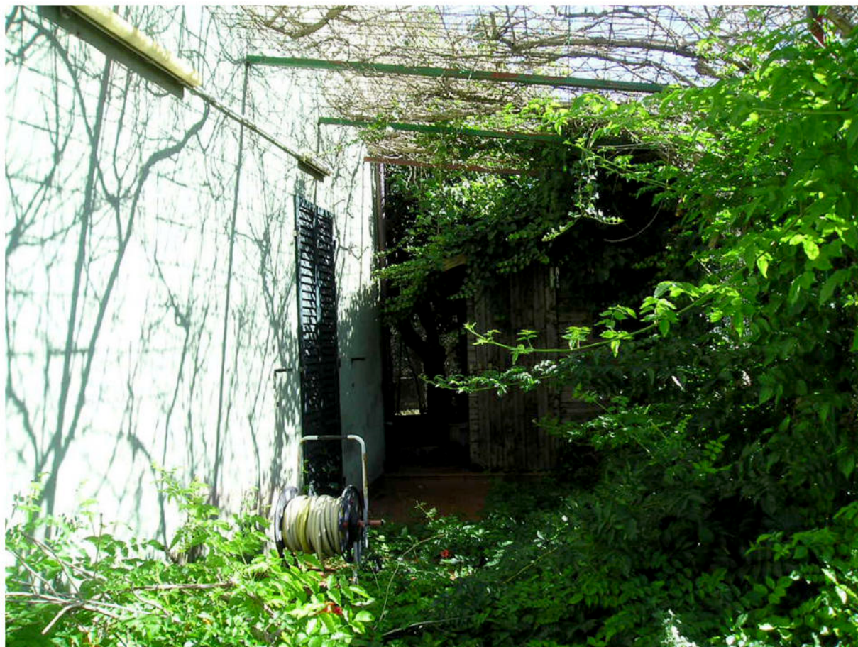
Fotografia 13 - Esterno Fabbricato / Resede
