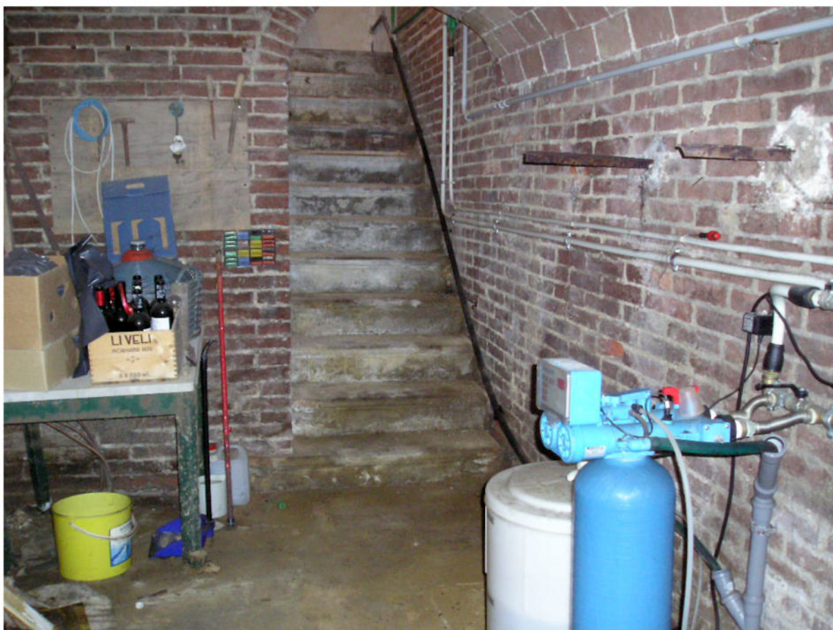
Fotografia 56 - Abitazione / Cantina P.S1 (Interrato)
