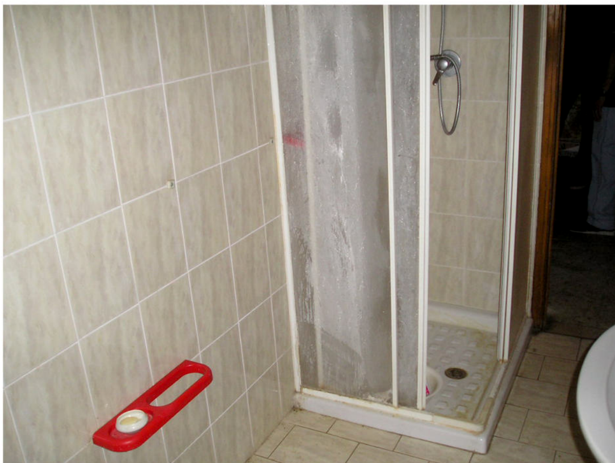
Fotografia 50 - Abitazione / Servizio Igienico P.1
