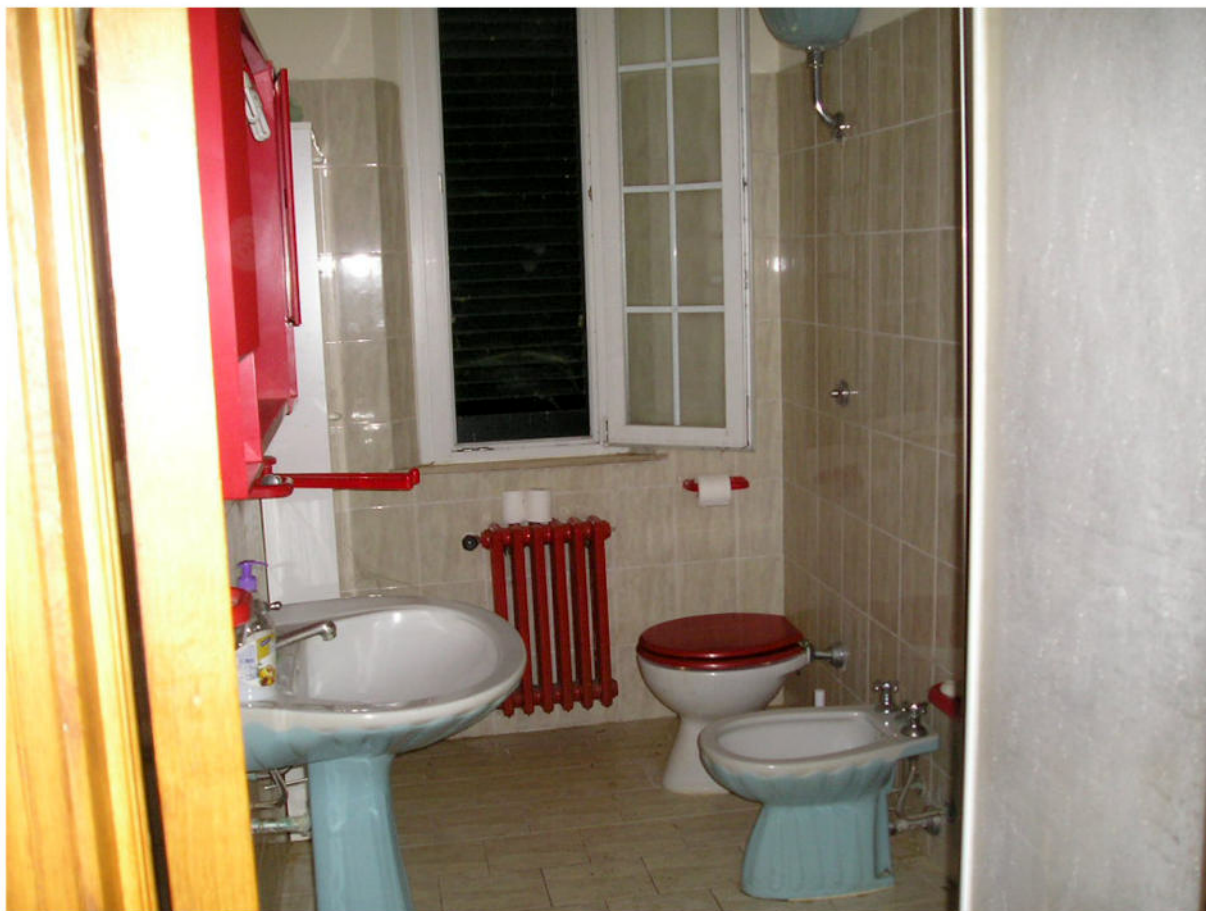
Fotografia 49 - Abitazione / Servizio Igienico P.1
