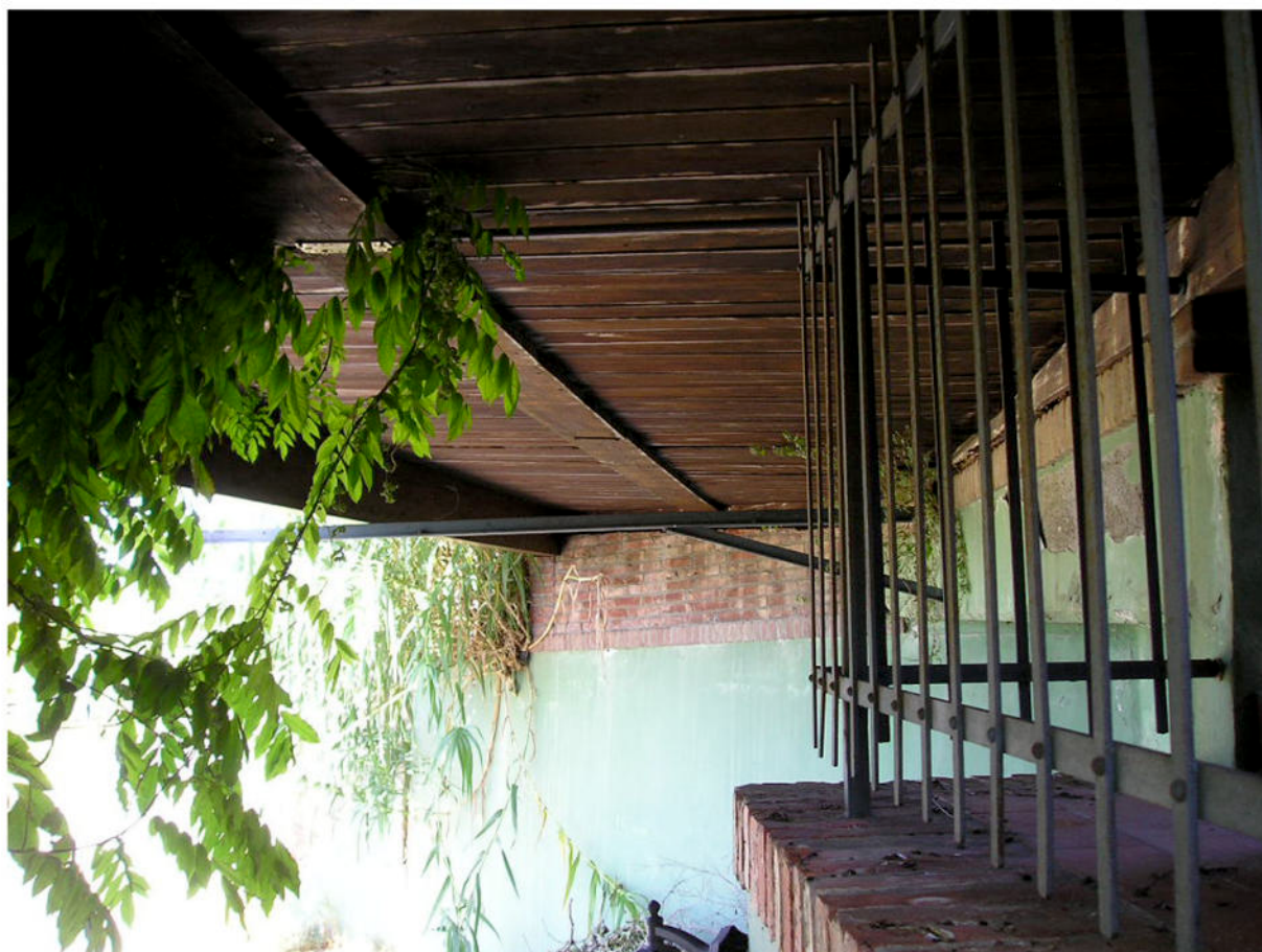
Fotografia 22 - Esterno Fabbricato / Pensilina in Legno
