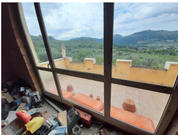
Sottotetto da adeguare
