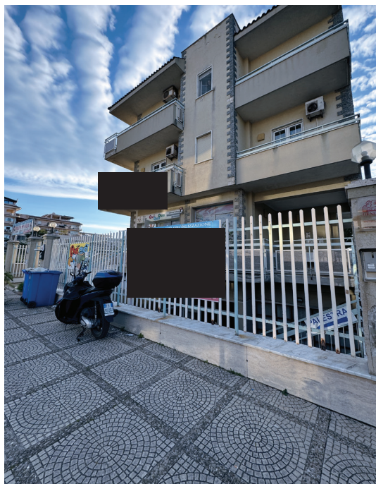
Foto 1. Prospetto principale del fabbricato, su via Giuseppe Bagnera, 19.
