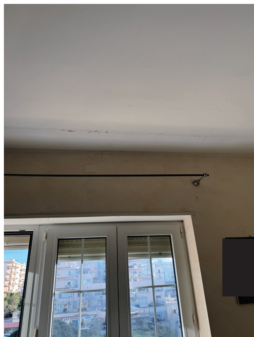
Foto 28. Distacchi d'intonaco.
