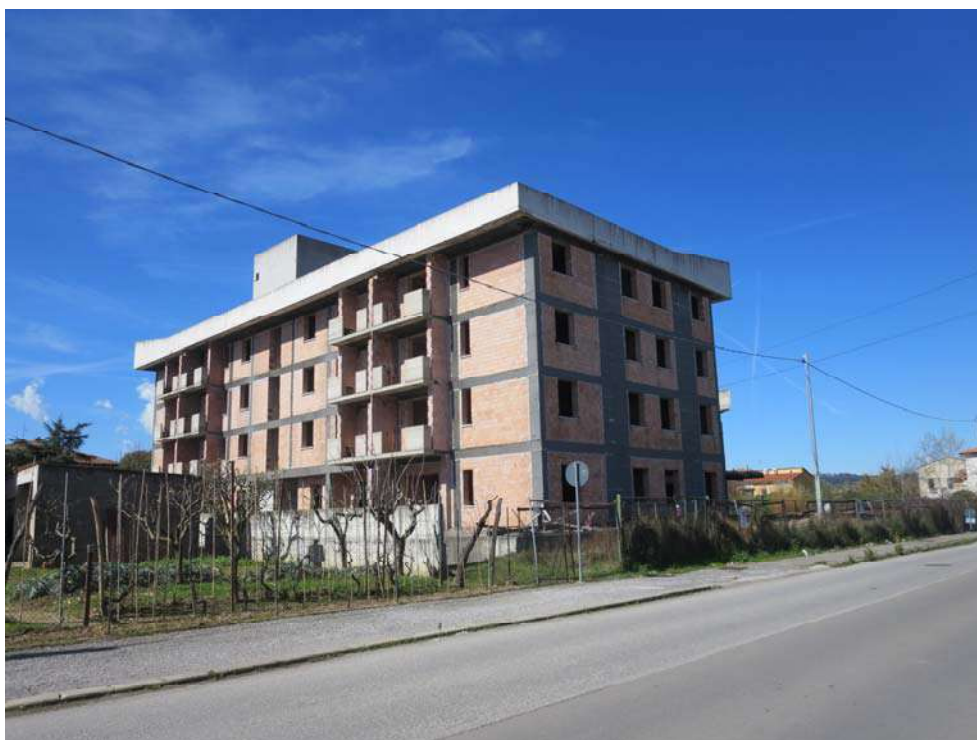
VISTA SUD / EST
