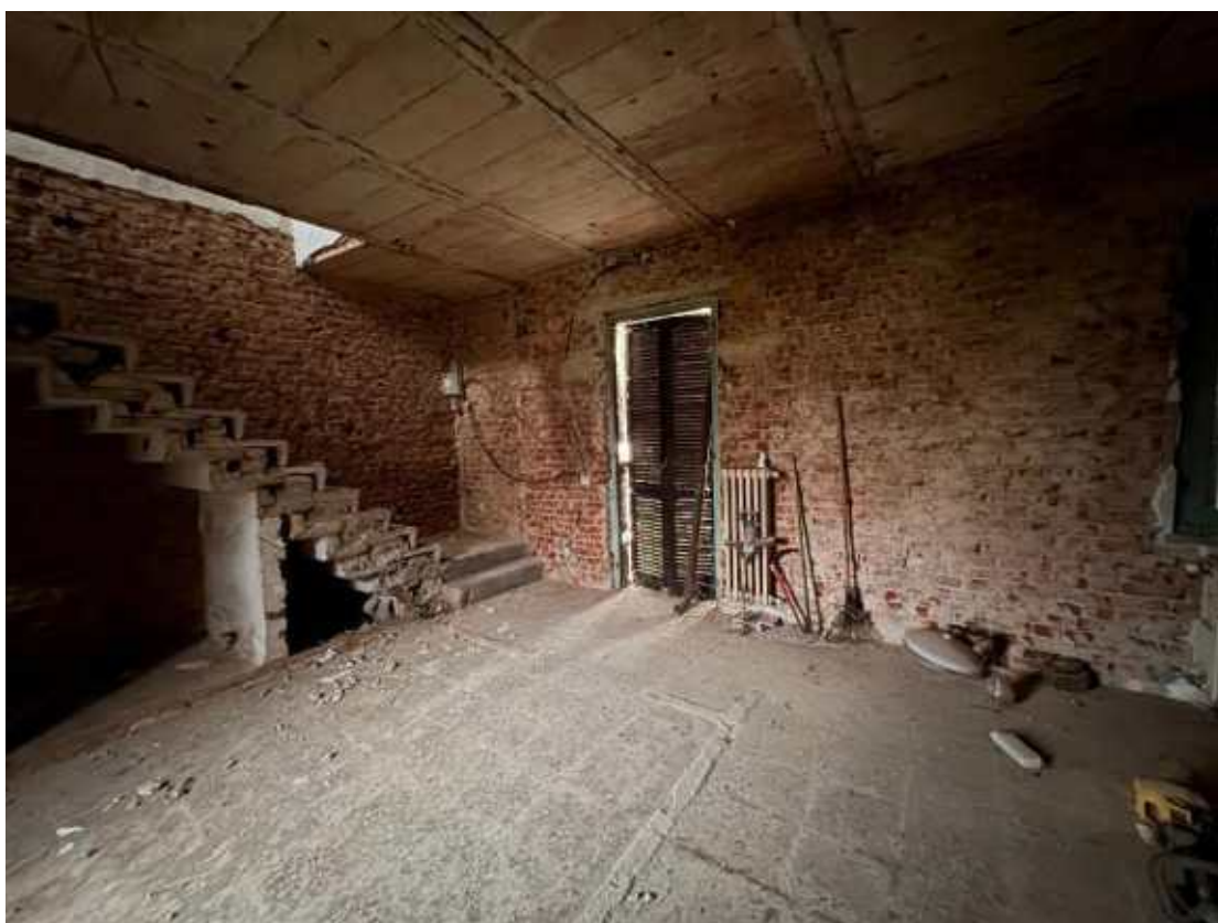
Soggiorno e Cucina (demolite tramezze) – altra vista
