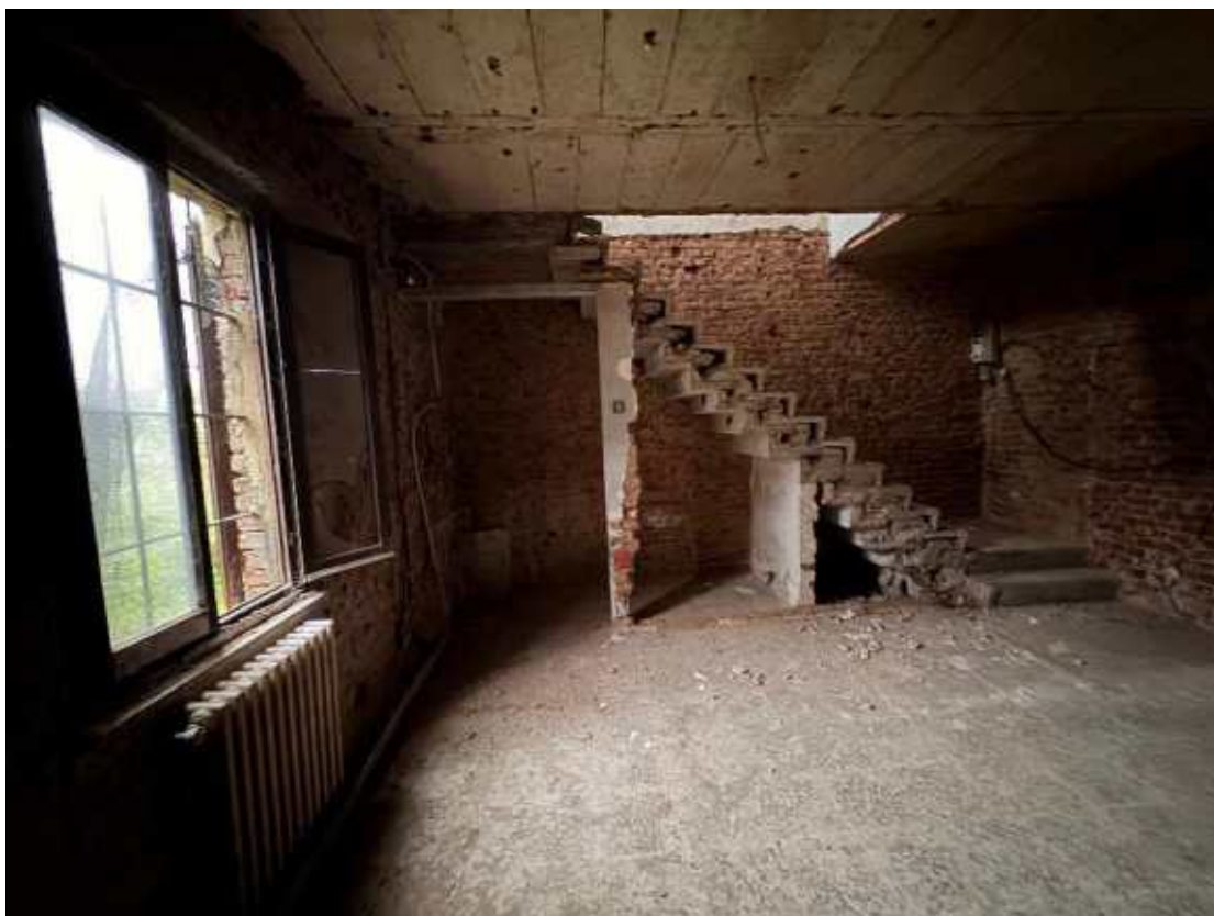
Soggiorno e Cucina (demolite tramezze) – altra vista
