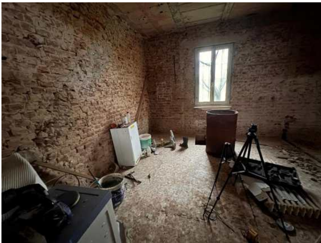
Piano Terra – locale soggiorno: tramezza verso cucina demolita (altra vista)
