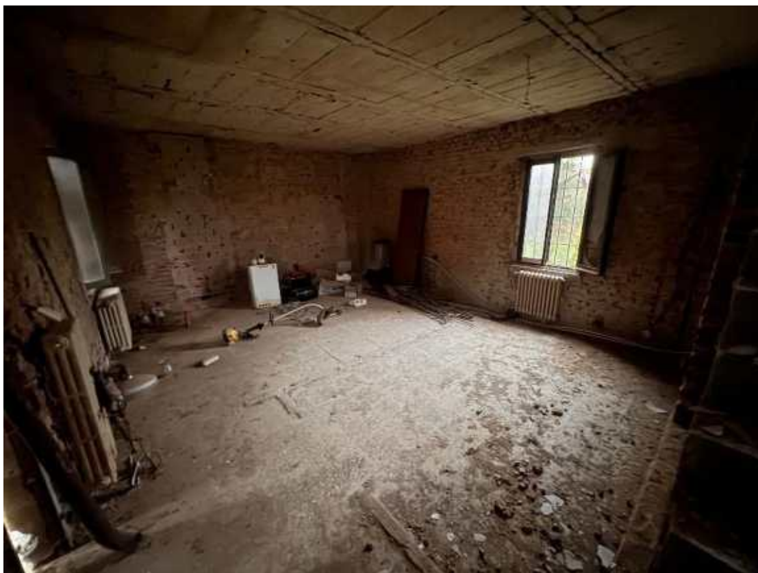
Soggiorno e Cucina (demolite tramezze) – altra vista
