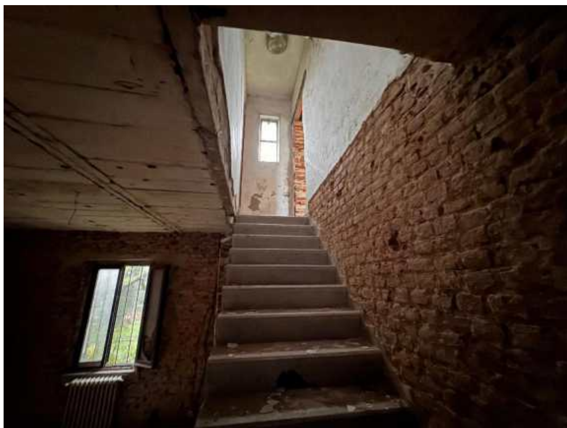
Scala che conduce al piano primo
