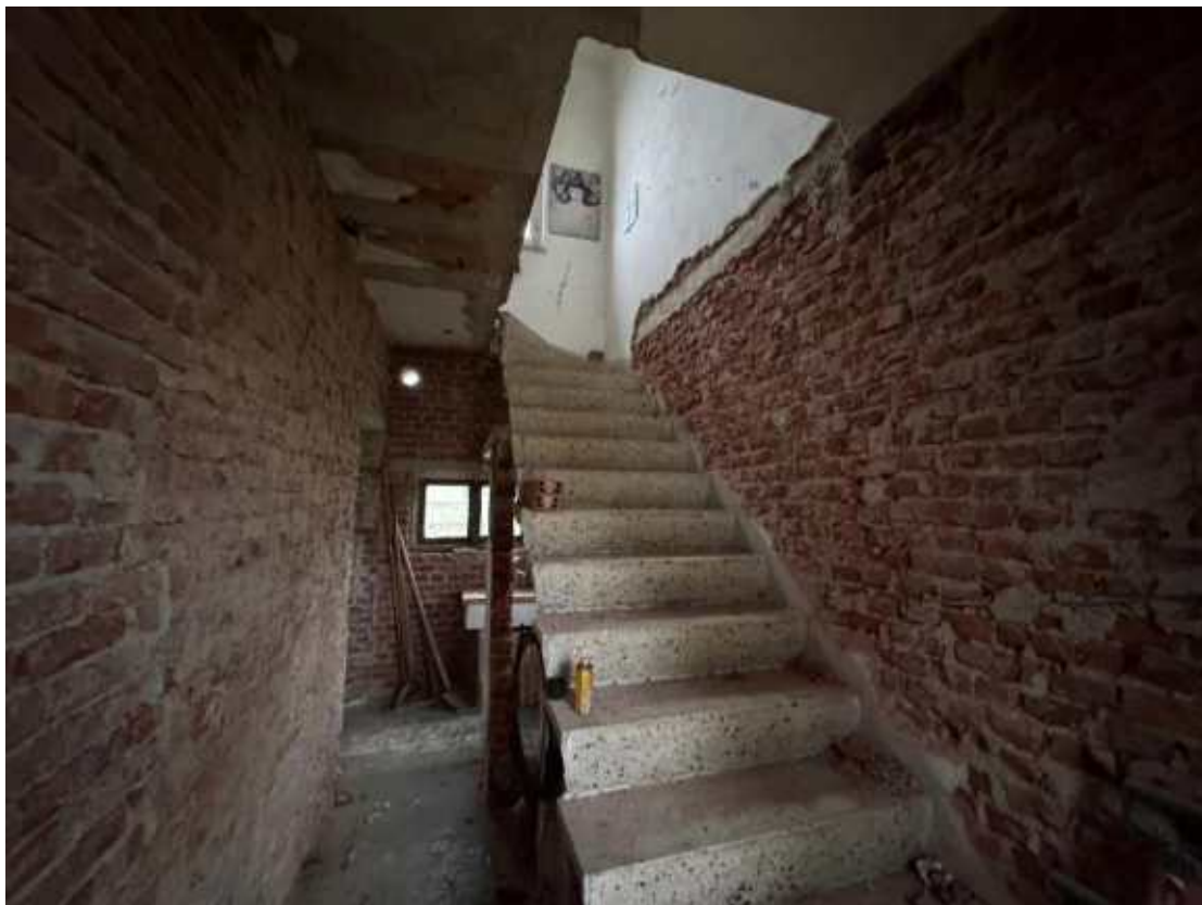
Scala di accesso la piano primo
