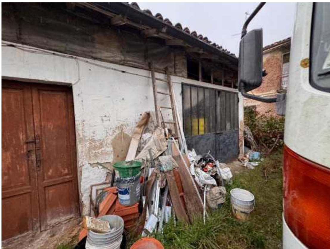
Vista Esterno Autorimessa – Deposito – altra vista
