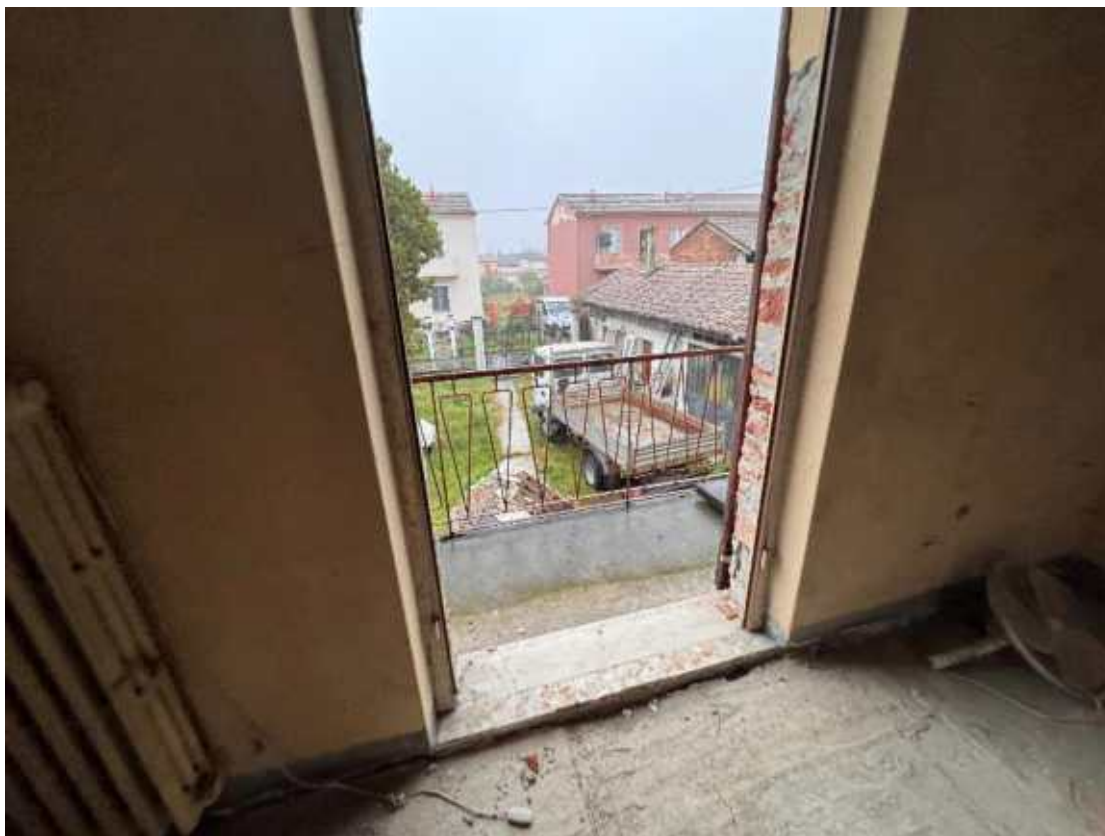
Camera da Letto – accesso al poggiolo
