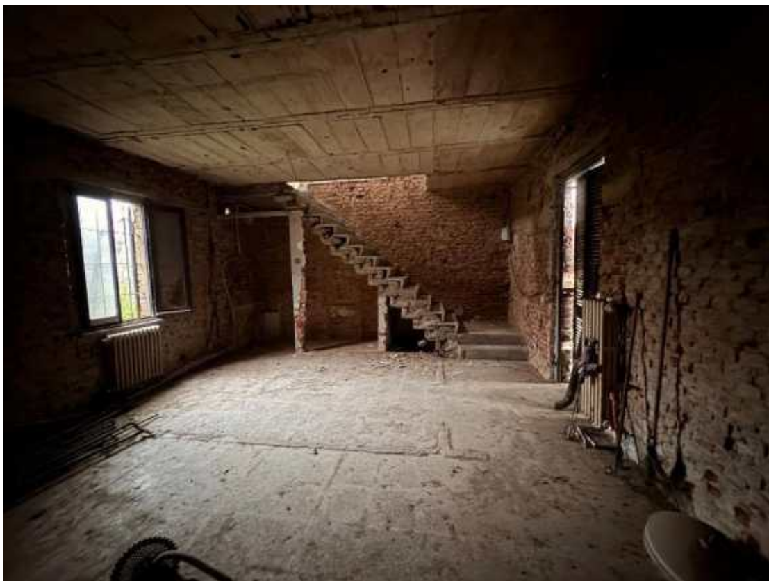
Soggiorno e Cucina (demolite tramezze) – altra vista
