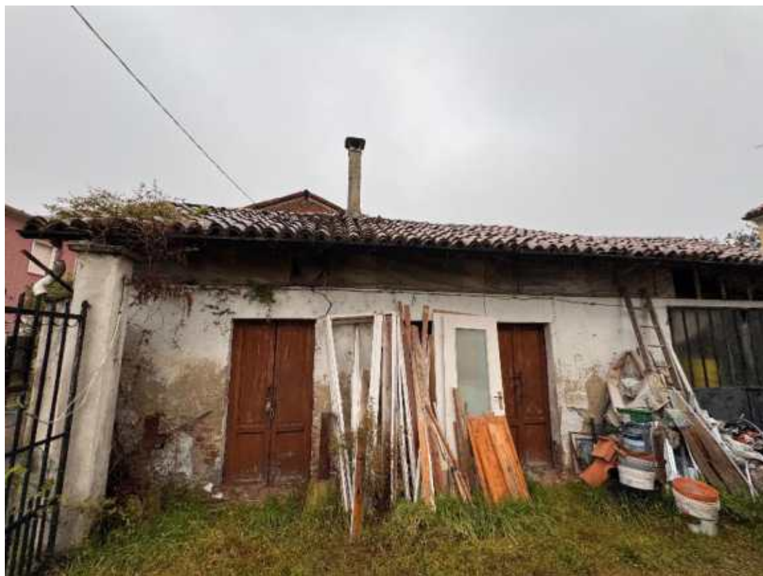
Vista Esterno Autorimessa - Deposito
