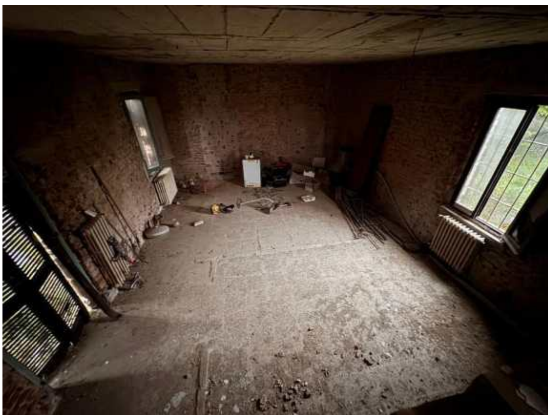
Soggiorno e Cucina (demolite tramezze)
