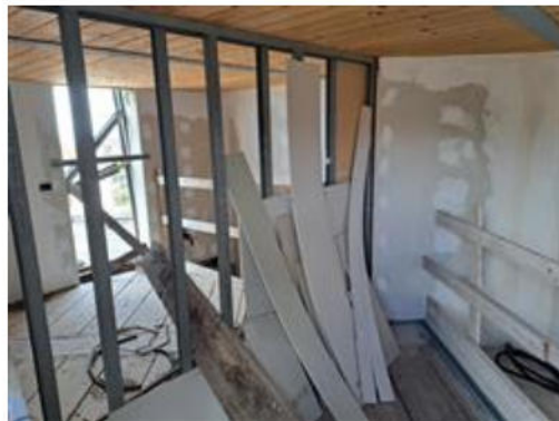
06.INTERNO LOCALE ACCESSORIO P.5 - SUB_14
