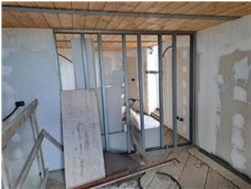
06.INTERNO LOCALE ACCESSORIO P.5 - SUB_15
