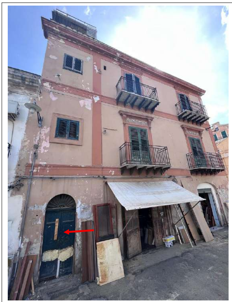
Foto n. 1. Prospetto su Piazza Vincenzo Linares del fabbricato di cui fanno parte i beni pignorati. Con la freccia è indicato il portone di ingresso dal civ. 6 di Piazza Linares ai beni oggetto di pignoramento ubicati al primo e secondo piano e identificati al sub. 13 e sub. 16
