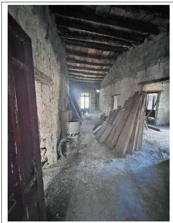
Foto n. 25. Immobile identificato al sub. 16. Ambiente di ingresso con affaccio su Vicolo II del Celso
