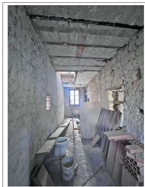
Foto n. 21-22. Scala comune con accesso da Piazza Linares n. 6. Rampa che conduce all'immobile identificato al sub. 16 al secondo piano.
