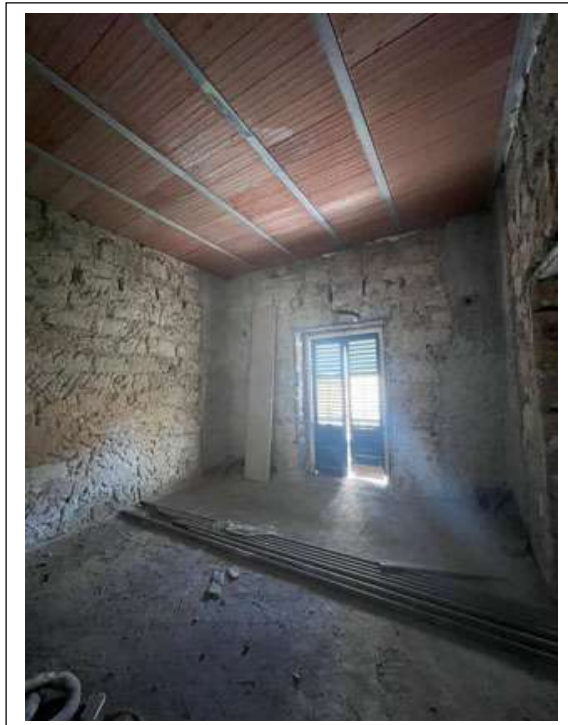
Foto n. 12-13. Immobile identificato al sub. 13. Ambiente di ingresso con affaccio su Vicolo II del Celso
