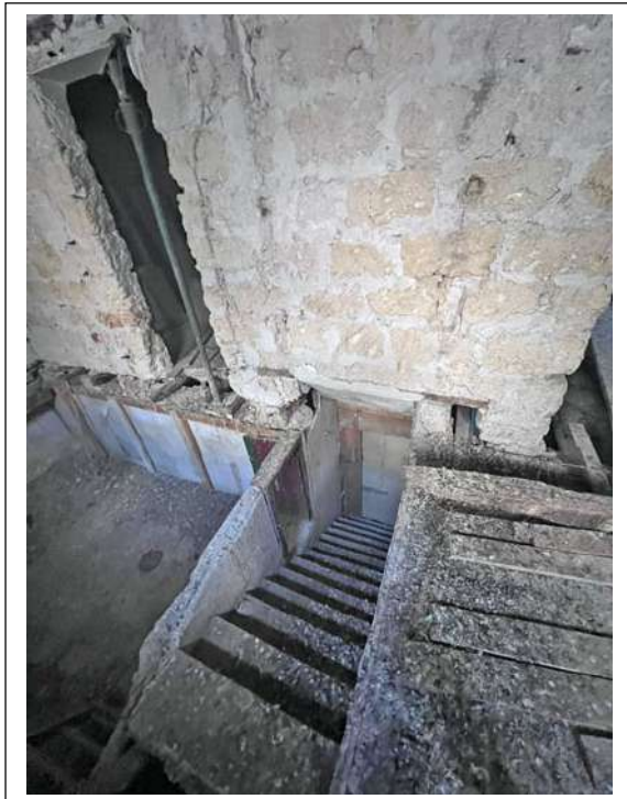
Foto n. 8-9. Scala con accesso da Vicolo II del Celso n. 7 che conduce ai beni pignorati del secondo piano del fabbricato (sub. 14 e sub. 15)
