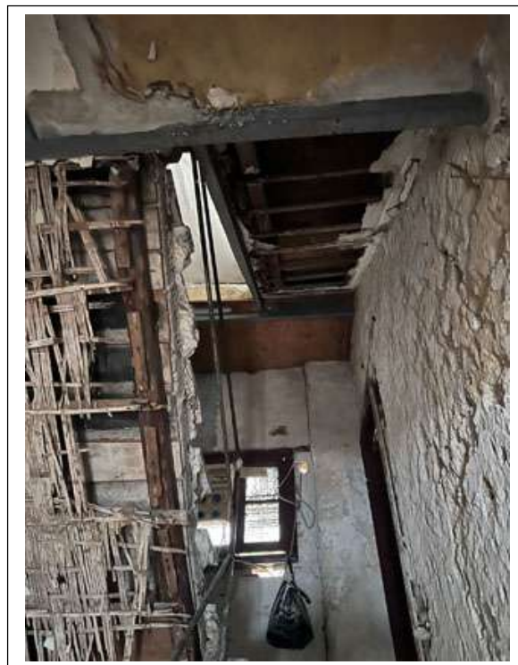
Foto n. 4-5. Scala con accesso da Piazza Linares n. 6 che conduce ai beni pignorati del primo e secondo piano del fabbricato (sub. 13 e sub. 16)
