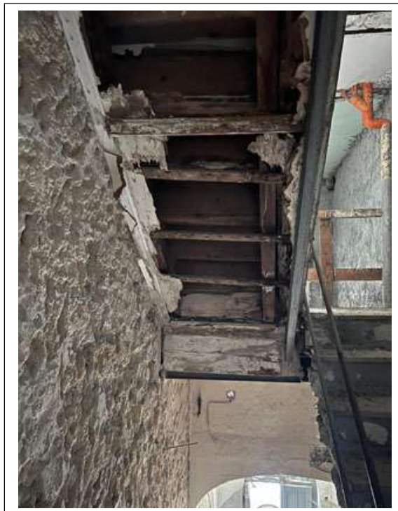
Foto n. 6-7. Scala con accesso da Piazza Linares n. 6 che conduce ai beni pignorati del primo e secondo piano del fabbricato (sub. 13 e sub. 16)
