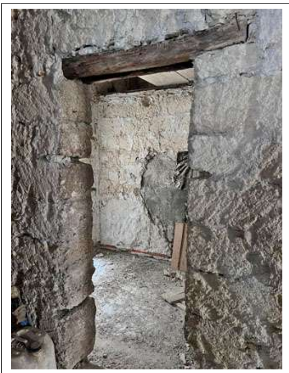
Foto n. 15. Immobile identificato al sub. 13. Apertura di collegamento tra l'ambiente di ingresso e il vano indicato come cucina nella planimetria catastale di impianto
