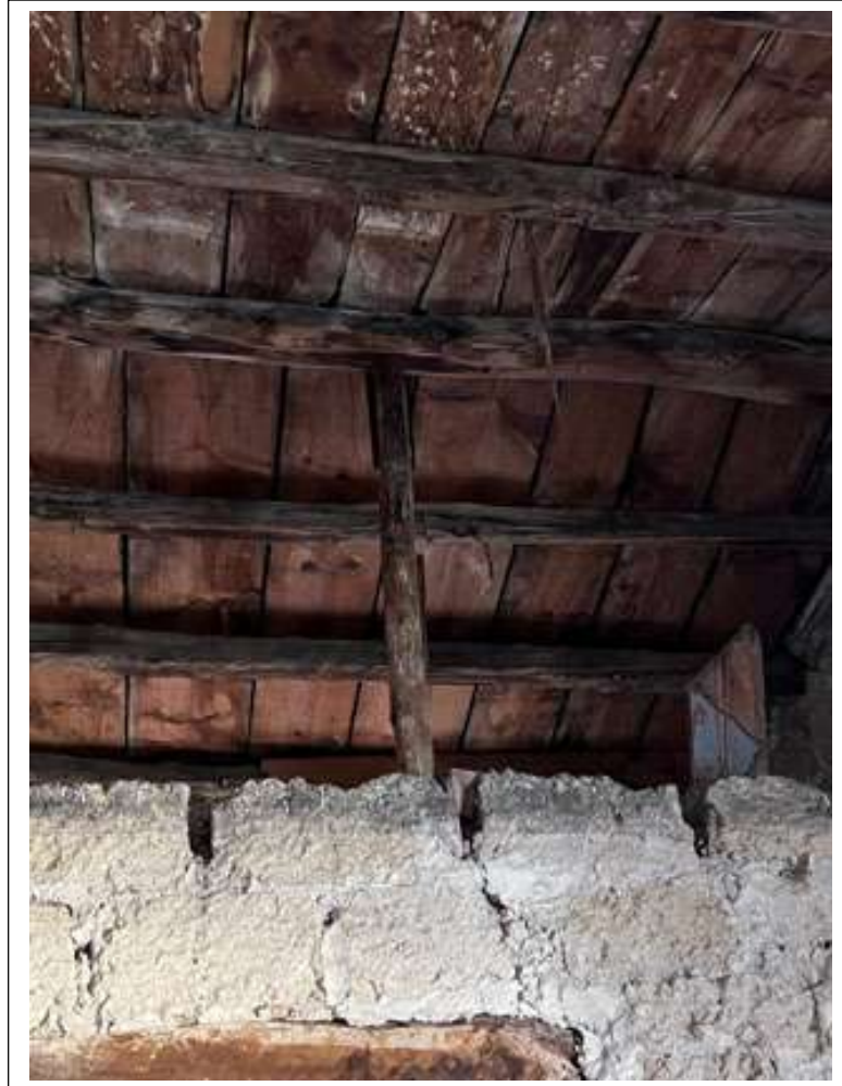
Foto n. 32. Particolare della copertura lignea con puntello di sostegno
