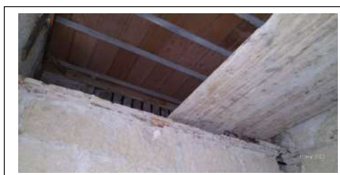
Foto n. 19-20. Immobile identificato al sub. 13. Soppalco/ripostiglio del vano indicato come cucina nella planimetria catastale di impianto
