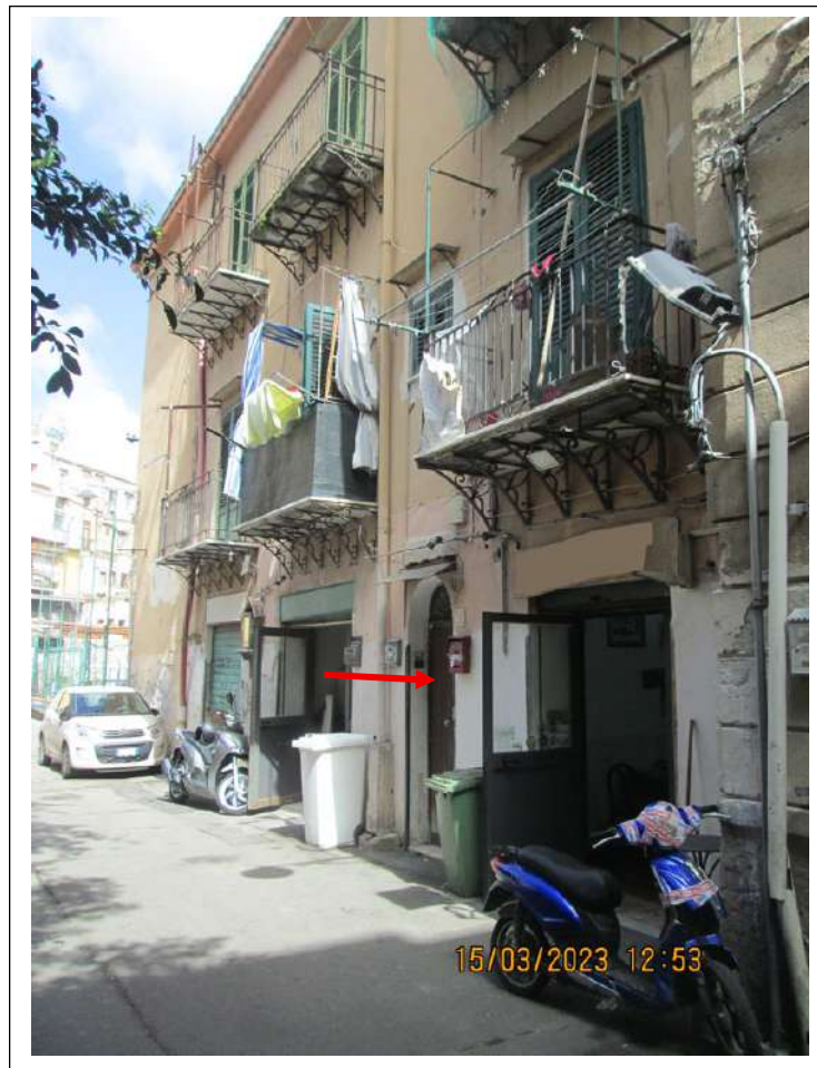
Foto n. 2. Prospetto su Vicolo II del Celso del fabbricato di cui fanno parte i beni pignorati. Con la freccia è indicato il portone di ingresso dal civ. 7 ai beni oggetto di pignoramento identificati ai sub. 14 e sub. 15 e ubicati al secondo piano
