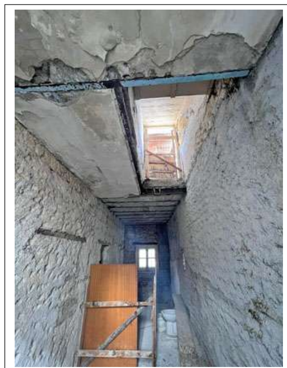
Foto n. 23-24. Scala comune con accesso da Piazza Linares n. 6. Rampa che conduce all'immobile identificato al sub. 16 al secondo piano. E' visibile l'ingresso alla terrazza del terzo piano non accessibile per l'assenza dell'ultima rampa
