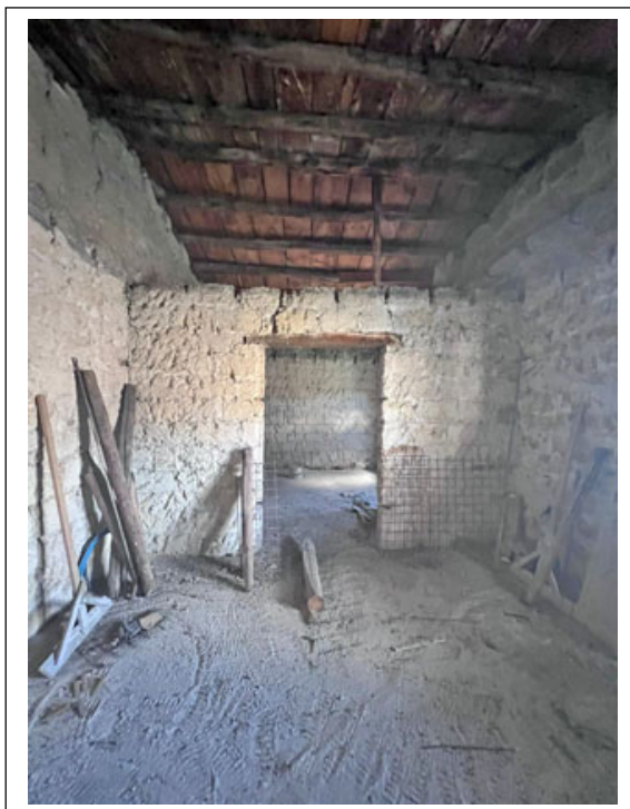
Foto n. 30. Immobile identificato al sub. 16. Apertura di collegamento tra i vani prospettanti su Piazza Linares
