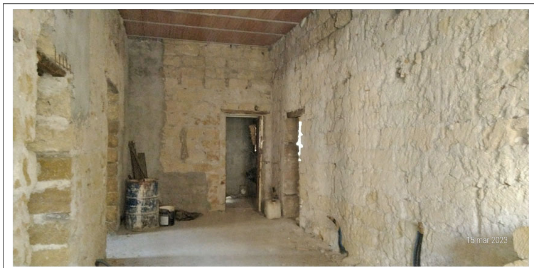
Foto n. 21-22. Immobile identificato al sub. 13. Ambiente di ingresso. Aperture di collegamento con i vani prospettanti su Piazza Linares e sulla chiostрина interna al fabbricato
