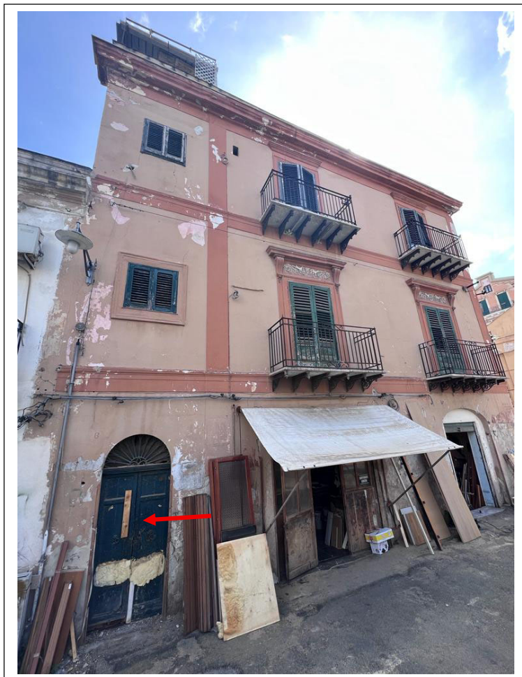
Foto n. 1. Prospetto su Piazza Vincenzo Linares del fabbricato di cui fanno parte i beni pignorati. Con la freccia è indicato il portone di ingresso dal civ. 6 ai beni oggetto di pignoramento identificati ai sub. 13 e sub. 16
