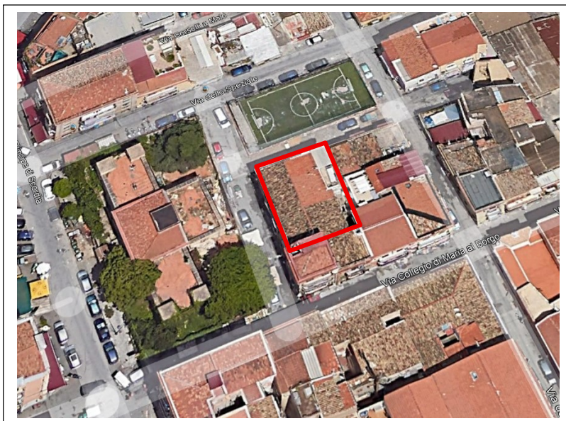
Ortofoto attuale (da Google Earth). In rosso è individuato il fabbricato insistente sulla p.lla 53 del fg. 120 di cui fa parte il bene pignorato
