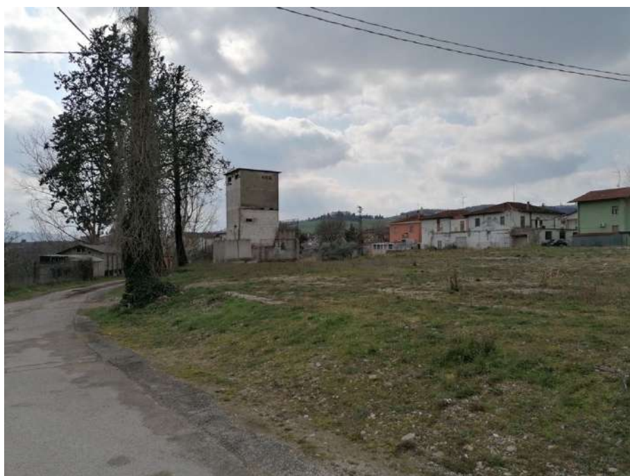
4 Vista da nord-est dell'area urbana edificabile (sono visibili la cabina Enel, il retro dei due fabbricati e la traccia della demolizione opificio a contatto con fabbricati);
