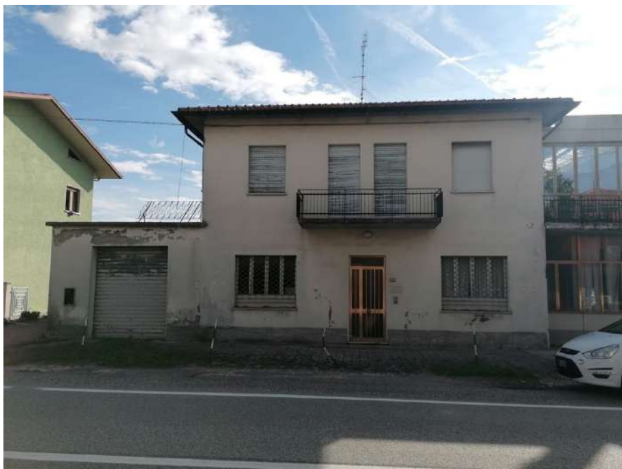
17 Prospetto su Via Provinciale Feltresca immobili mapp134 sub14 e 15, civico n.52;
