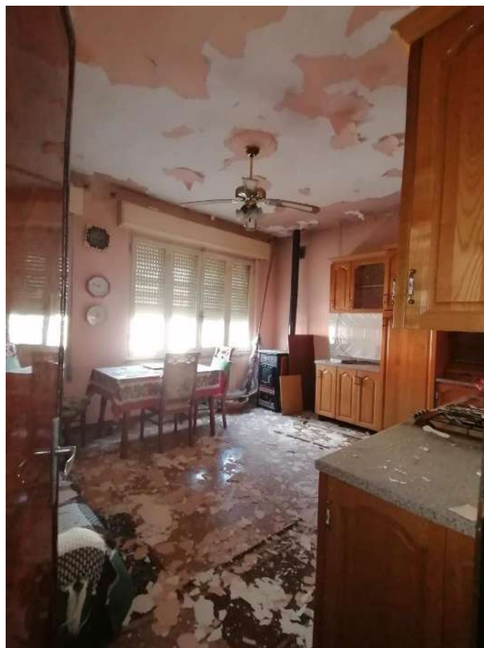
23 Vista vano sala con affaccio su Via Provinciale Feltresca, appartamento piano primo (mapp.134 sub15);
