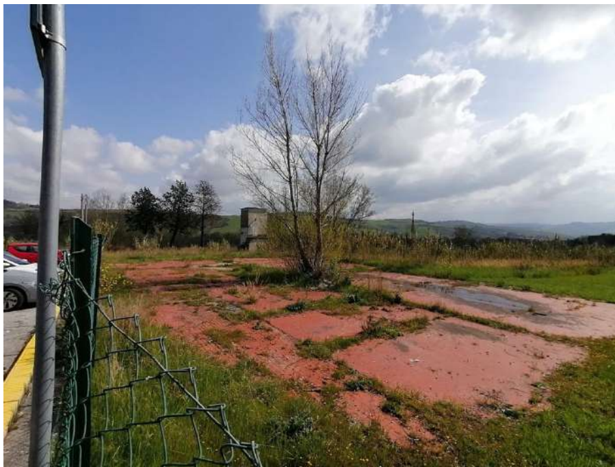
7 Vista residuo di porzione pavimentazione ex opificio (vista panoramica “da est a sud” aperta sul 75% dei confini) mapp 134 sub 18;
