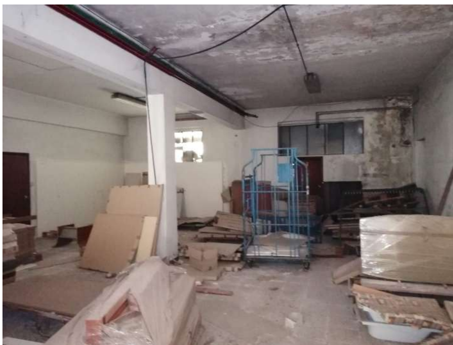
18 Scorcio interno del deposito al piano terra mapp.134 sub14;
