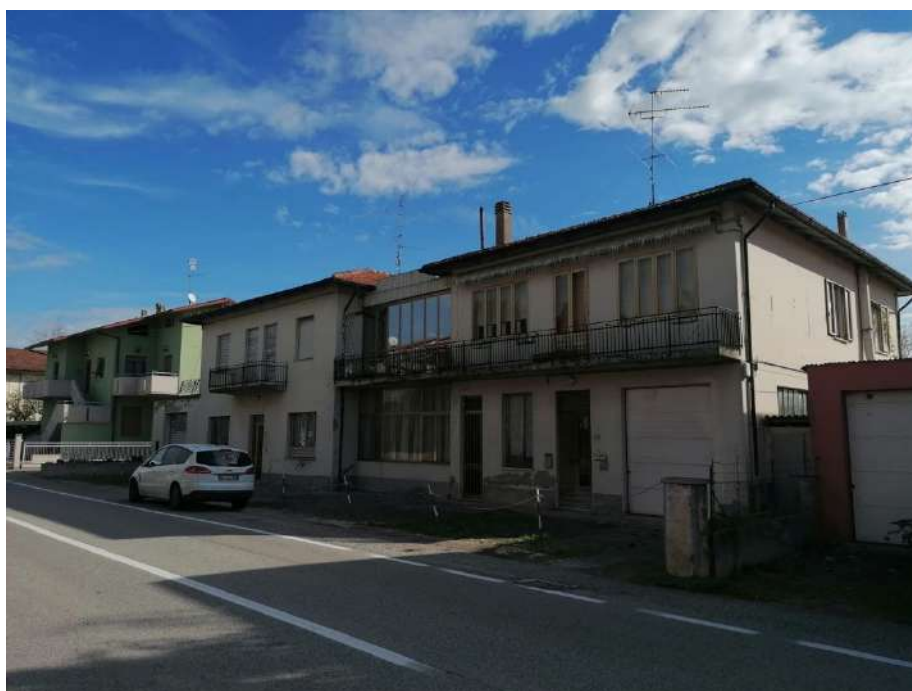
10 Scorcio da Via Provinciale Feltresca dei fronti strada degli immobili civico 52 ( MF.11 mapp.134 sub.12-14-15-16 );
