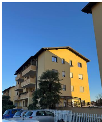
Vista prospetto Ovest
