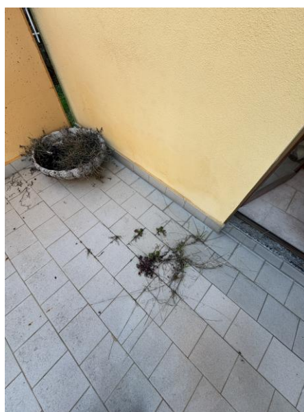
Vista stato manutentivo del terrazzo
