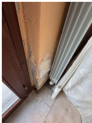
Particolari stato di conservazione del locale camera matrimoniale, presenza di efflorescenze e muffe
