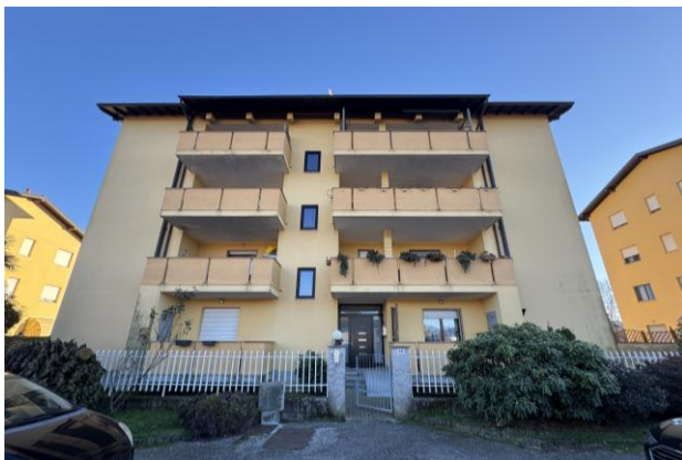
Vista Condominio GRUA EDIFICIO C da via Mora e Gibin
