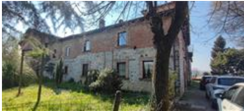
vista esterna con particolare dell'area esclusiva
