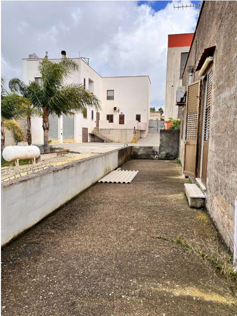
Foto 14 – Vista sulla veranda scoperta esterna nella parte posteriore dell'immobile
