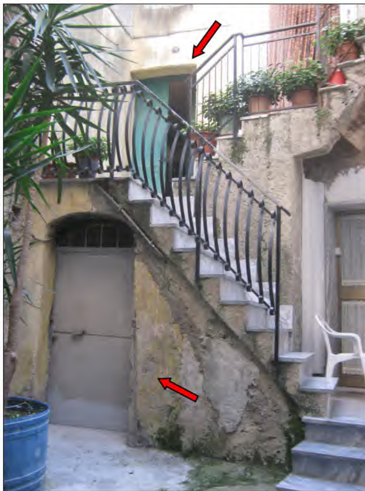
Figura n. 4 – Vista dall’atrio interno al fabbricato di interesse degli ingressi ai locali costituenti l’u.i. identificata in catasto al Foglio 35, P.lla 438, Sub. 5 (freccie rosse).
