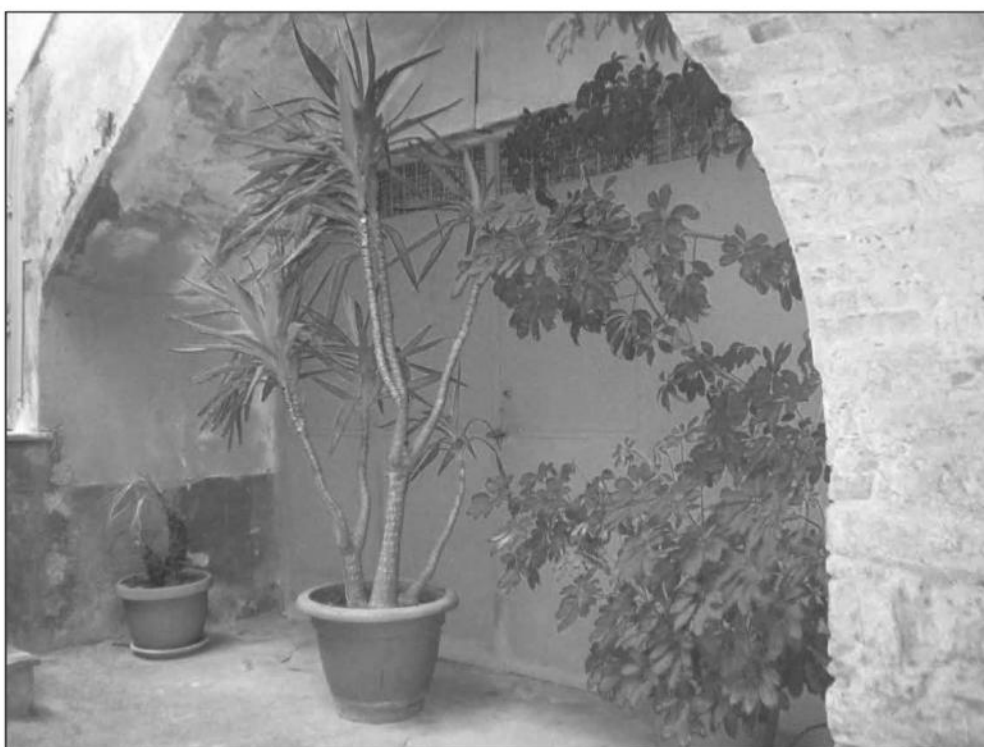
FOTO n. 11 – Particolare dell'ingresso secondario al locale negozio collocato nell'atrio interno comune del fabbricato di via Garibaldi, costituito da una porta metallica a doppio battente.
