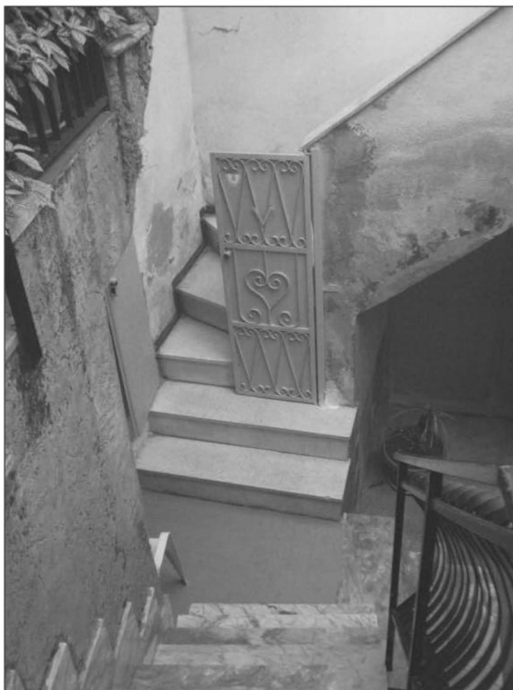
FOTO n. 17 – Altra vista delle scale esterne, in parte di uso comune ed in parte ad uso esclusivo del debitore, che consentono l'accesso all'abitazione dal primo ingresso e che immette direttamente nell'ambiente "Soggiorno" appartenente alla u.i. al Primo Piano di cui al Foglio 35, P.lla 438, Sub. 3. Le scale ad uso esclusivo del debitore sono delimitate da un cancelletto metallico dotato di serratura.
