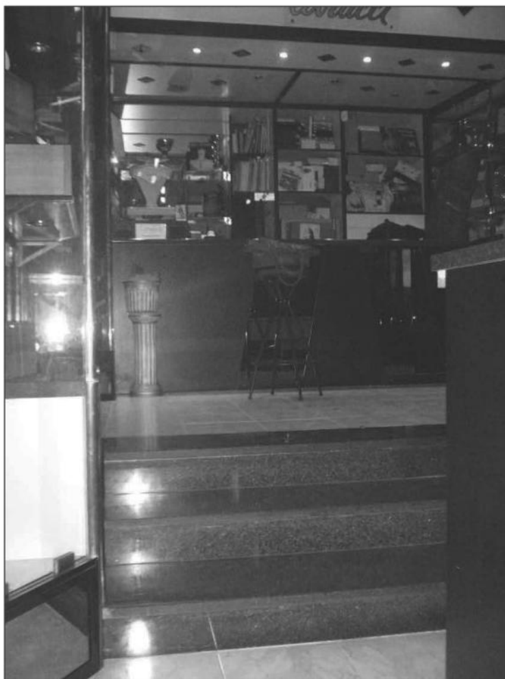
FOTO n. 15 – Il negozio di interesse è formato da un unico ampio vano originariamente diviso in due ambienti distinti e separati da una parete muraria divisoria attualmente rimossa e posizionata in corrispondenza degli attuali gradini interni esistenti, gradini che “ virtualmente ” possono essere considerati come il limite preesistente che definiva e divideva i predetti vani.
