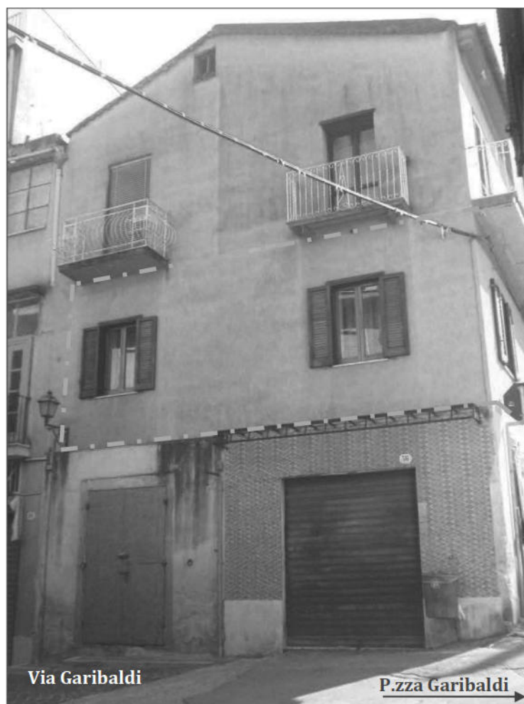
FOTO n. 2 – Vista da via Garibaldi del fabbricato al cui Primo Piano è ubicata l'u.i. identificata in catasto al Foglio 35, P.lla 453, Sub. 3 (evidenziazione in verde).
