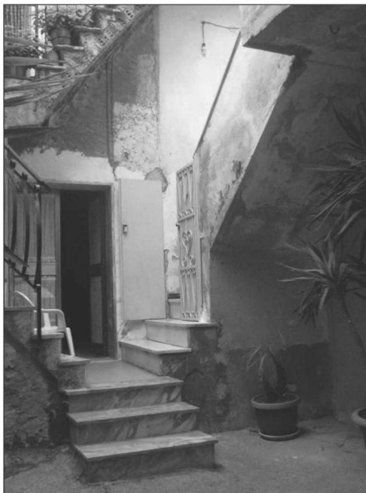
FOTO n. 16 – Particolare delle scale esterne presenti nell’atrio interno al fabbricato di cui alla P.lla 438, in parte di uso comune ed in parte ad uso esclusivo del debitore, che consentono l’accesso all’abitazione dal primo ingresso che immette direttamente nell’ambiente “Soggiorno” appartenente alla u.i. al Primo Piano di cui al Foglio 35, P.lla 438, Sub. 3.
