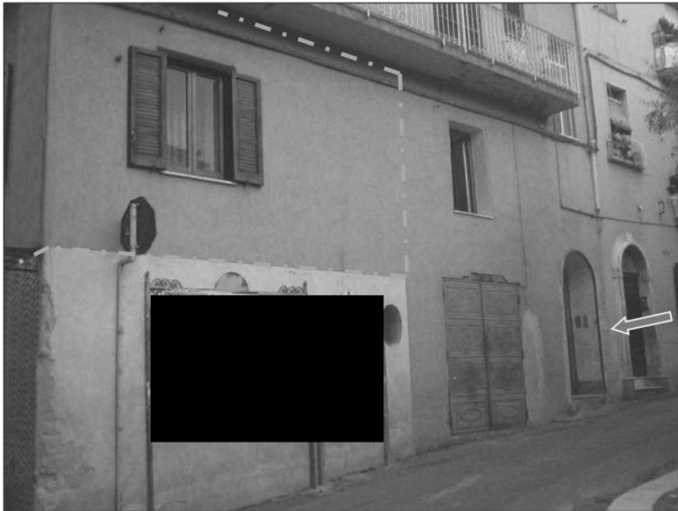
FOTO n. 3 – Altra vista da P.zza Garibaldi del fabbricato di interesse al cui Primo Piano è ubicata l'u.i. identificata in catasto al Foglio 35, P.lla 438, Sub. 3 (evidenziazione in verde). Con la freccia rossa è indicato l'ingresso comune dal quale è possibile accedere all'u.i. in argomento, che assieme a quelle identificate al Foglio 35, P.lla 453, Subb. 3 e 4 costituisce un'unica abitazione ad uso esclusivo del debitore.
