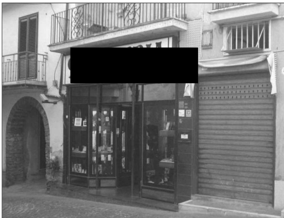
FOTO n. 4 – Il primo degli immobili di interesse è costituito da un Locale terraneo a destinazione commerciale adibito a gioielleria e ubicato in via G. Garibaldi (ex via Piazzile Chiesa) del Comune di Albanella (SA).
