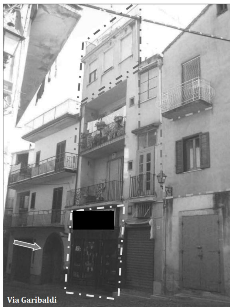
FOTO n. 1 – Vista da via Garibaldi dei fabbricati ove ubicate le u.i. di interesse. Evidenziata in giallo il Locale commerciale adibito a negozio identificato in catasto come U.I. SOPPRESSA di cui al Foglio 35, P.lla 438, Sub. 2; evidenziata in rosso l'abitazione identificata in catasto come U.I. SOPPRESSA di cui al Foglio 35, P.lla 438, Sub. 3; evidenziata in blu l'abitazione identificata in catasto al Foglio 35, P.lla 438, Sub. 4; evidenziata in verde parte dell'abitazione identificata in catasto al Foglio 35, P.lla 453, Sub. 3. La freccia rossa individua l'ingresso all'atrio interno al fabbricato di interesse che permette l'accesso alle abitazioni appena individuate e alla ulteriore u.i. di cui al Foglio 35, P.lla 438, Sub. 5.
