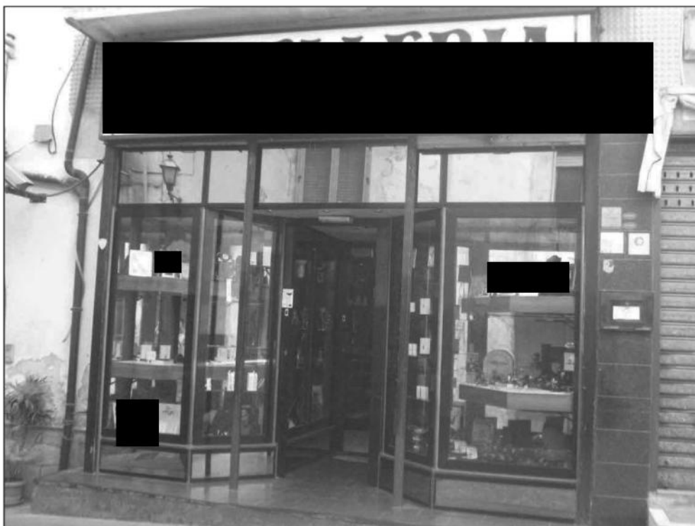
FOTO n. 6 – Vista, da via Garibaldi, dell'ingresso principale del locale commerciale di interesse con vetrine espositive poste direttamente sulla predetta via.
