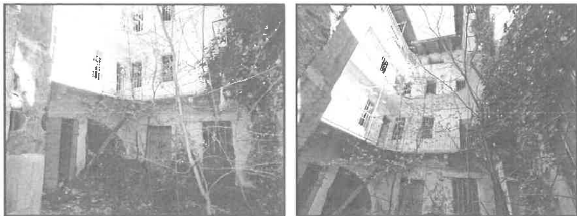
Foto 3 – 4 cortile del fabbricato principale e prospetto del fabbricato dal cortile
