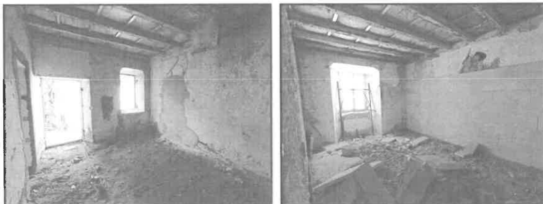
Foto 13 – 14 locali al piano primo
