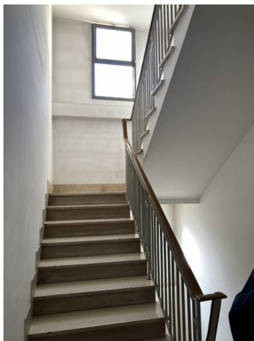
Foto 05 – Vano scala condominiale.
